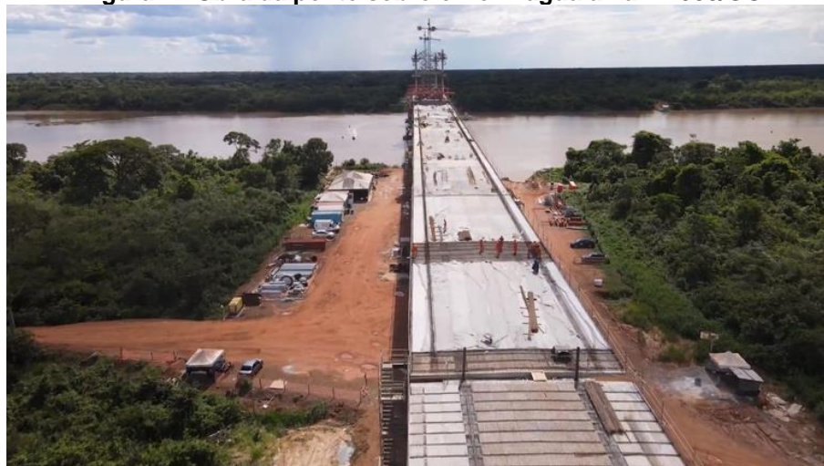
Figura 2 - Obra da ponte sobre o rio Araguaia na BR080/GO
