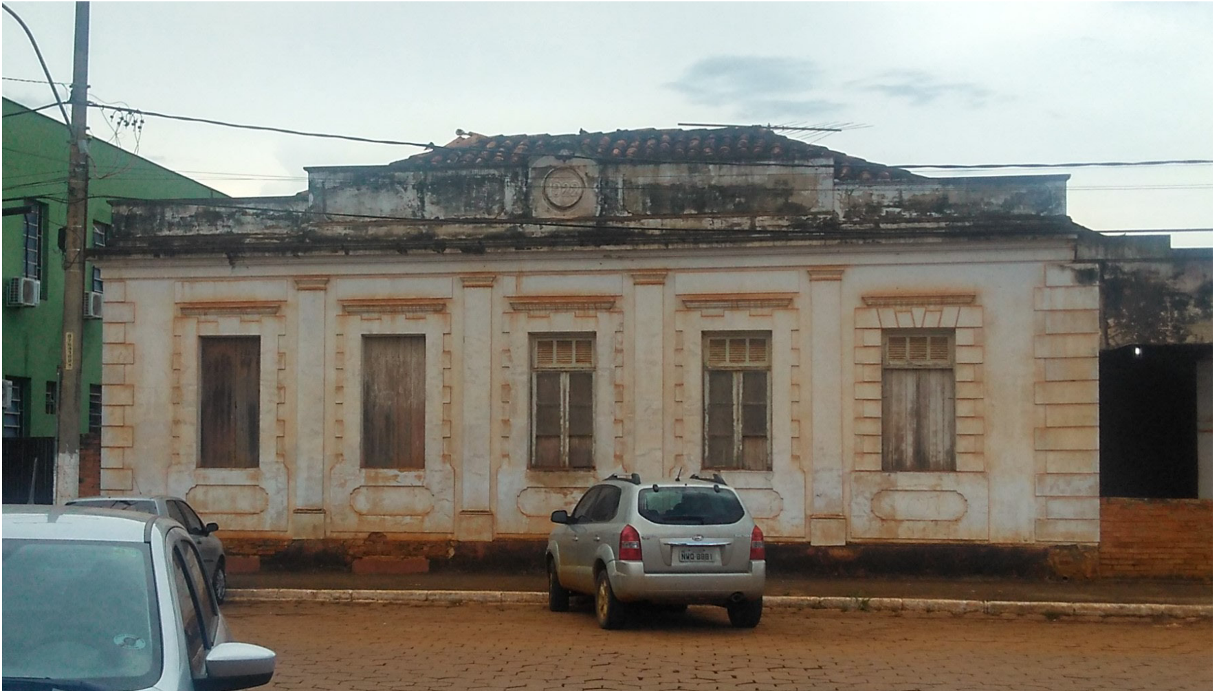
Casa Mirante no seu atual estado
