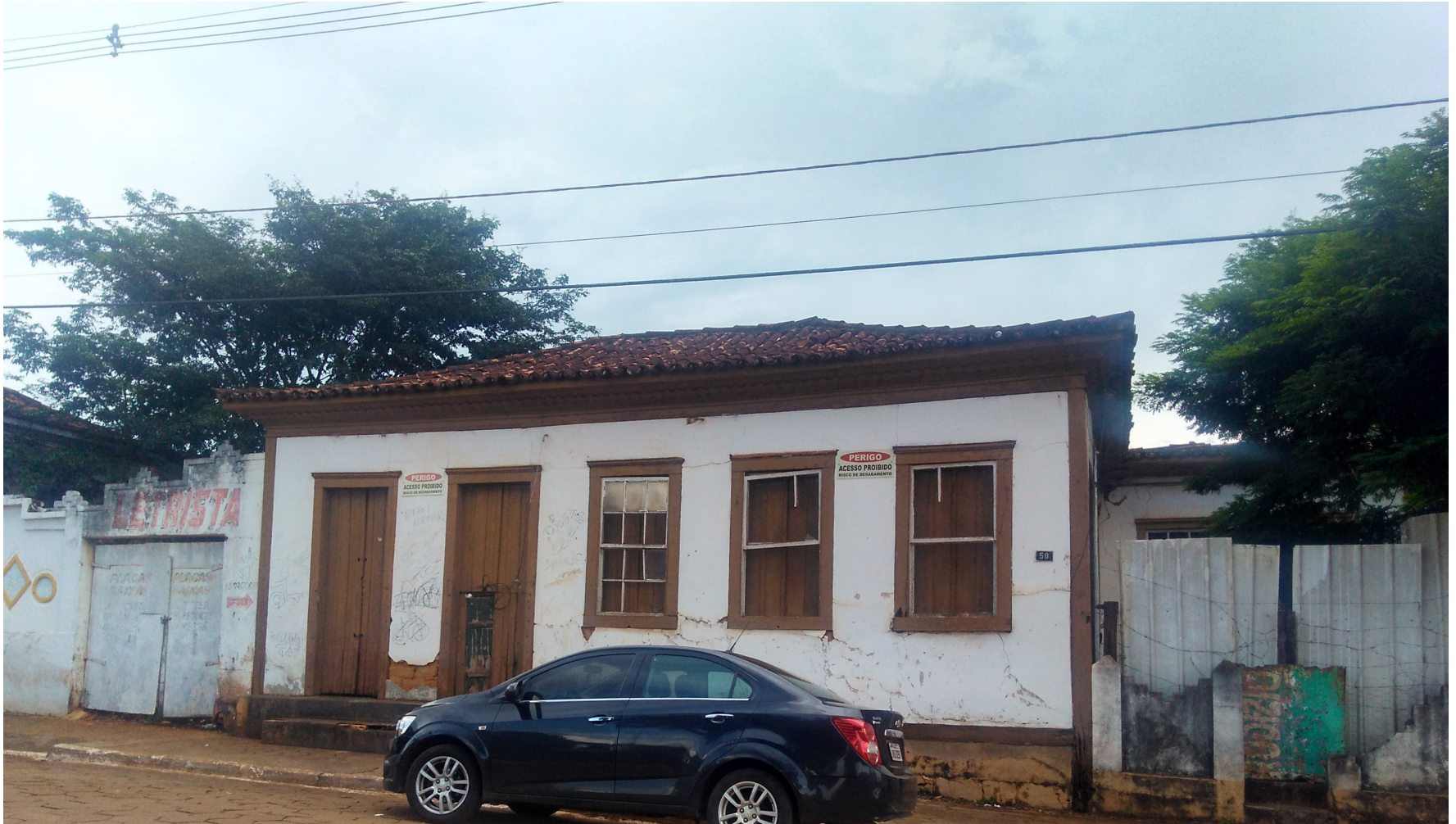
Casa Escola no seu atual estado
