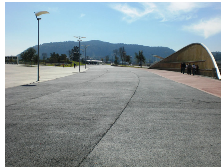
Estacionamento com pavimentação de ECOCRETO Ecológico Permeável
