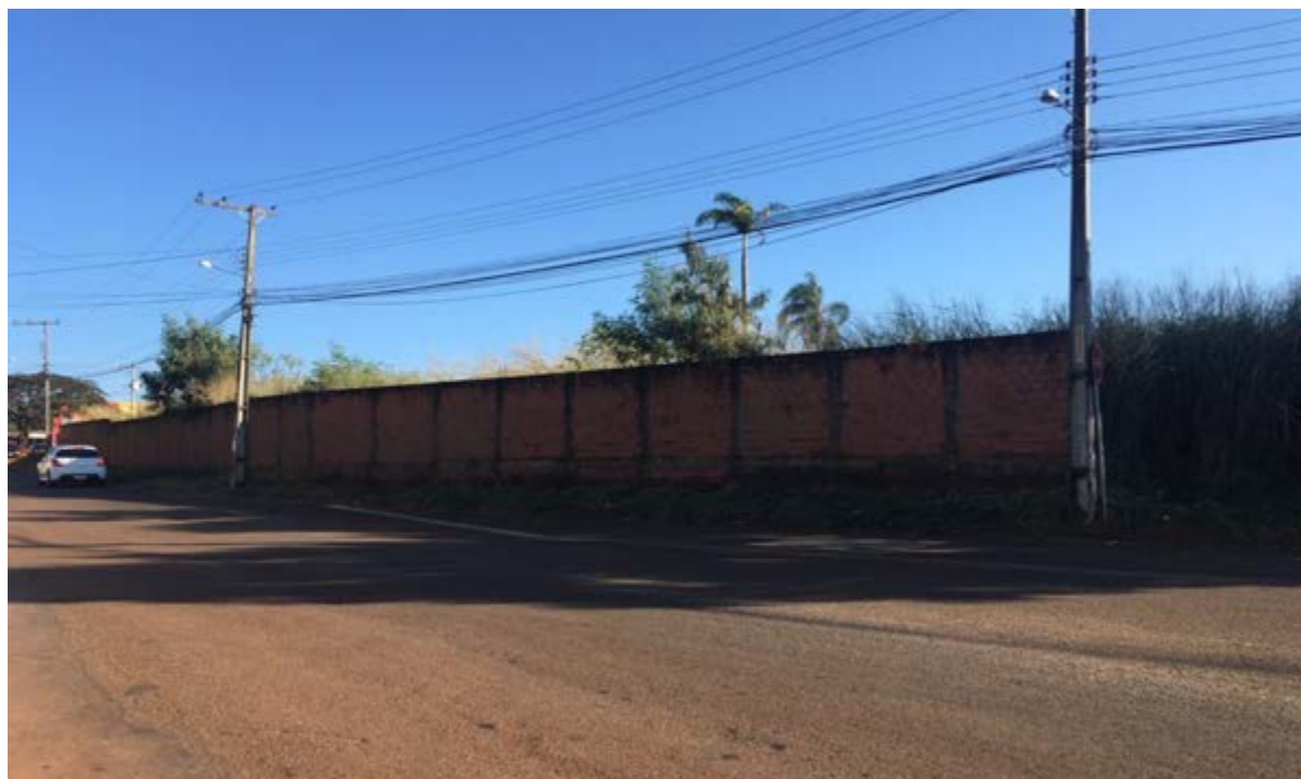
02 - Terreno visto da Av. Nova Capital Fonte: Autoral
