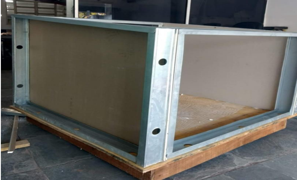
Figura 5 – Execução do protótipo de drywall
