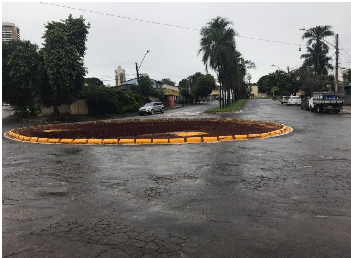
Figura 10 – Rotatória para instalação do Jardim de Chuva.
