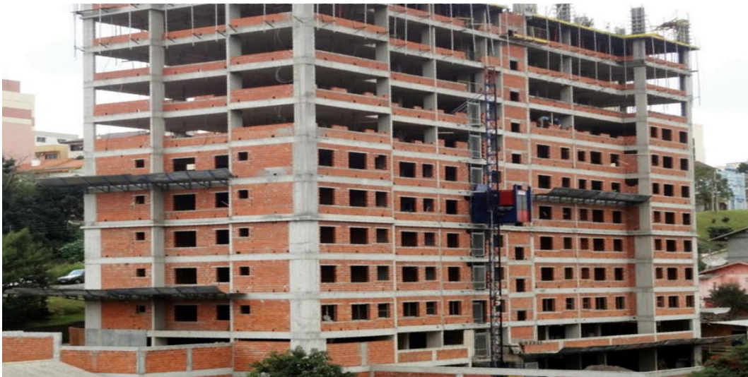
Figura 10 - Bloco cerâmico com finalidade de vedação
