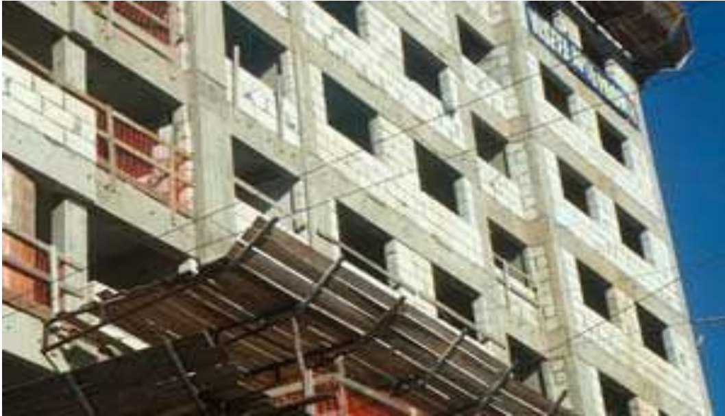
Figura 7 - Bloco de concreto com finalidade de vedação
