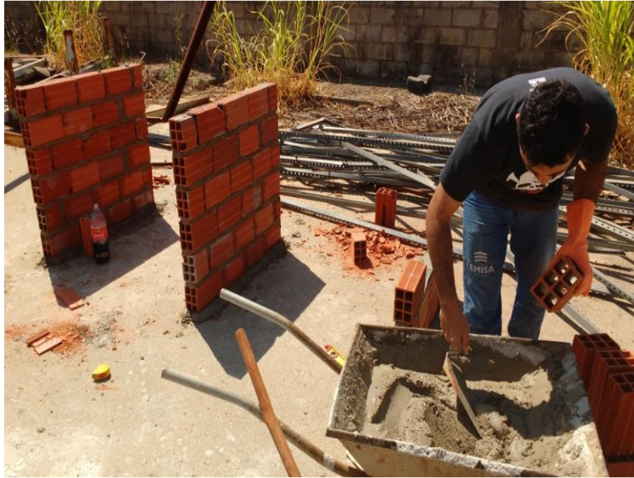
Figura 26 – Paredes sendo levantadas
