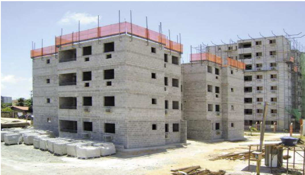
Figura 8 - Blocos de concreto com finalidade estrutural
