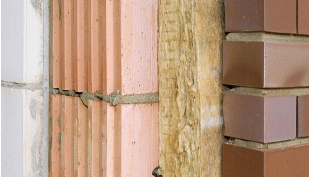
Figura 19 - Lã de vidro entre alvenaria de vedação
