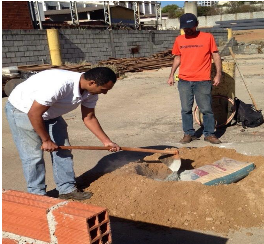
Figura 25 – Construção das paredes
