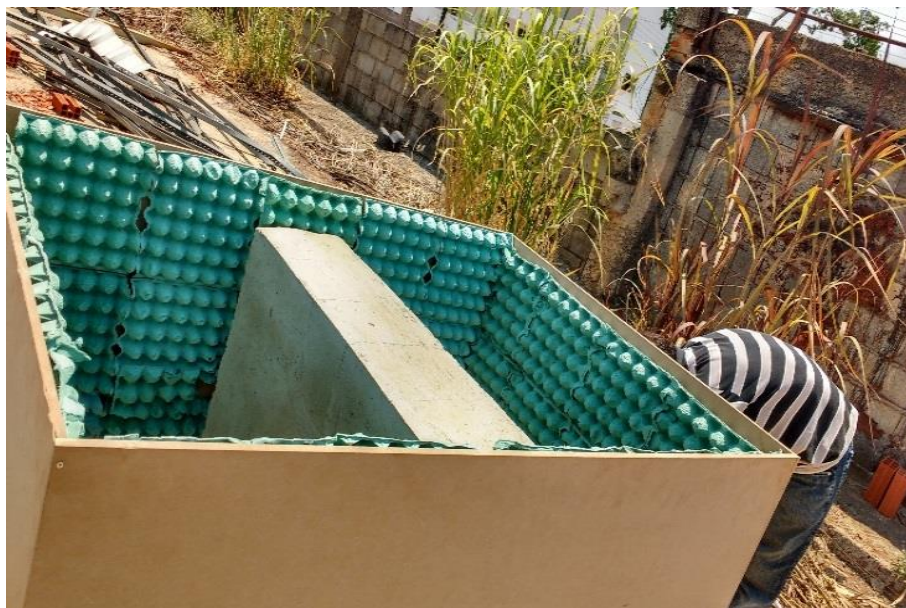
Figura 37 – Preparação da caixa acústica nas paredes
