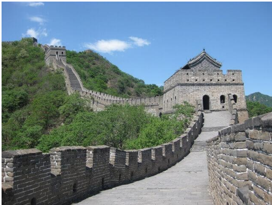
Figura 4 - Muralha da China
