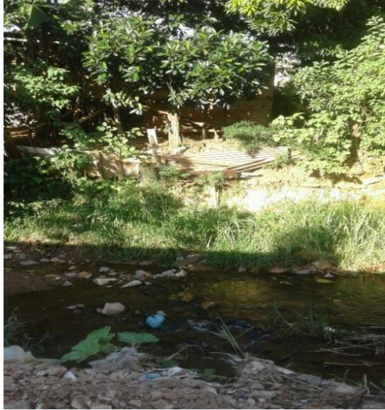
Imagem 9 – Muro improvisado, lixo e entulhos
