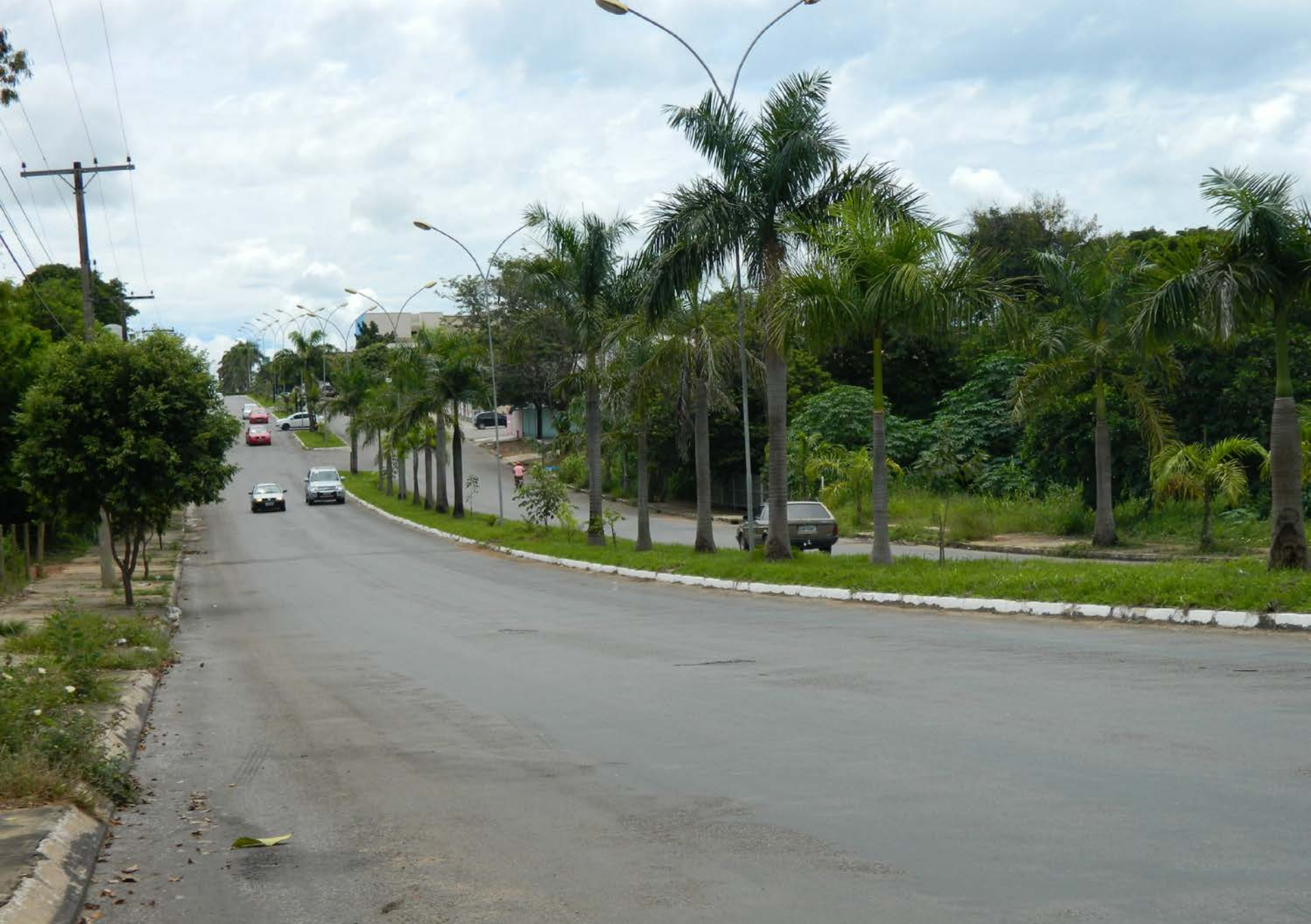
Avenida Brasil (trecho sobre córrego portal) - Goianésia Fonte: Guilherme Morais, 2017
