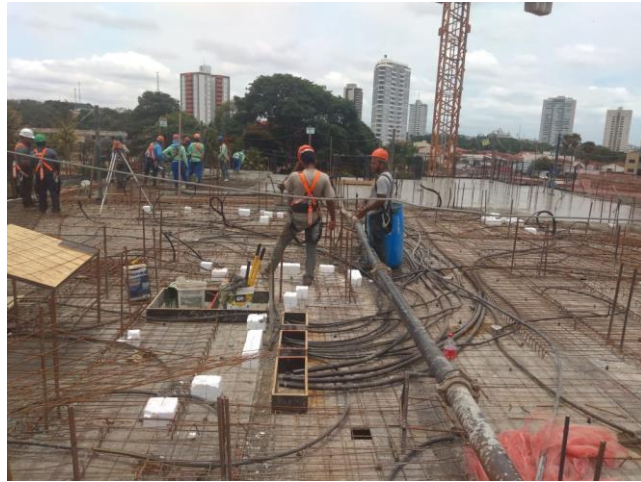
Figura 6 – Concretagem
