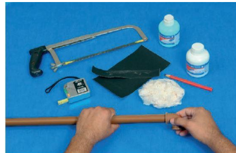
d) Encaixar as extremidades a serem soldadas
