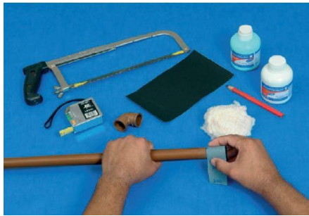
a) Lixar a superfície do tubo a ser soldada
