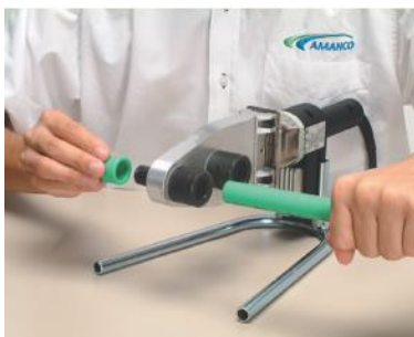
e) Colocação da peça no termofusor
