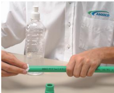
c) Limpeza dos tubos e conexões
