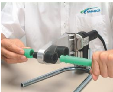
g) Retirada da peça do termofusor
