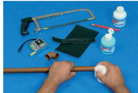
b) Limpar a superfície lixada
