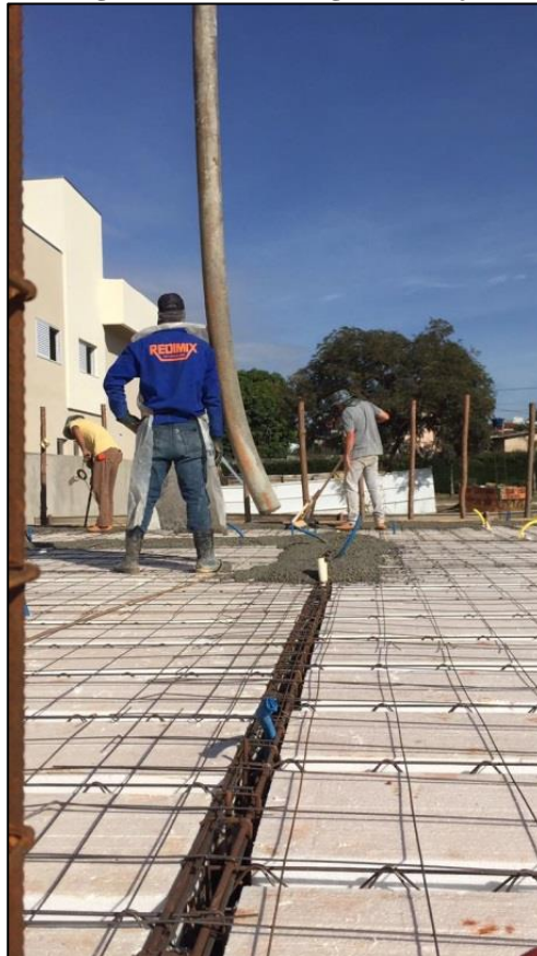
Figura 16 - Concretagem da Laje
