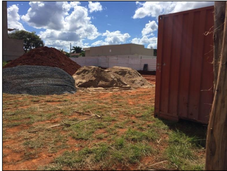
Figura 8- Etapa preliminar concluída
