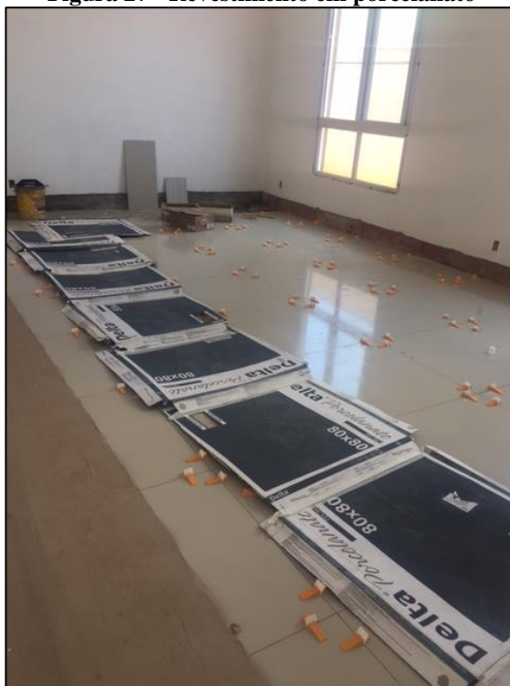
Figura 27 - Revestimento em porcelanato
