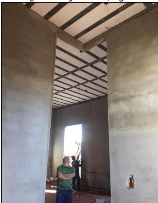
Figura 22 - Viga invertida, ângulo 1
