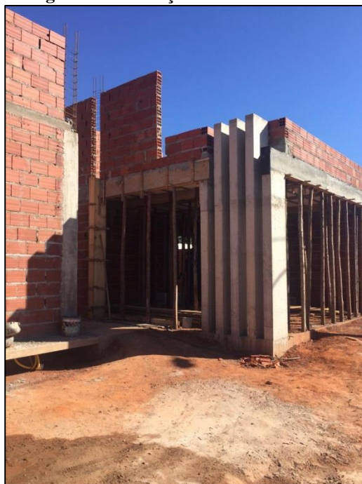
Figura 15- Execução Alvenaria externa
