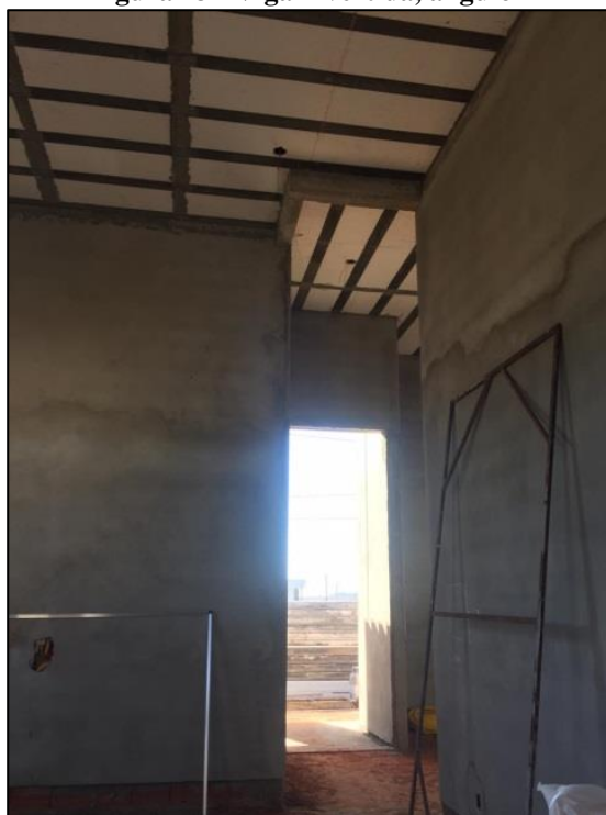
Figura 23 - Viga invertida, ângulo 2
