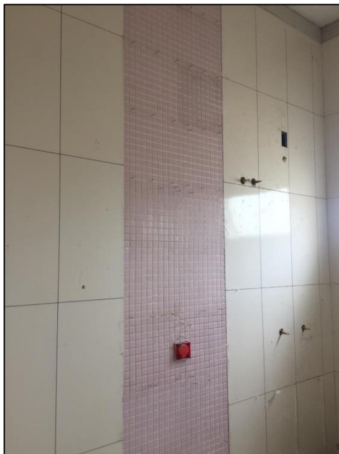
Figura 20- Assentamento de revestimento na suíte 01
