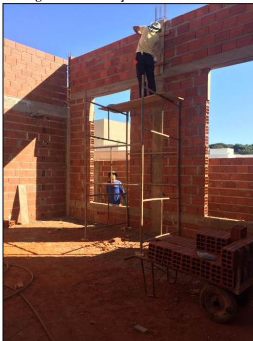
Figura 14- Execução alvenaria interna
