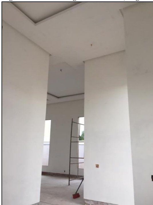
Figura 24 - Forro em gesso finalizado, ângulo 1
