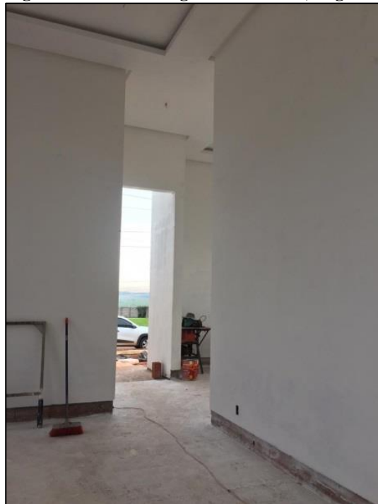
Figura 25 - Forro em gesso finalizado, ângulo 2
