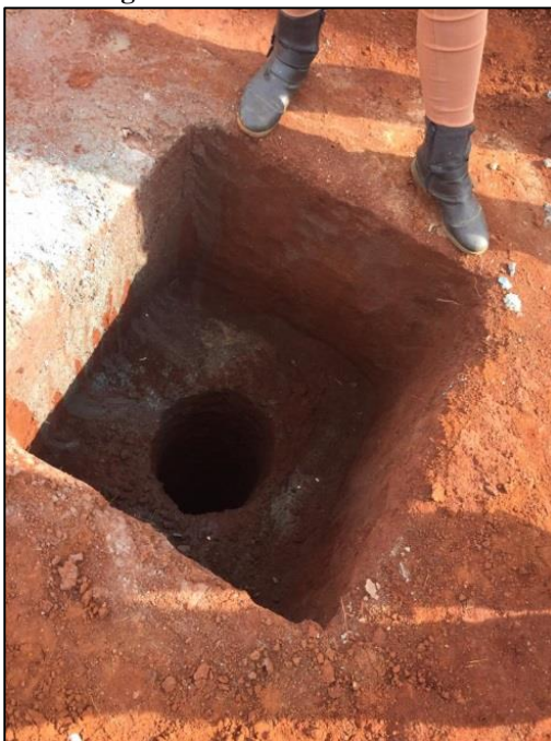
Figura 11 - Bloco sobre estaca
