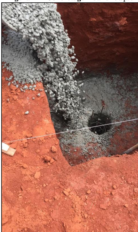
Figura 12 - Concretagem da fundação
