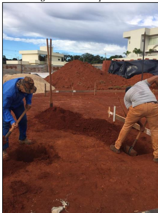
Figura 10- Escavação manual
