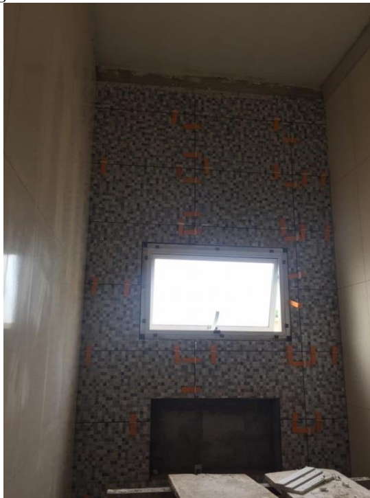
Figura 21 - Assentamento do revestimento na suíte 02
