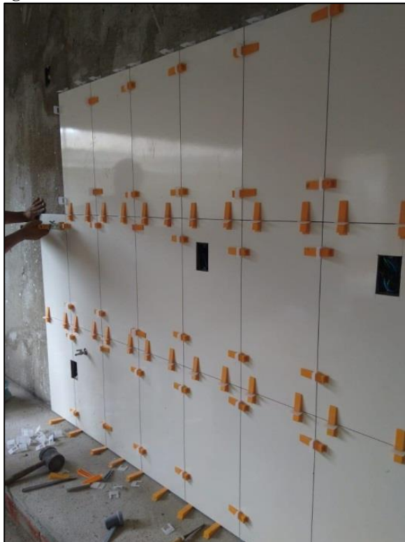
Figura 18 - Assentamento de revestimento na cozinha
