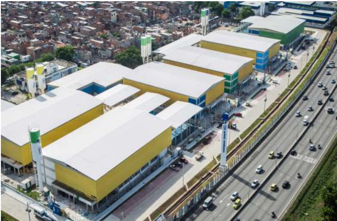
Figura 5 - Campus Educacional Maré finalizado
