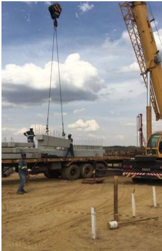
Figura 11 - Manuseio de peças pré-fabricadas
