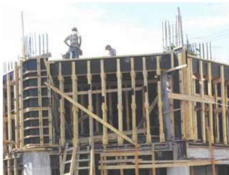
Figura 20 - Exemplo sistema de fôrmas
