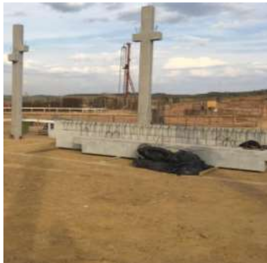
Figura 13 - Armazenamento de peças pré-fabricadas
