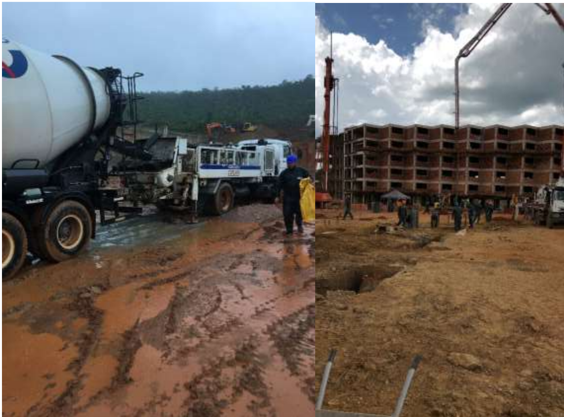
Figura 30 - Bomba estacionária e bomba lança
