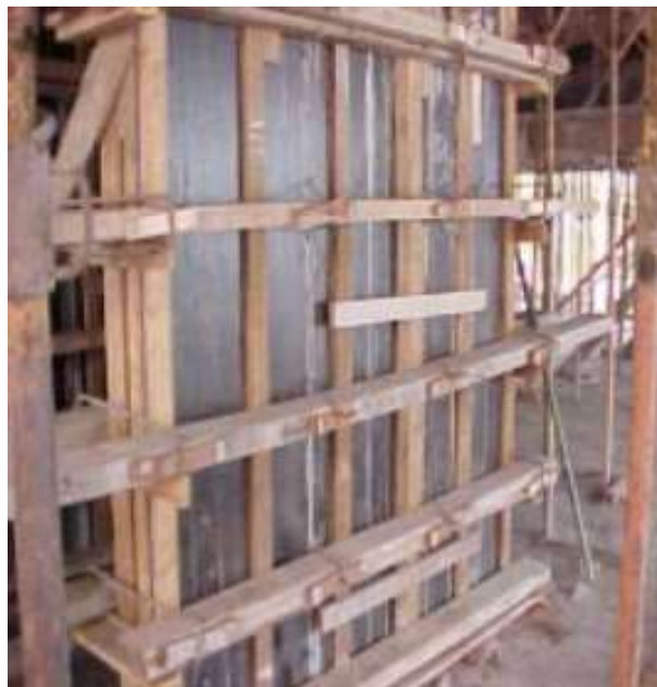
Figura 21 - Trama de pilar
