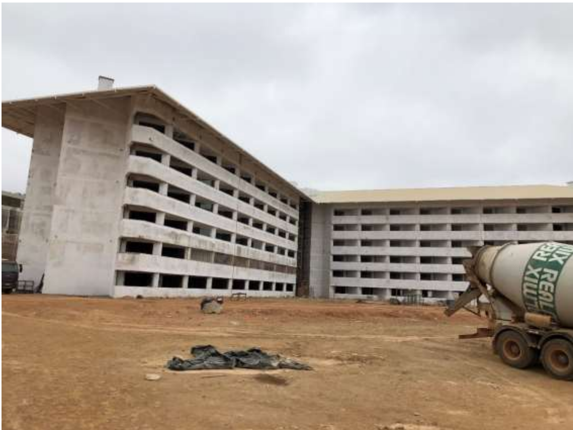
Figura 32 - Estrutura do prédio apartamento finalizada
