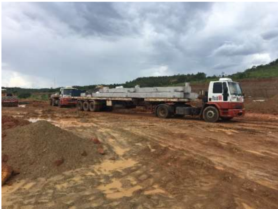
Figura 10 - Caminhão para transporte de peça pré-fabricada
