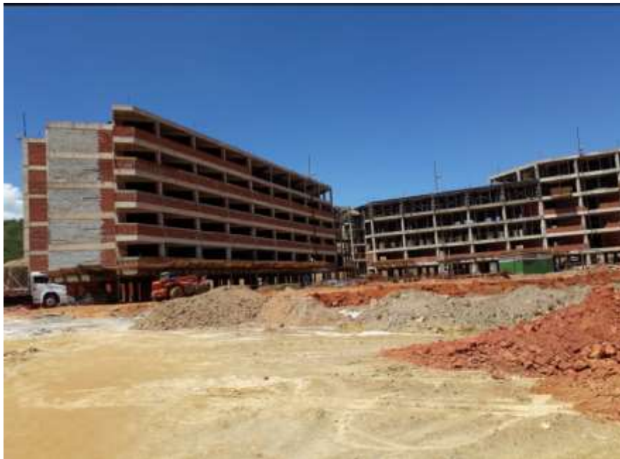
Figura 28 - Prédio apartamentos totalmente moldados in loco
