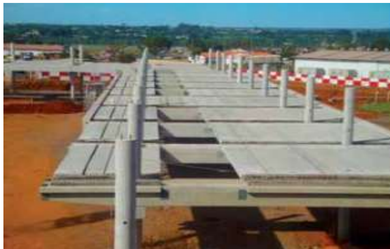
Figura 6 - Execução da ampliação aeroporto de Brasília
