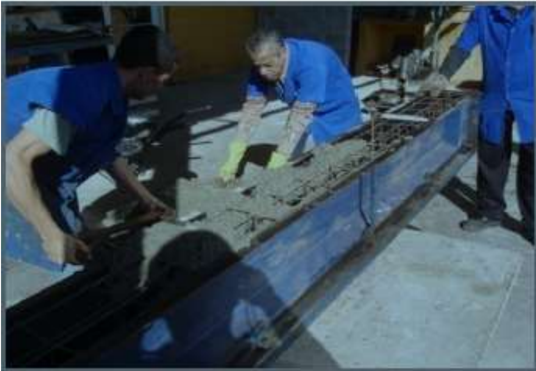
Figura 9 - Fôrma metálica para pré-fabricados
