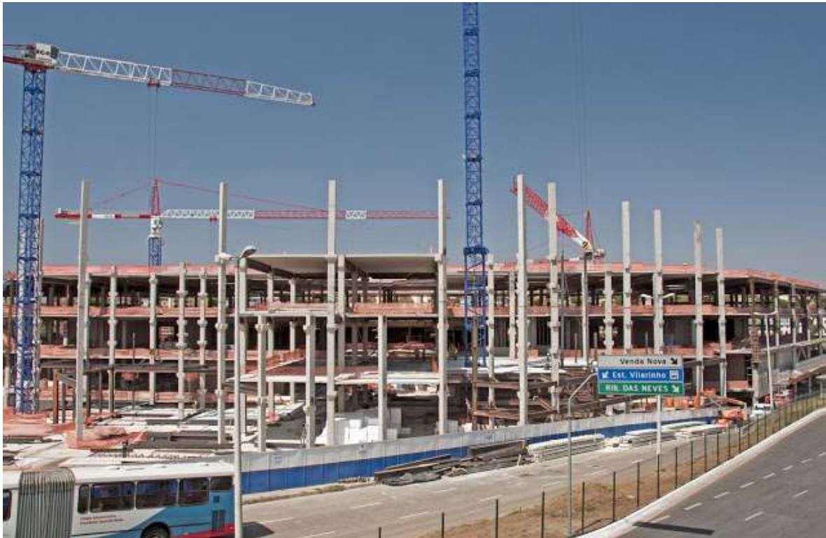
Figura 15 - Construção do Shopping Estação e da Estação Vilarinho
