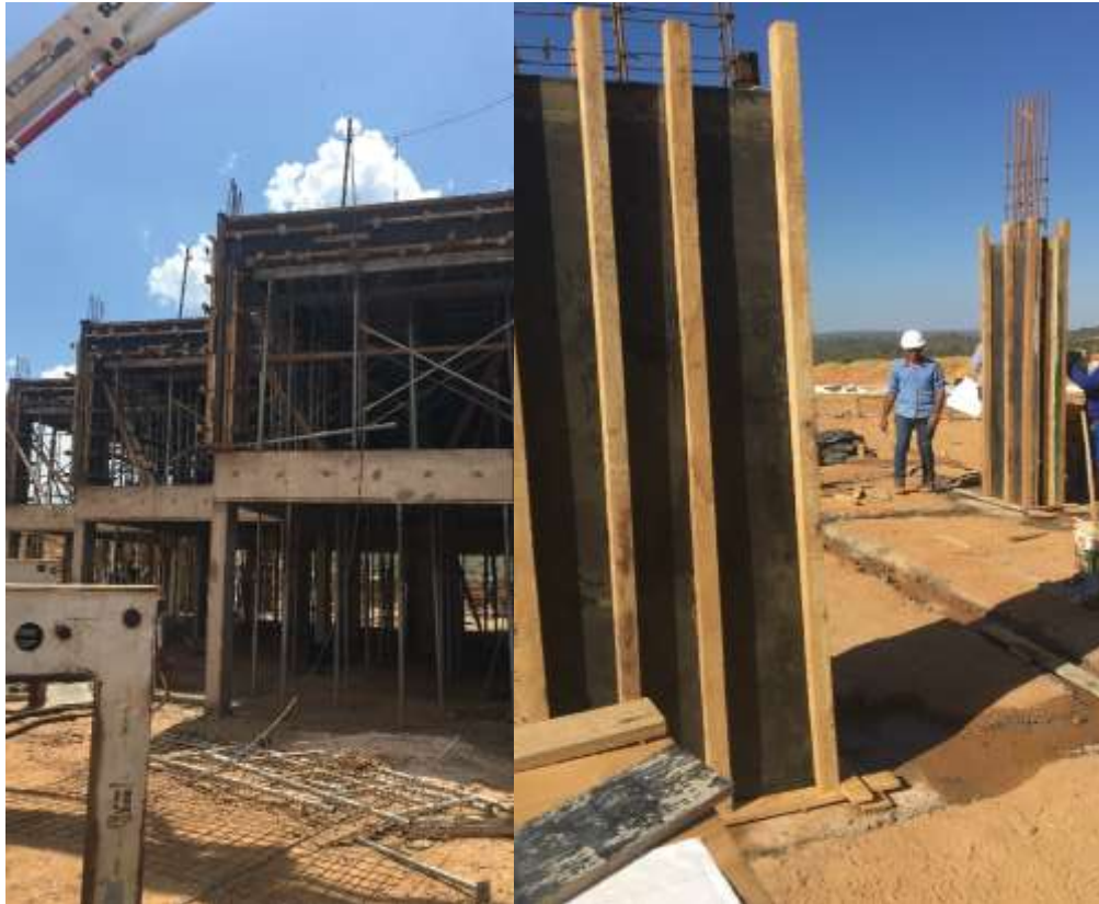
Figura 29 - Fôrmas e travamentos dos pilares, vigas e laje
