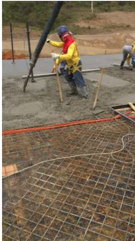
Figura 26 - Concretagem com bomba-lança
