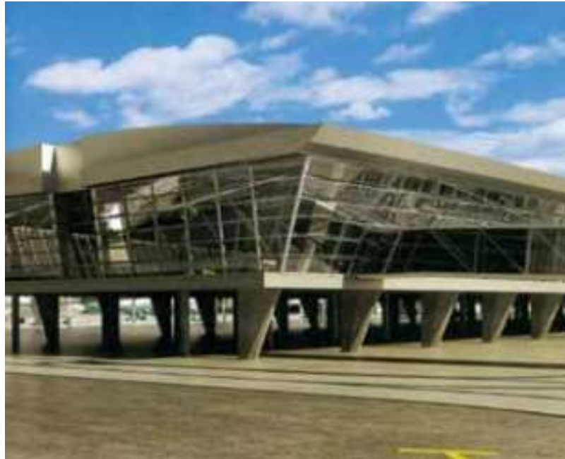
Figura 7 - Obra da ampliação aeroporto de Brasília finalizada
