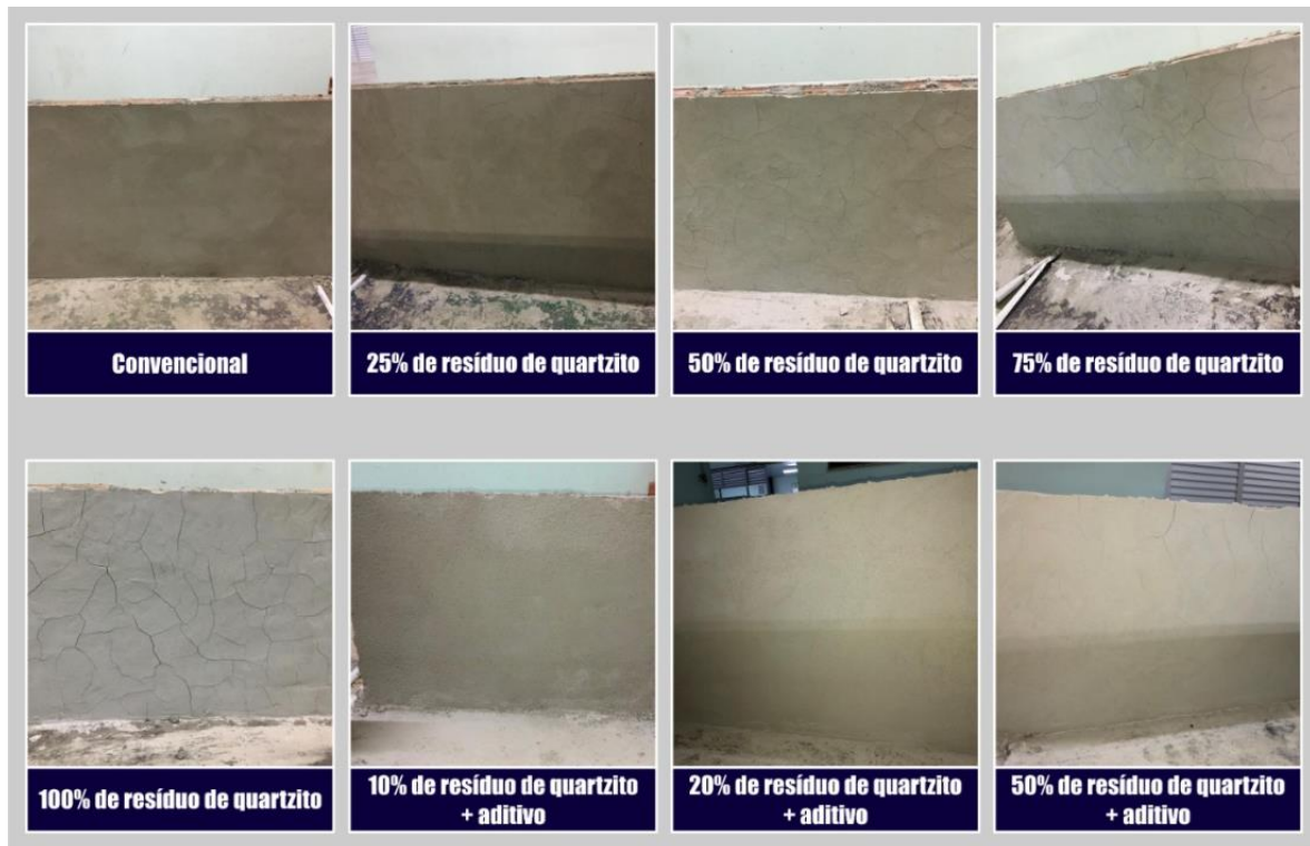
Figura 19- Aspectos visuais do revestimento com 28 dias
