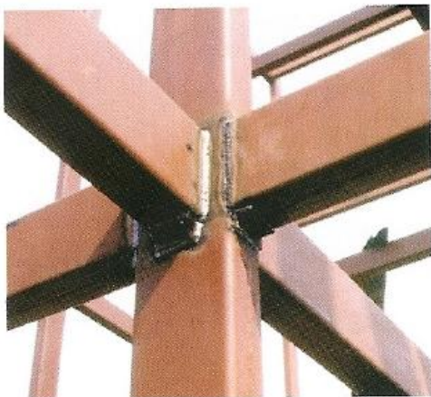
Figura 15- Conexão soldada rígida na aba do pilar Figura 16- Conexão rígida da viga na alma do pilar
