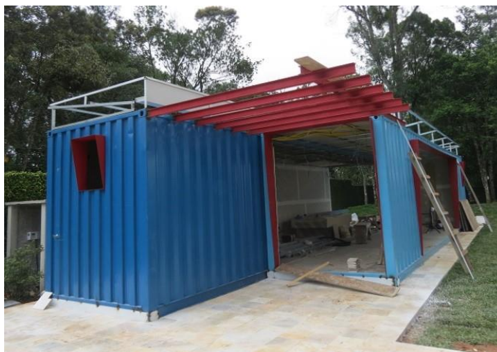
Figura 11 - Construção de contêiner em laje radier
