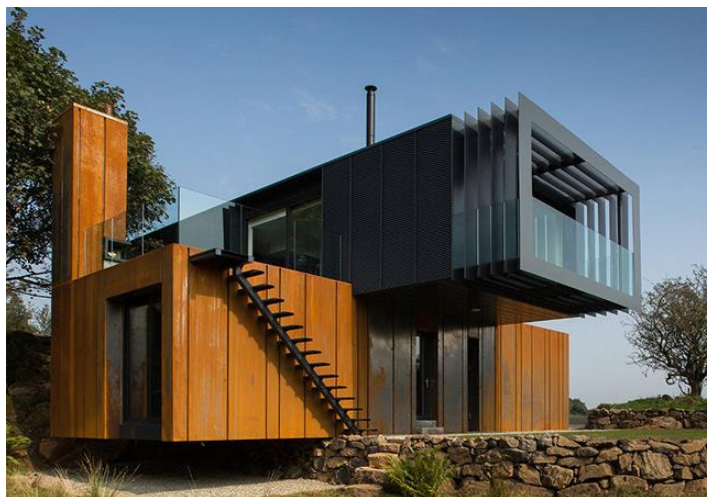
Figura 20 - Acabamento externo em madeira e pintura
