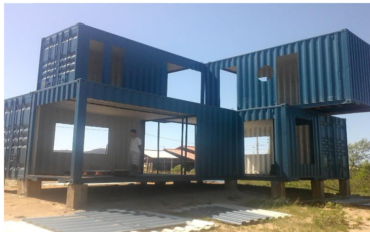
Figura 13 - Construção de contêiner em sapata isolada
