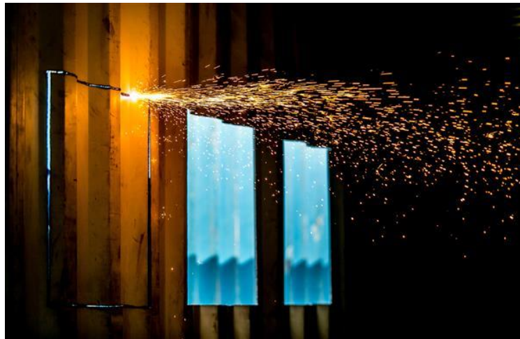
Figura 9 - Abertura de vãos no aço corrugado
