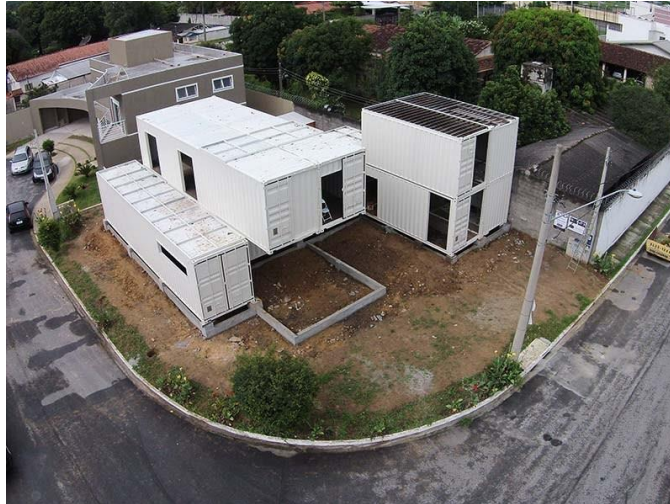
Figura 12 - Construção de contêiner em viga baldrame
