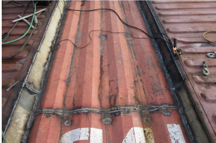
Figura 14 - Soldagem das ligações dos módulos
