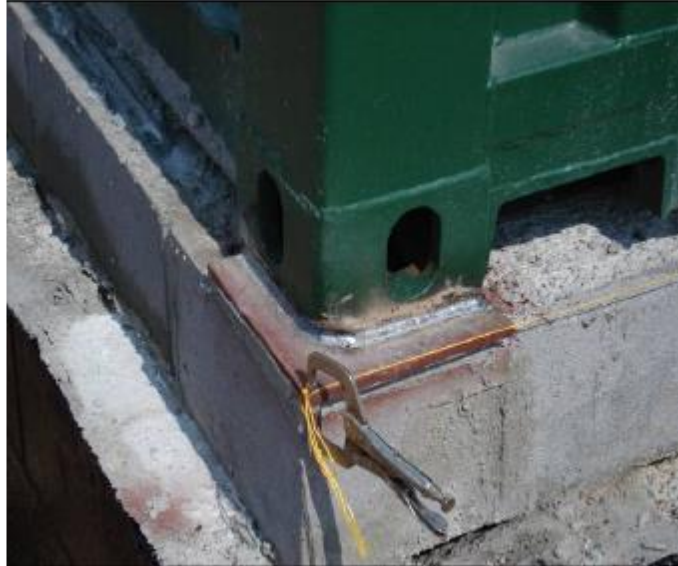
Figura 16 - Ligação do contêiner com a fundação
