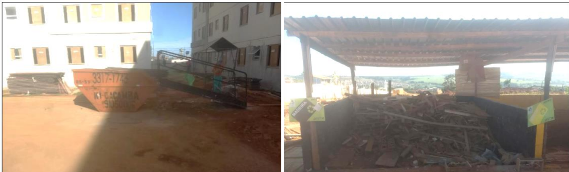
Figura 6 – Tipos de acondicionamento de RCC na obra B
