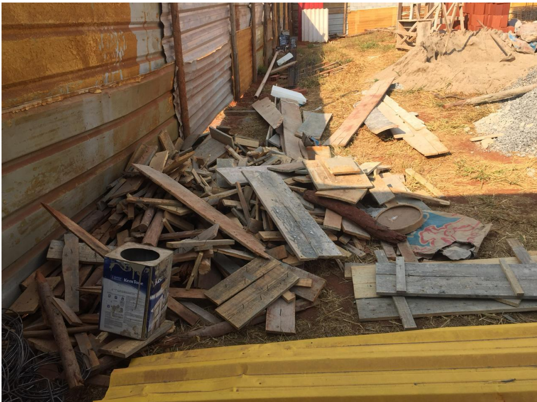
Figura 8 – Separação de madeira dos demais resíduos (Obra C)
