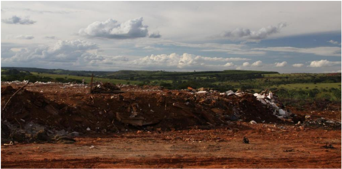
Figura 2 – RCC espalhado e compactado no aterro sanitário de Anápolis
