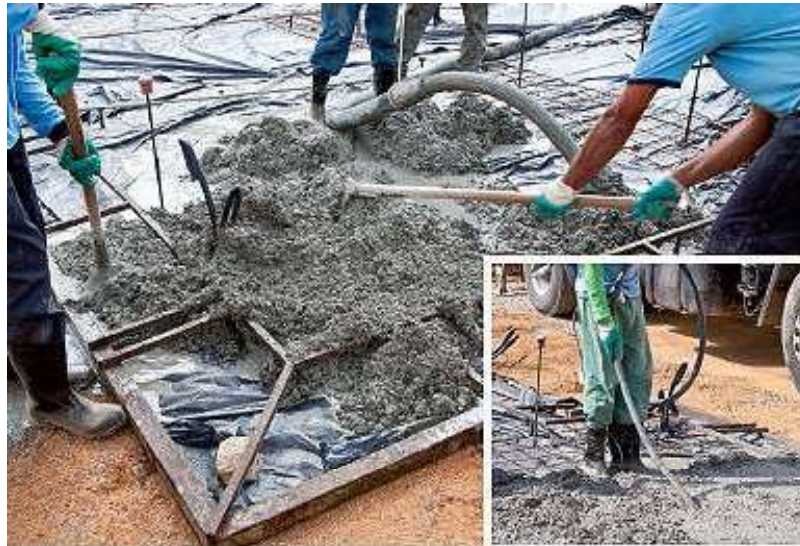
Figura 19 - Lançamento e adensamento do concreto
