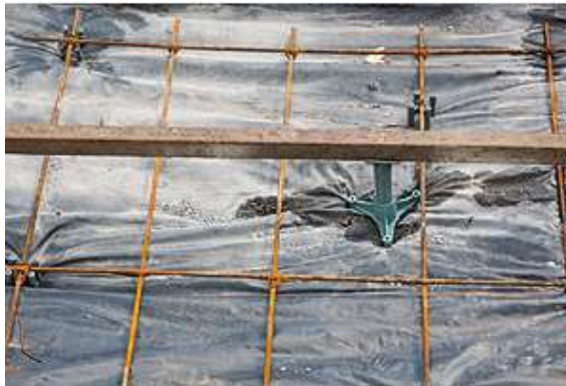
Figura 18 - Colocação da armadura e espaçadores
