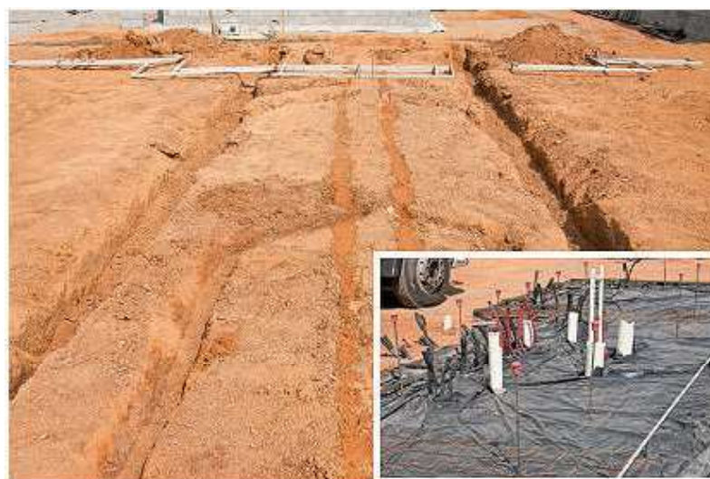
Figura 17 - Cortes no solo para passagem das tubulações
