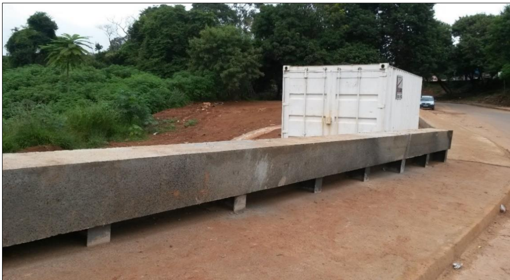
Figura 11 – Obra para contenção da erosão / Março
