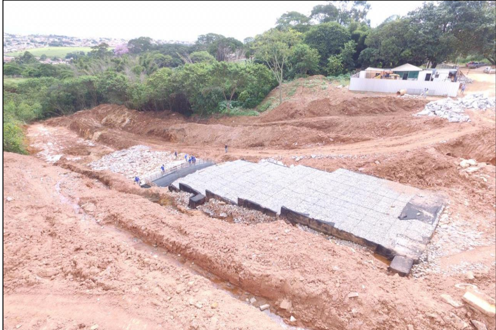
Figura 22 – Vista lateral do gabião
