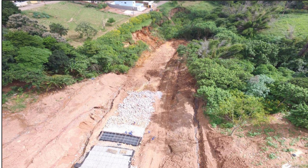
Figura 24 – Trecho do gabião
