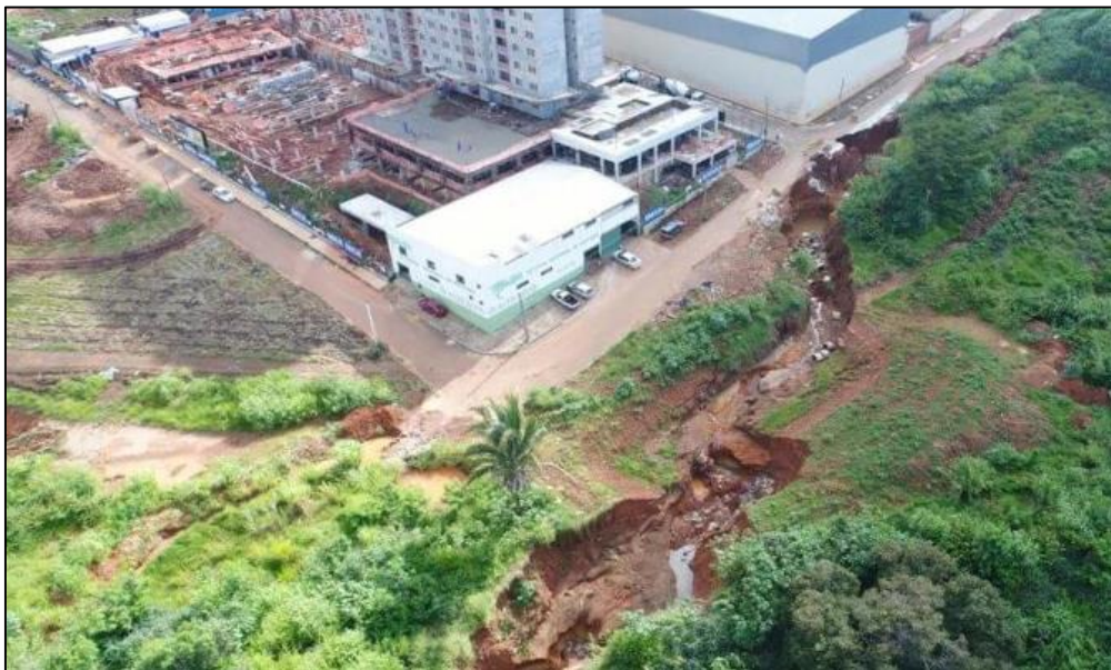
Figura 6 – Erosão na Cidade Jardim
