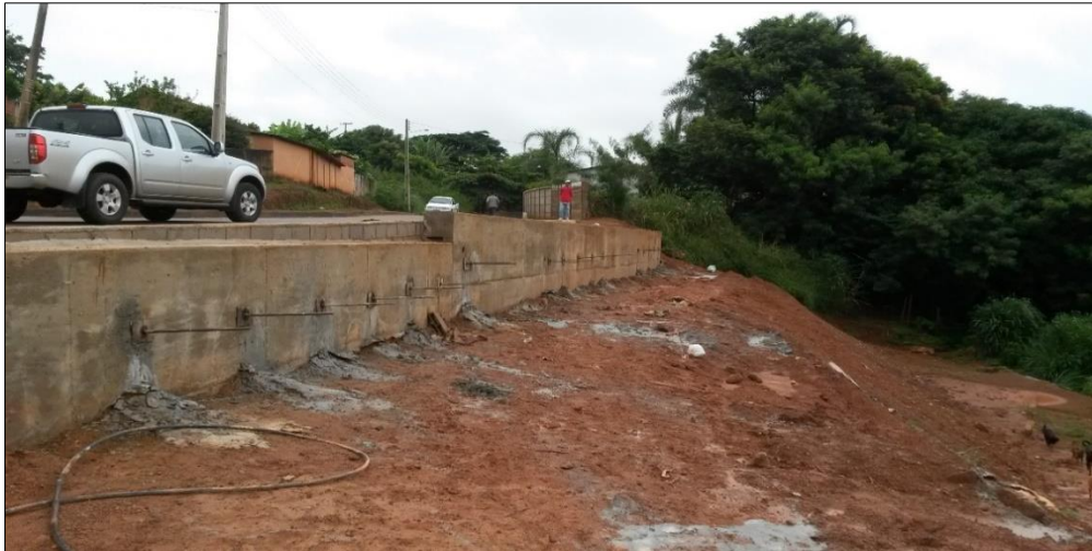
Figura 10 – Obra para contenção da erosão / Fevereiro
