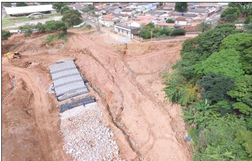
Figura 23 – Vista superior do gabião
