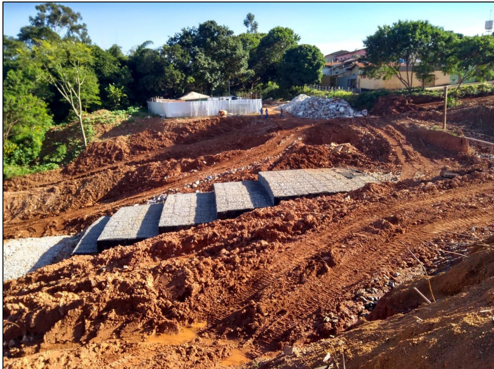
Figura 21 – Execução do gabião
