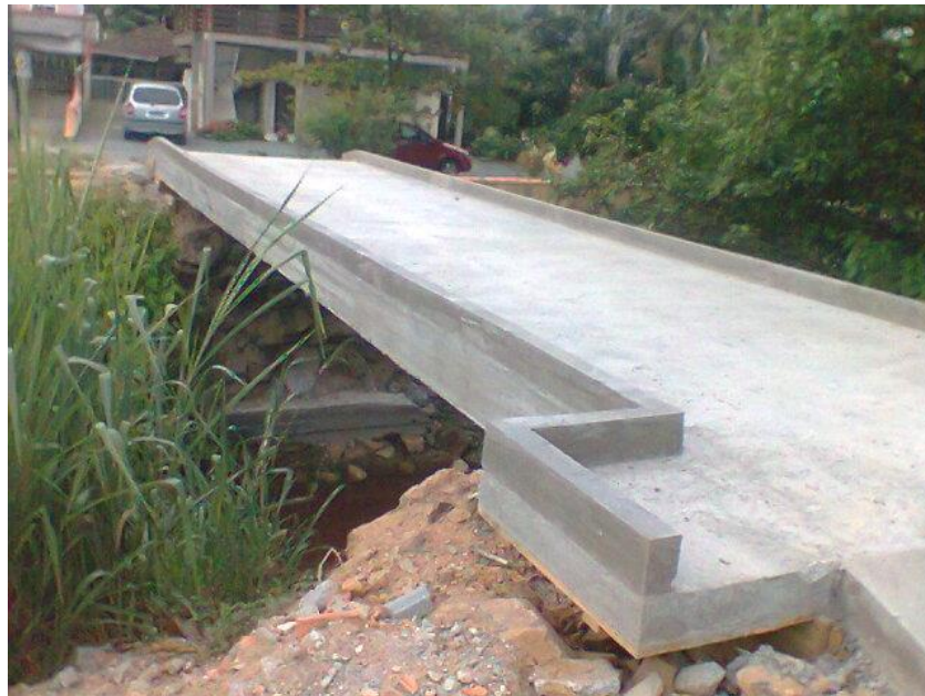
Figura 2 - Ponte em Laje
