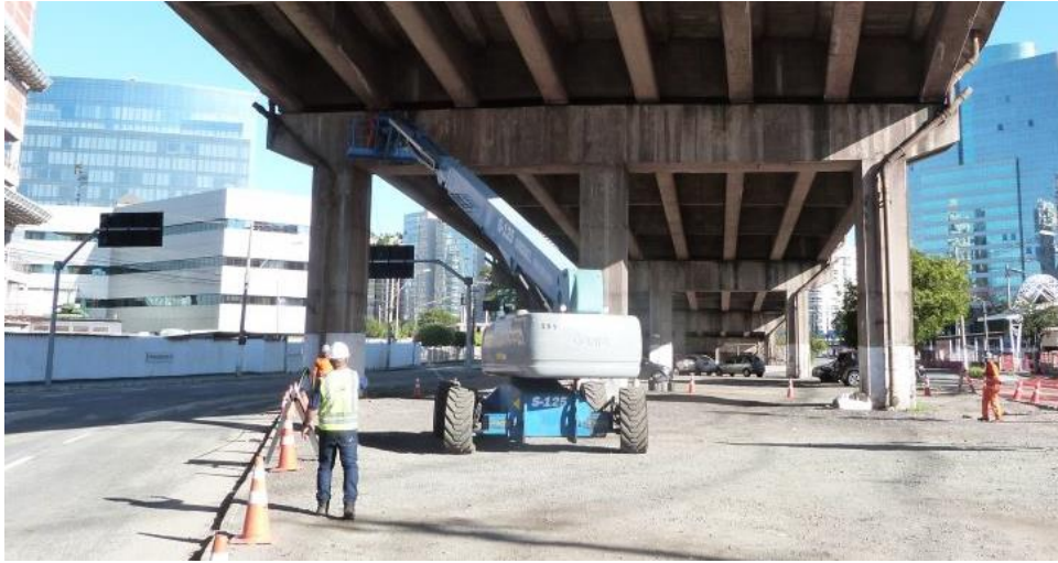
Figura 19 – Manutenção em viaduto com plataforma Elevatória.
