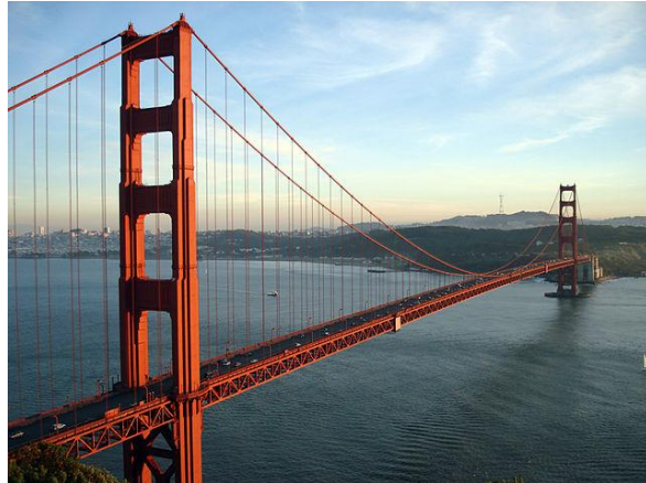
Figura 6 - Ponte Golden Gate
