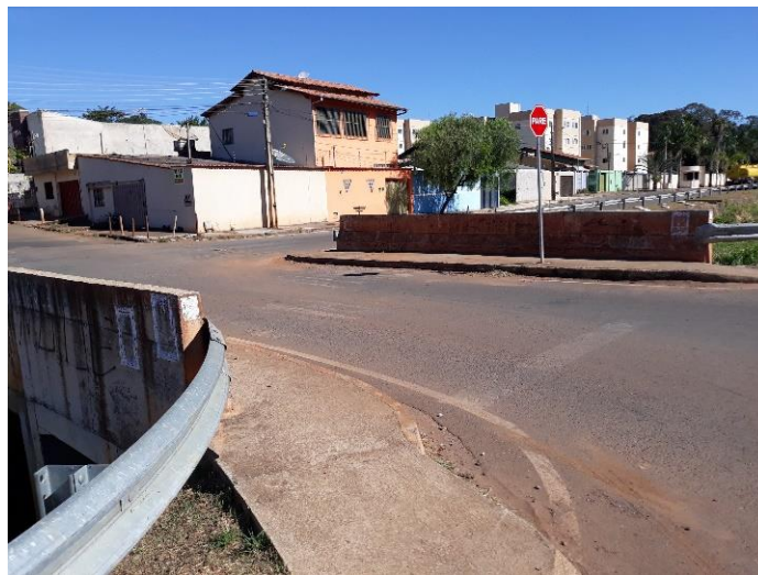
Figura 15 - Barreira Rígida / Defesa Metálica
