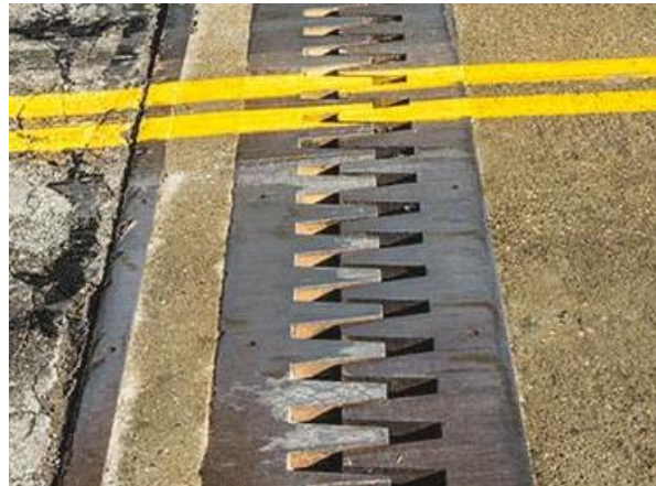
Figura 11 - Junta de Dilatação - Encontro superior
