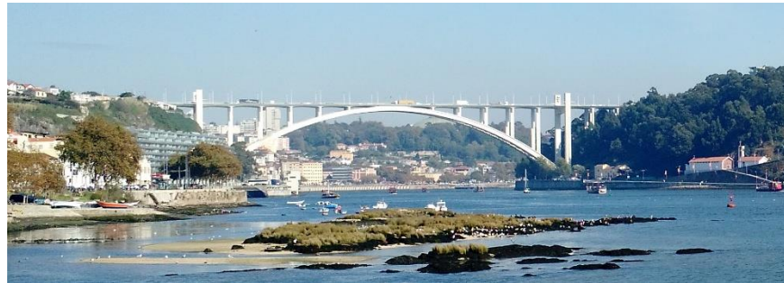
Figura 5 - Ponte da Arrábida do tipo em arco
