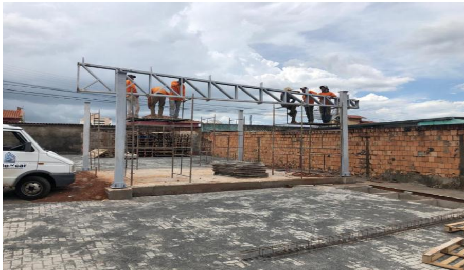
Figura 1: Montagem da estrutura metálica
