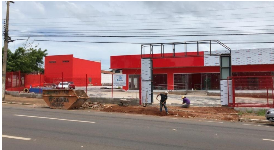
Figura 4: Instalação da comunicação visual: ACM ( Aluminum Composite Material )
