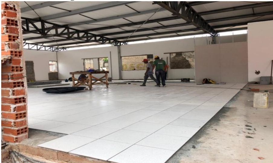
Figura 3: Assentamento de cerâmica
