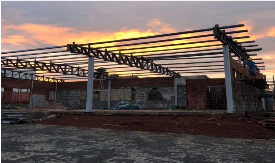
Figura 2: Montagem de terçamento
