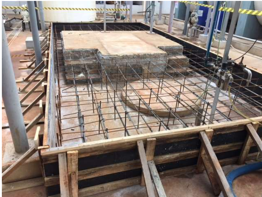
Figura 11 – Acompanhamento etapa de obra civil
