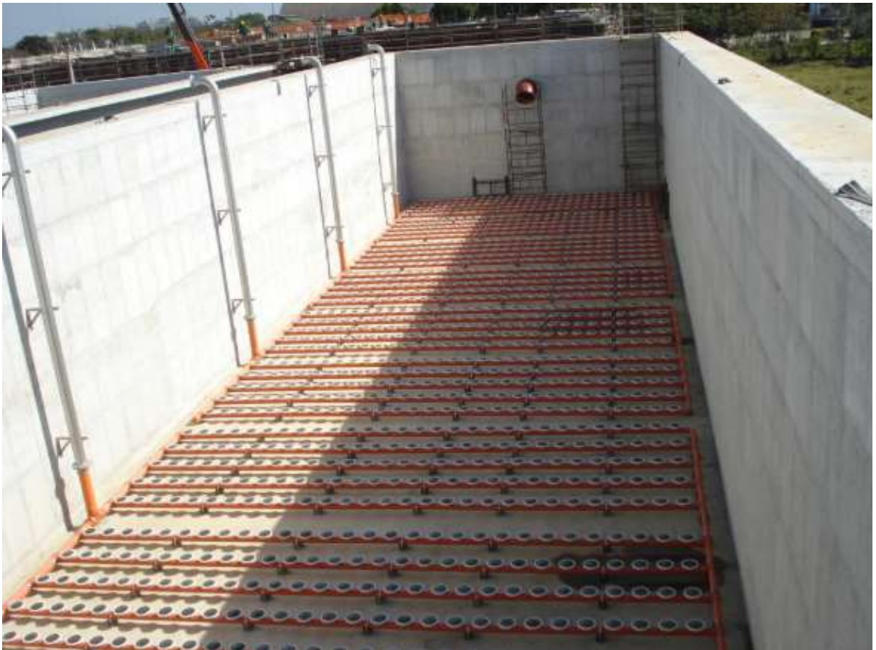
Figura 6 - Sistema difusor de ar de discos para tanque de aeração
