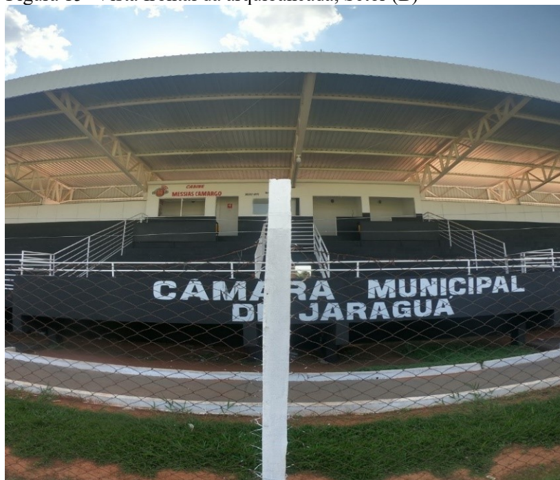
Figura 15- Vista frontal da arquibancada, Setor (B)
