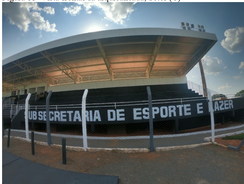
Figura 16- Vista frontal da arquibancada, Setor (C)
