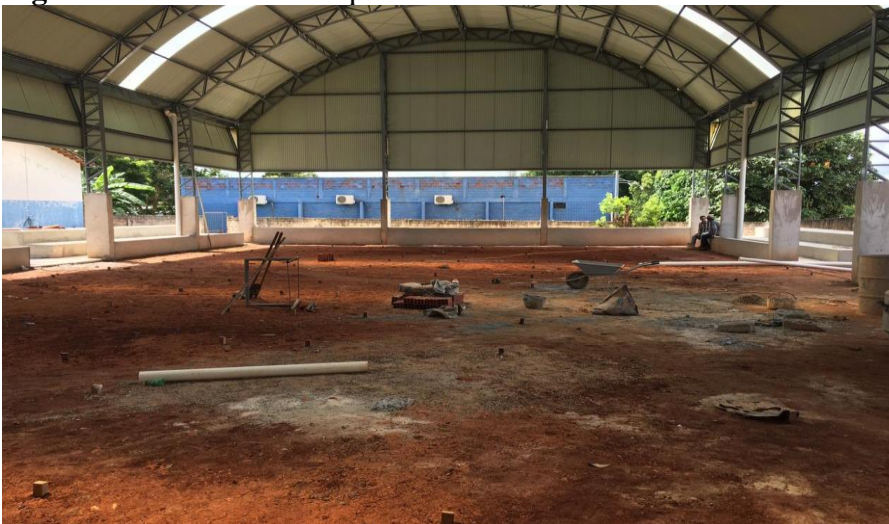
Figura 4. Área interna da quadra.
