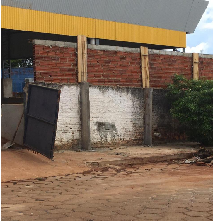
Figura 8. Elevação e reforço do muro de alvenaria.
