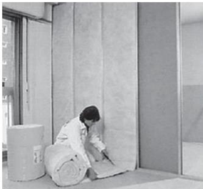
Figura 21: Instalação de lã de vidro em painel.
