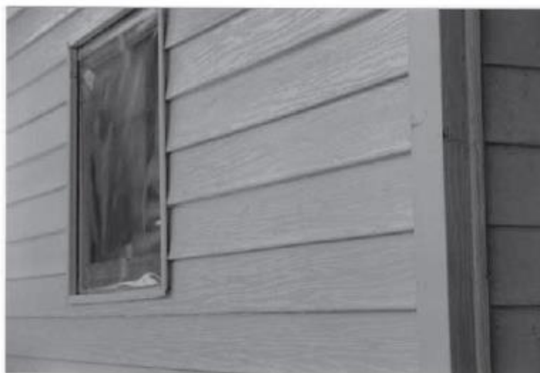
Figura 19: Revestimento externo com “Siding” vinílico.
