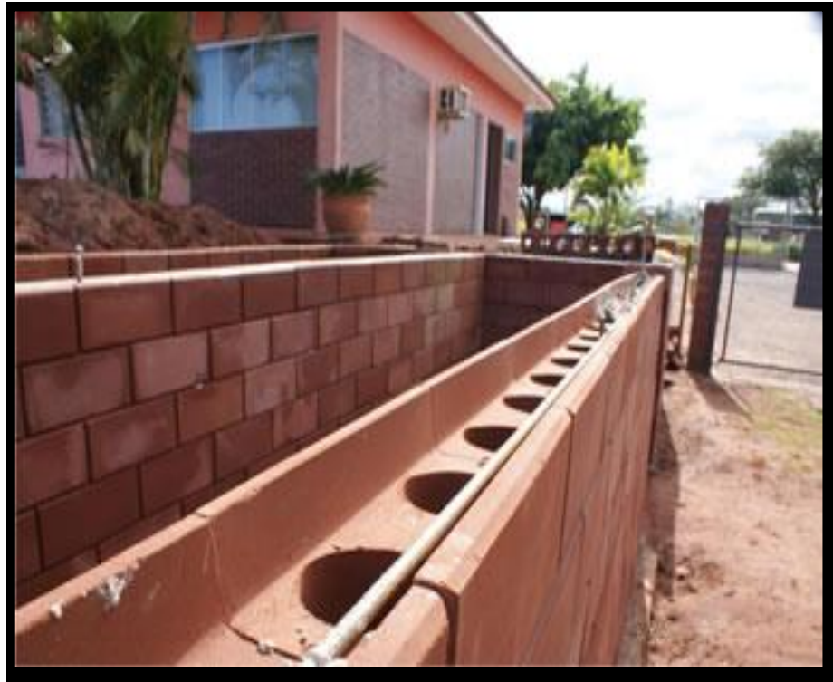
Figura 13 - Canaletas instaladas em parede
