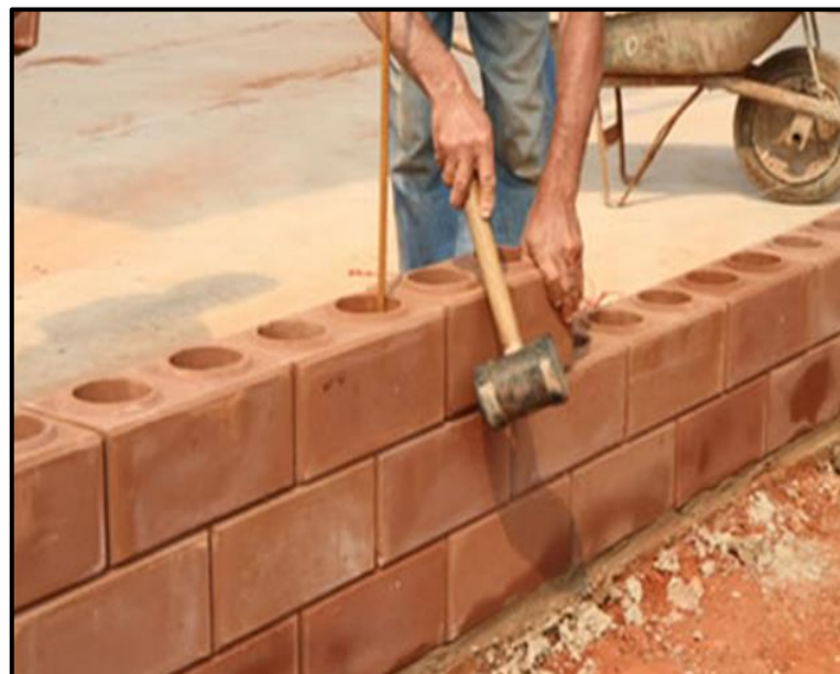
Figura 9 - Tijolo vazado sendo aplicado em uma parede
