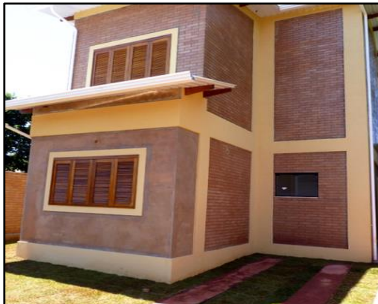
Figura 30 - Residência de dois pavimentos (Belo Horizonte-MG)
