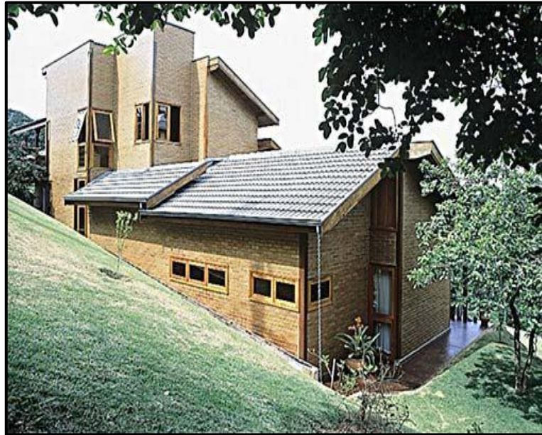
Figura 33 - Residência de dois pavimentos (Vinhedo-SP)
