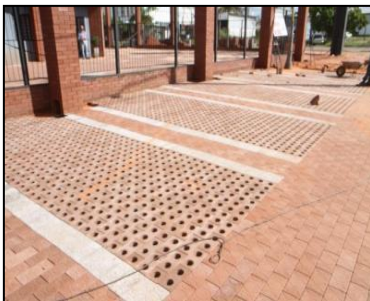
Figura 15 - Paver aplicado em estacionamento
