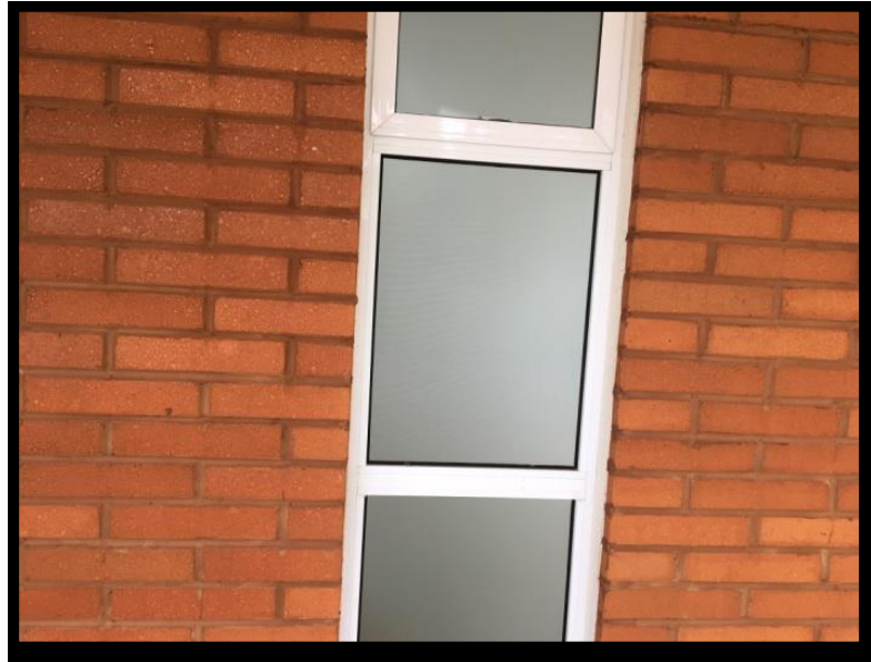
Figura 16 - Aplicação de revestimento em parede
