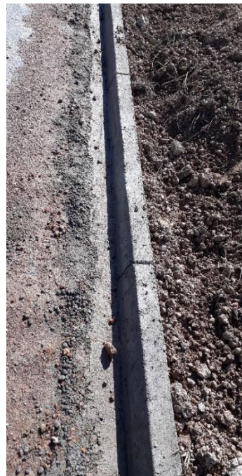
Figura 4.35 - Meio-fio concretado (Autoria Própria)
