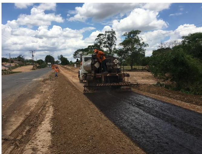
Figura 4.25 - Caminhão espargidor no processo de imprimação (Autoria Própria)
