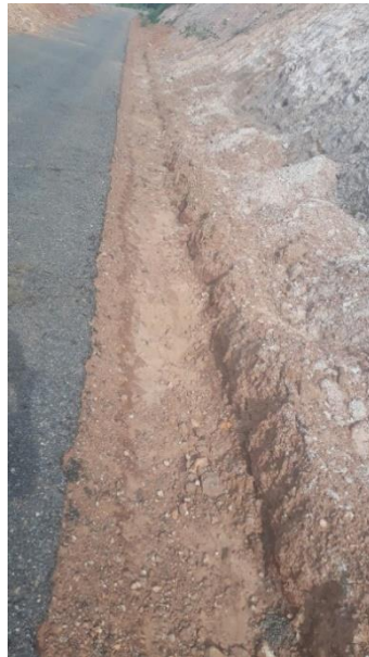
Figura 4.30 - Escavação para valetas (Autoria Própria)
