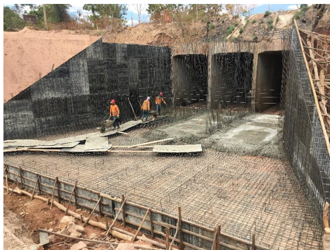
Figura 4.14 - Construção do bueiro celular (Autoria Própria)
