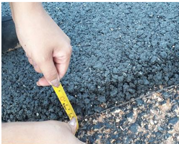
Figura 4.28 - Medição do revestimento asfáltico (Autoria Própria)
