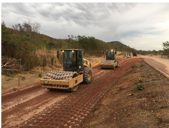
Figura 4.22 - Rolo compactador pé de carneiro na compactação do solo (Autoria Própria)
