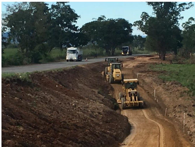
Figura 4.19 – Motoniveladora na etapa de aterro (Autoria Própria)
