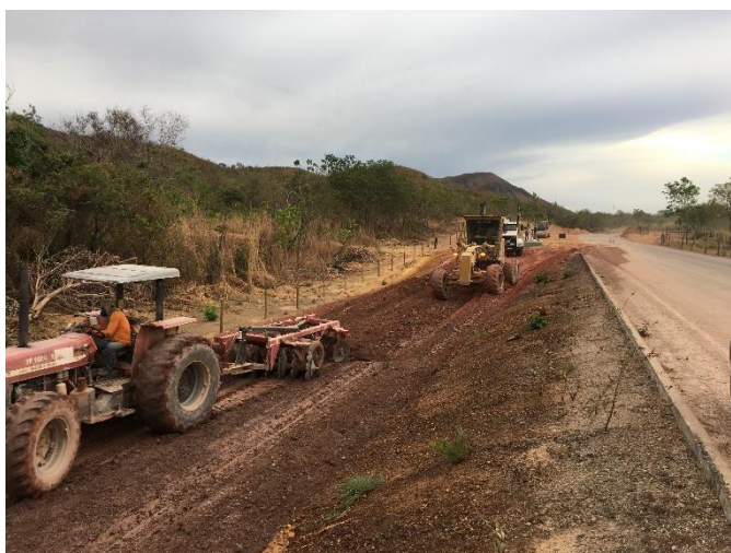
Figura 4.20 - Etapa de nivelamento (Autoria Própria)
