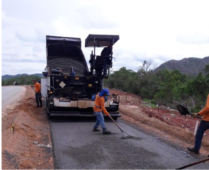
Figura 4.26 - Acabadora de asfalto (Autoria Própria)
