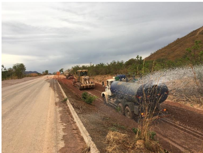
Figura 4.21 - Caminhão pipa no processo de umidificação (Autoria Própria)
