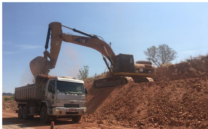
Figura 4.16 - Escavadeira e caminhão basculante na etapa de corte (Autoria Própria)
