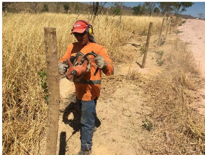
Figura 4.12 - Furação para passagem do arame (Autoria Própria)
