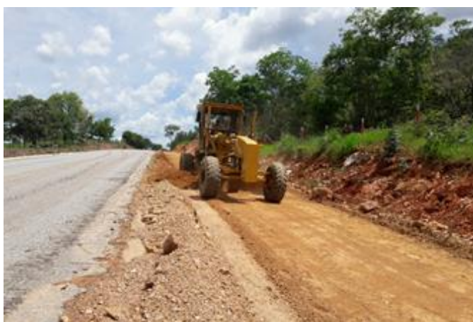
Figura 4.23 - Motoniveladora na execução do sub-leito (Autoria Própria)
