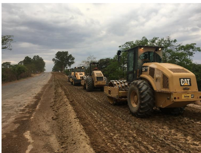
Figura 4.24 - Rolo compactador etapa base (Autoria Própria)
