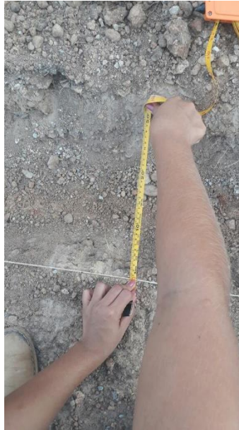
Figura 4.33 - Medição da escavação do meio-fio (Autoria Própria)
