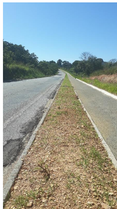
Figura 4.39 - Canteiro central (Autoria Própria)
