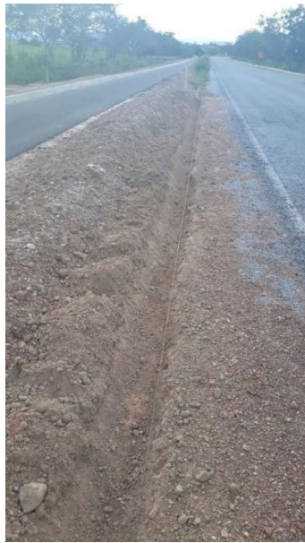
Figura 4.32 - Escavação do meio-fio (Autoria Própria)
