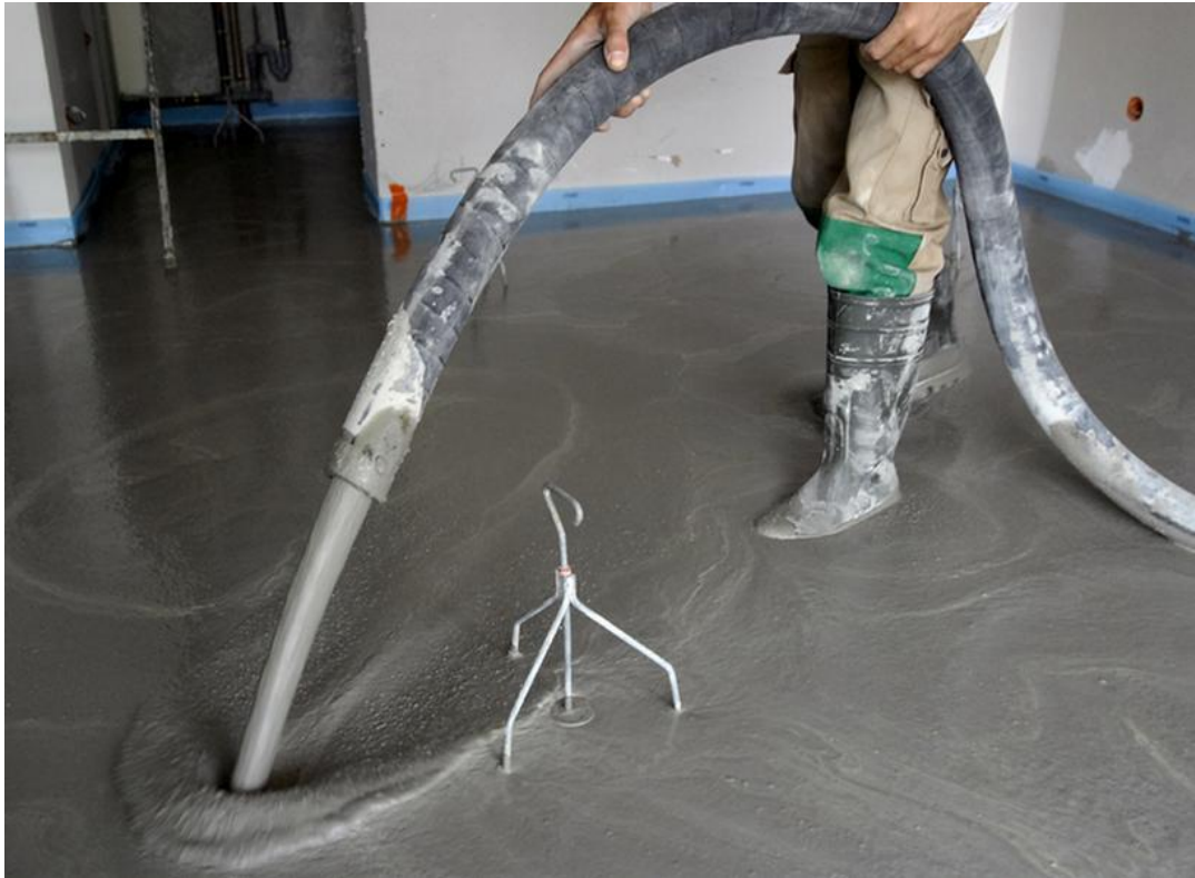
Figura 9. Contra piso autonivelante.
