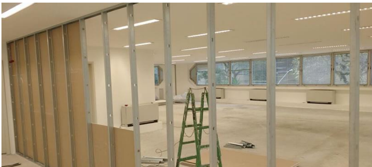
Figura 7. Construção seca, vedação paredes de gesso e drywall . BEZERRA (2010).
