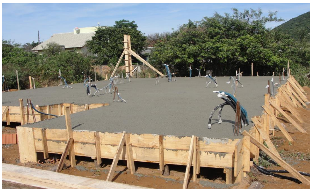
Figura 4. Processo de concretagem na fundação. (PICHILEMU, 2010).
