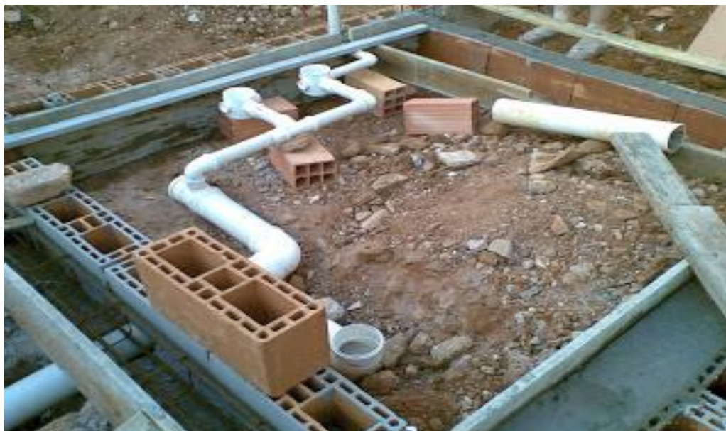
Figura 6. Kit de instalação hidrossanitário. NBR 15575-6/2013
