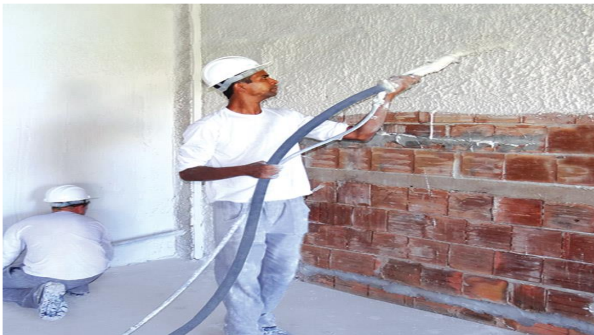
Figura 8. Reboco interno feito com gesso. (BEZERRA, 2010).
