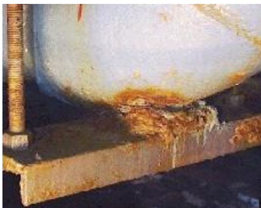
Figura 2: Corrosão Galvânica
