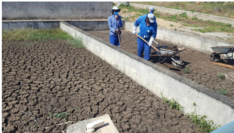
Figura 12 – Lodo retirado da Saneago-Goianésia.
