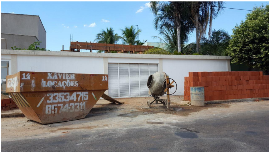
Figura 2-Resíduos sólidos dispostos de maneira correta na cidade de Goianésia.
