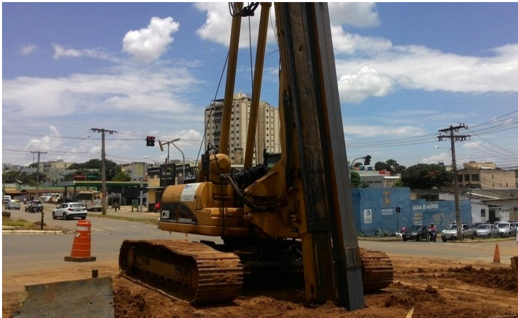
Foto 1: Cravação de estaca metálica
