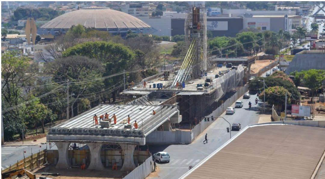
Figura 5: Vista superior do viaduto
