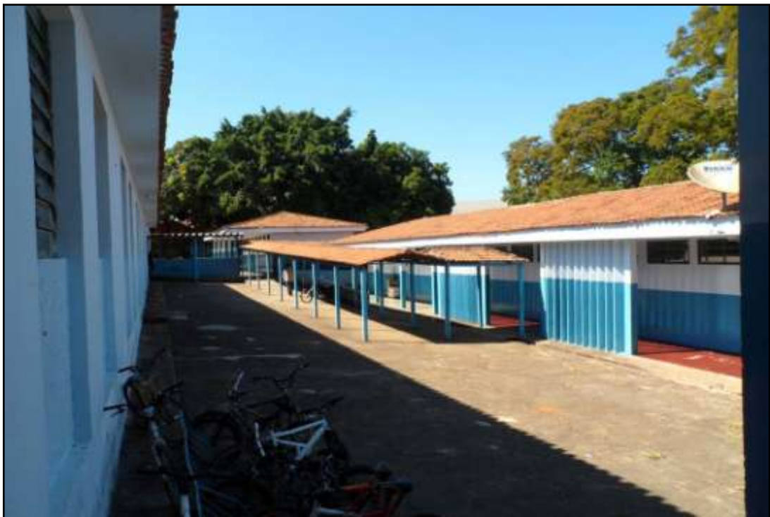
Figura 07. Área interna, bloco das salas de aula do Colégio Estadual BA – 2014.
