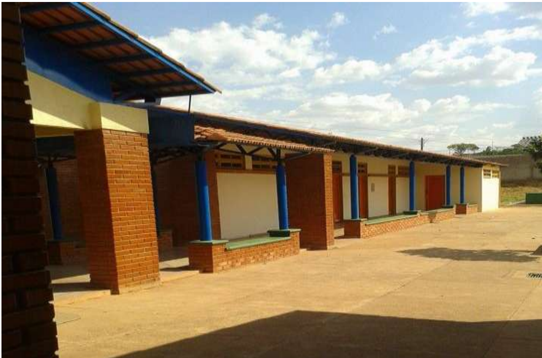
Figura 20. Área interna, bloco das salas de aula da Área do Estadual MA – 2014.
