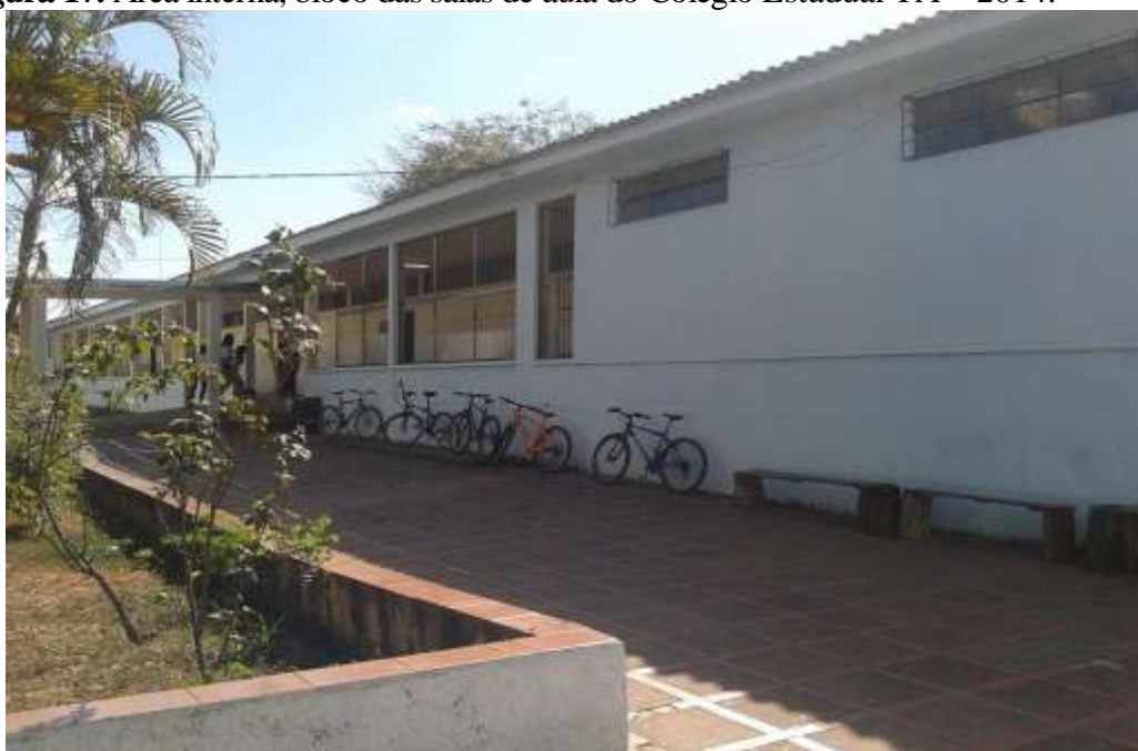
Figura 17. Área interna, bloco das salas de aula do Colégio Estadual TA – 2014.
