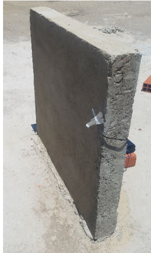
Figura 24 - Lado externo da parede 1
