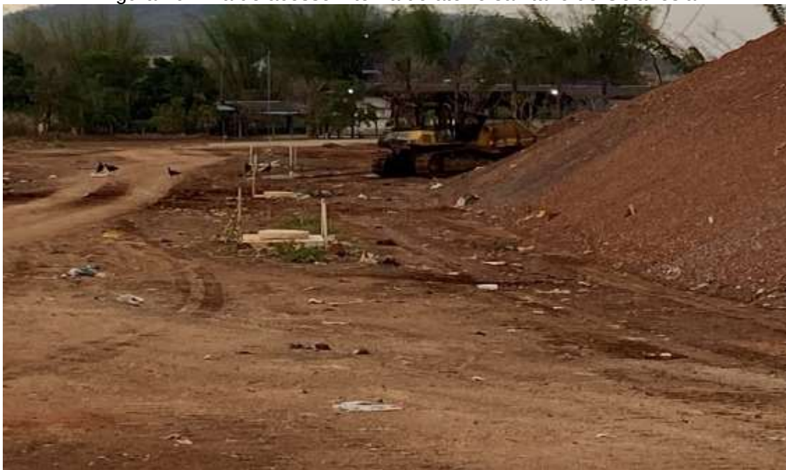
Figura 26 - Via de acesso interna do aterro sanitário de Goianésia
