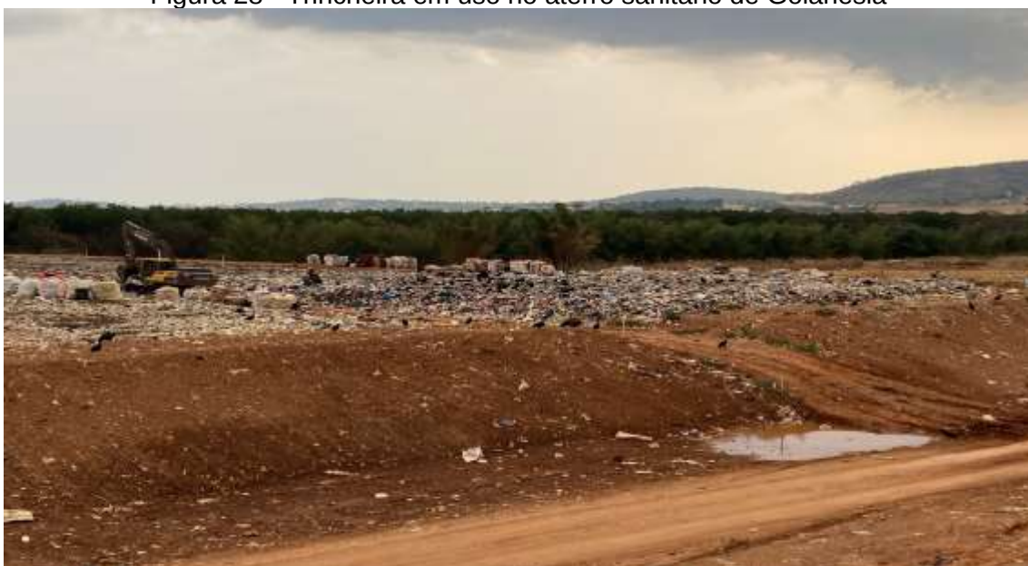
Figura 28 - Trincheira em uso no aterro sanitário de Goianésia
