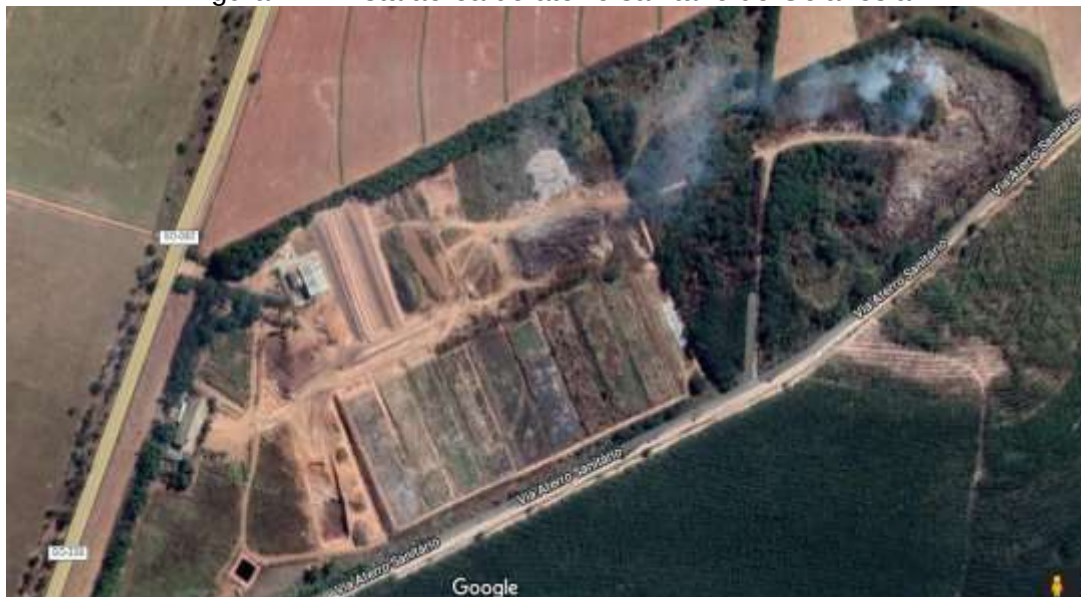
Figura 11 - Vista aérea do aterro sanitário de Goianésia
