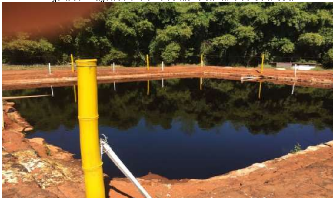
Figura 30 - Lagoa de chorume do aterro sanitário de Goianésia
