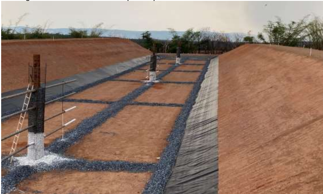
Figura 27 - Trincheira aberta pronta para uso no aterro sanitário de Goianésia
