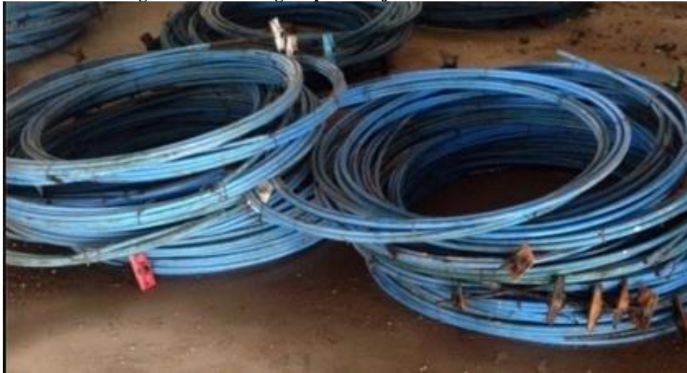
Figura 24 – Ancoragens passivas já fixadas às cordoalhas
