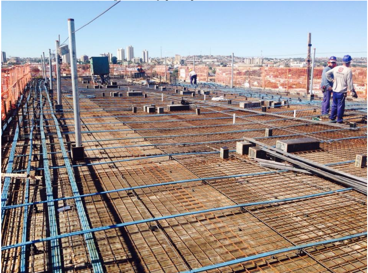
Figura 29 – Laje pronta para ser concretada
