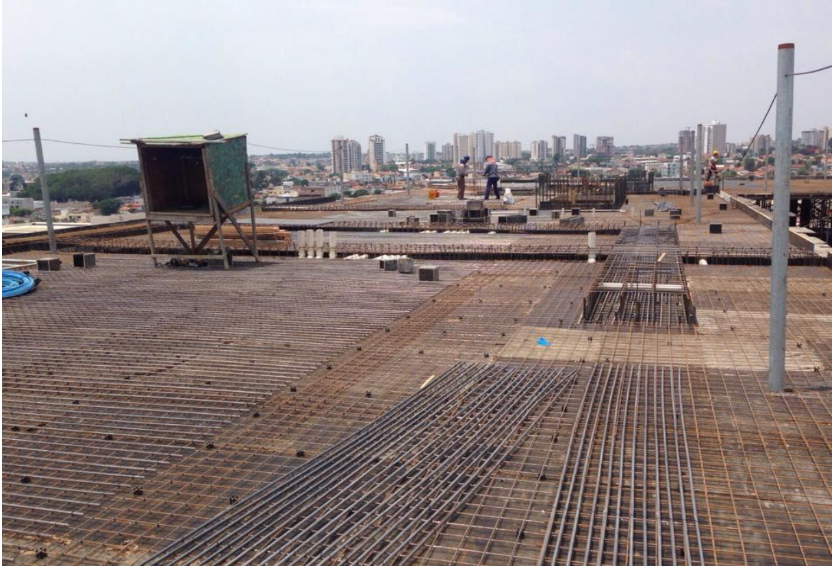
Figura 21 – Execução de armação positiva e negativa
