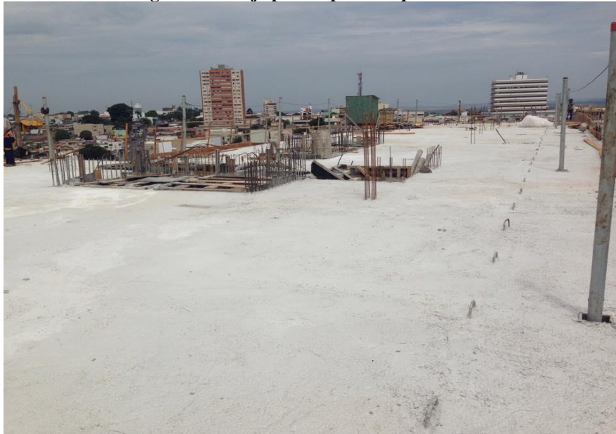
Figura 30 – Laje pronta para ser protendida
