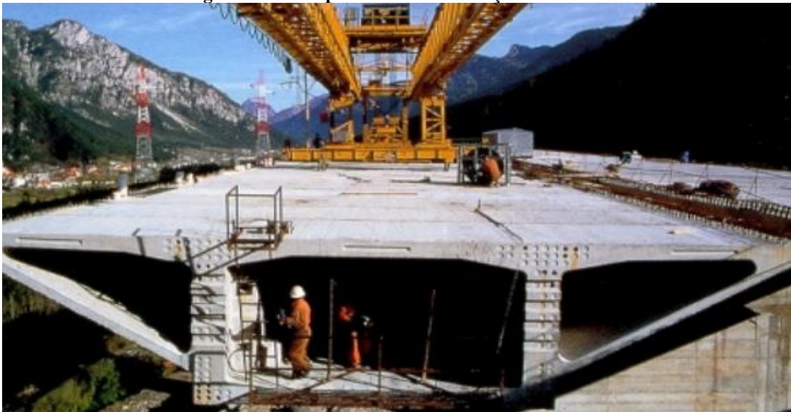
Figura 7 – Ponte protendida em balanços sucessivos
