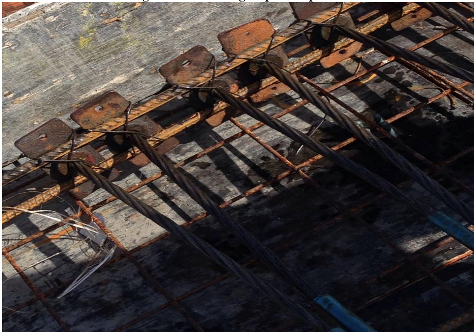
Figura 23 – Ancoragem passiva pronta
