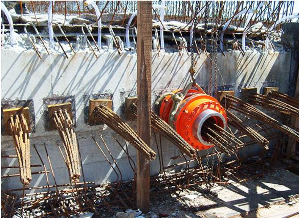
Figura 12 – Cordoalhas protensão aderente
