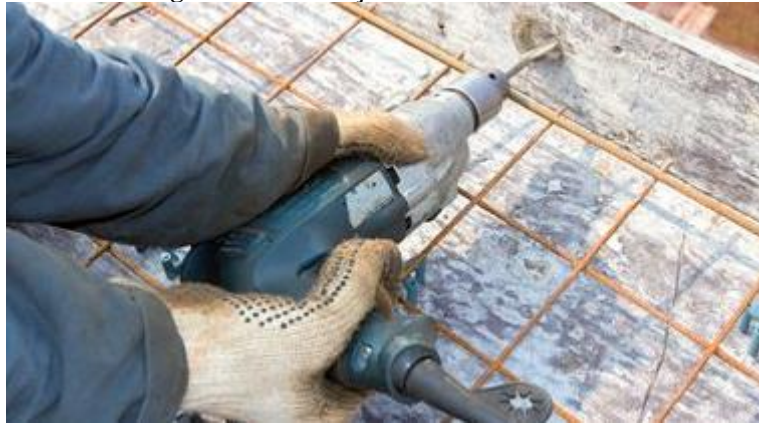
Figura 22 – Execução de furos nas fôrmas
