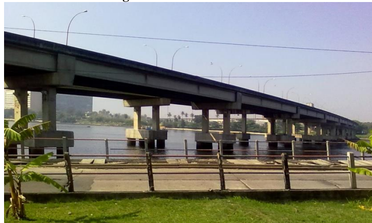
Figura 1 – Ponte do Galeão
