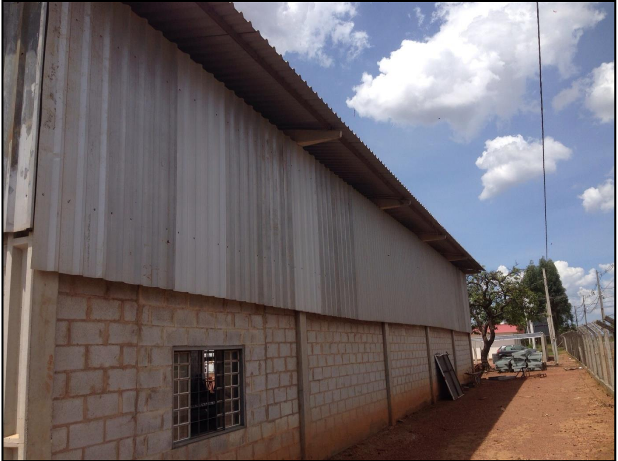
Figura 10 – Fechamento lateral empregado em galpão
