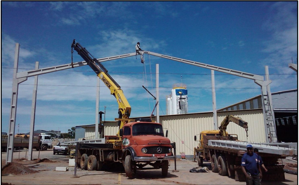
Figura 9 – Emprego de guindaste acoplado a caminhões em uma obra de galpão pré-moldado
