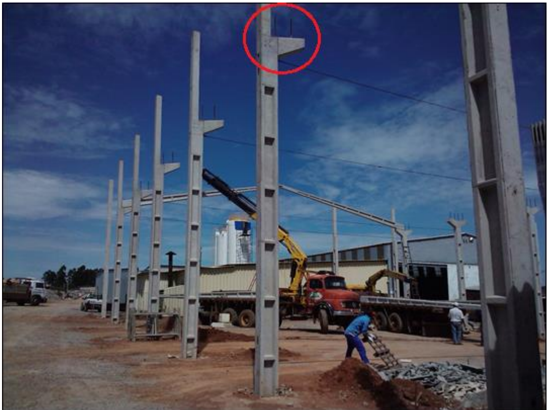
Figura 4 – Obra sendo executada com sistema chumbador e consolo na horizontal
