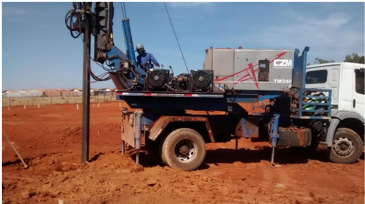
Figura 26 – Escavação das estacas
