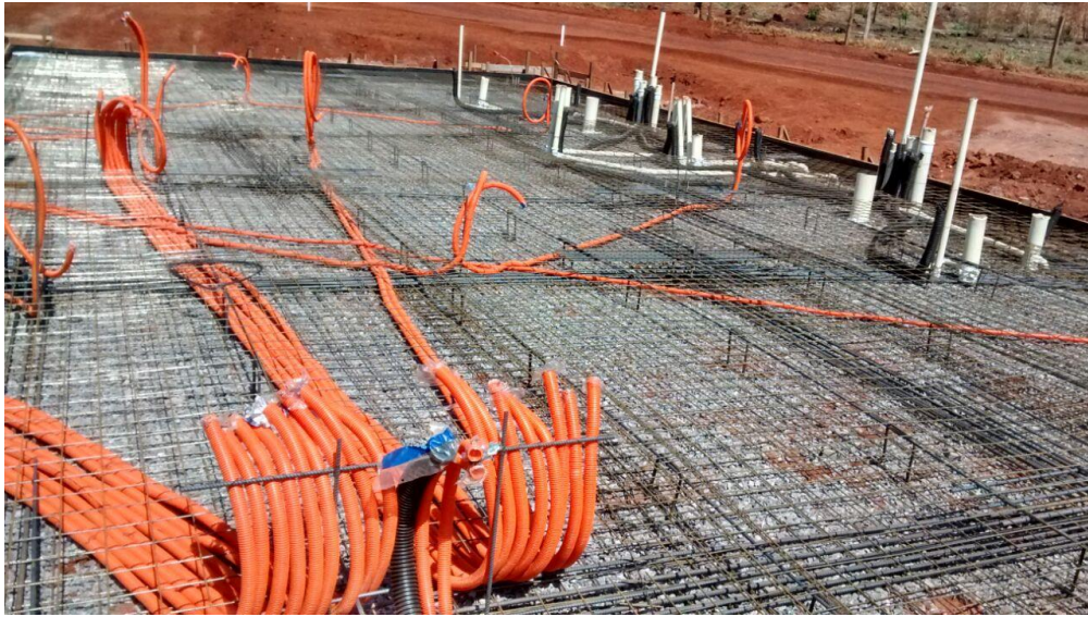
Figura 29 – Montagem do radier tubulações elétricas, hidráulicas e armação
