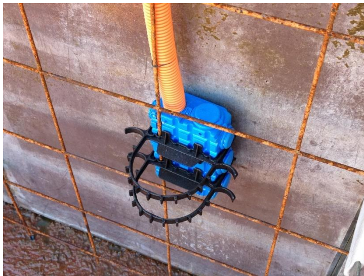
Figura 18 – Colocação das caixas de passagem elétrica embutidas nas paredes
