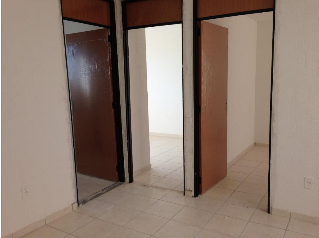
Figura 42 – Colocação das portas
