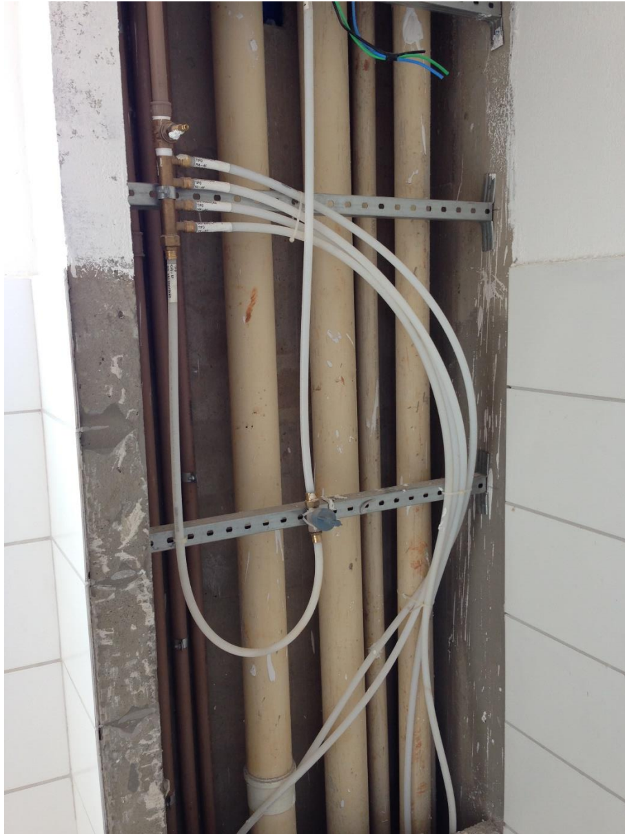
Figura 21 – Tubulações de água e esgoto embutidas na parede
