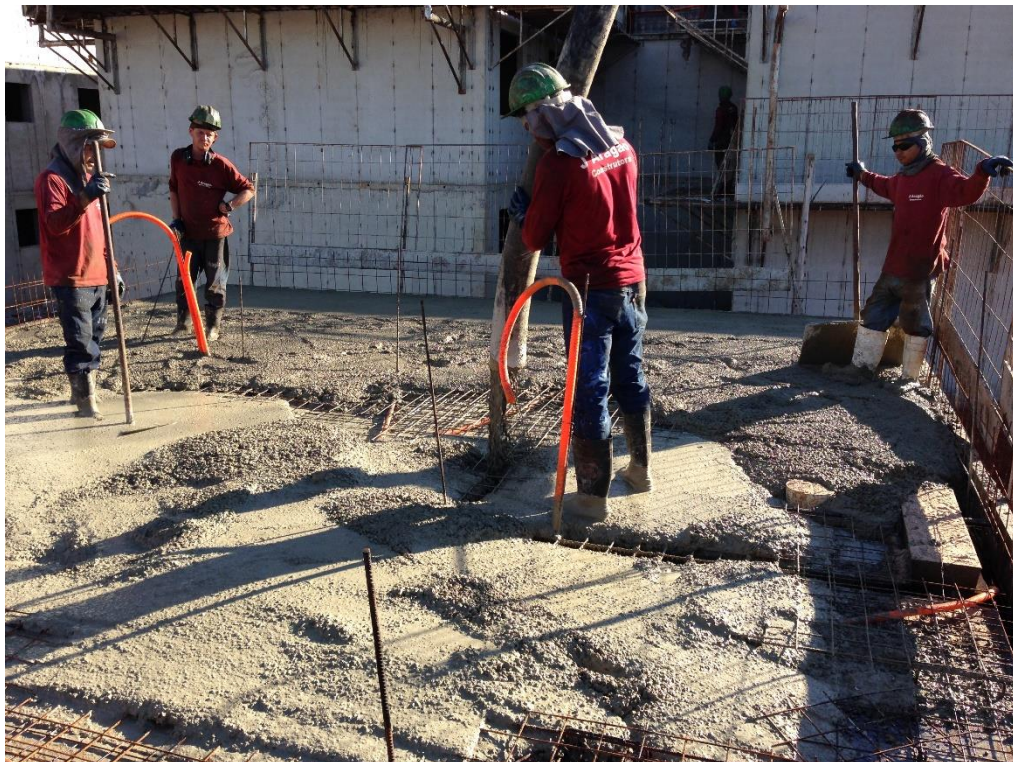
Figura 4 – Lançamento de concreto usinado sobre a laje
