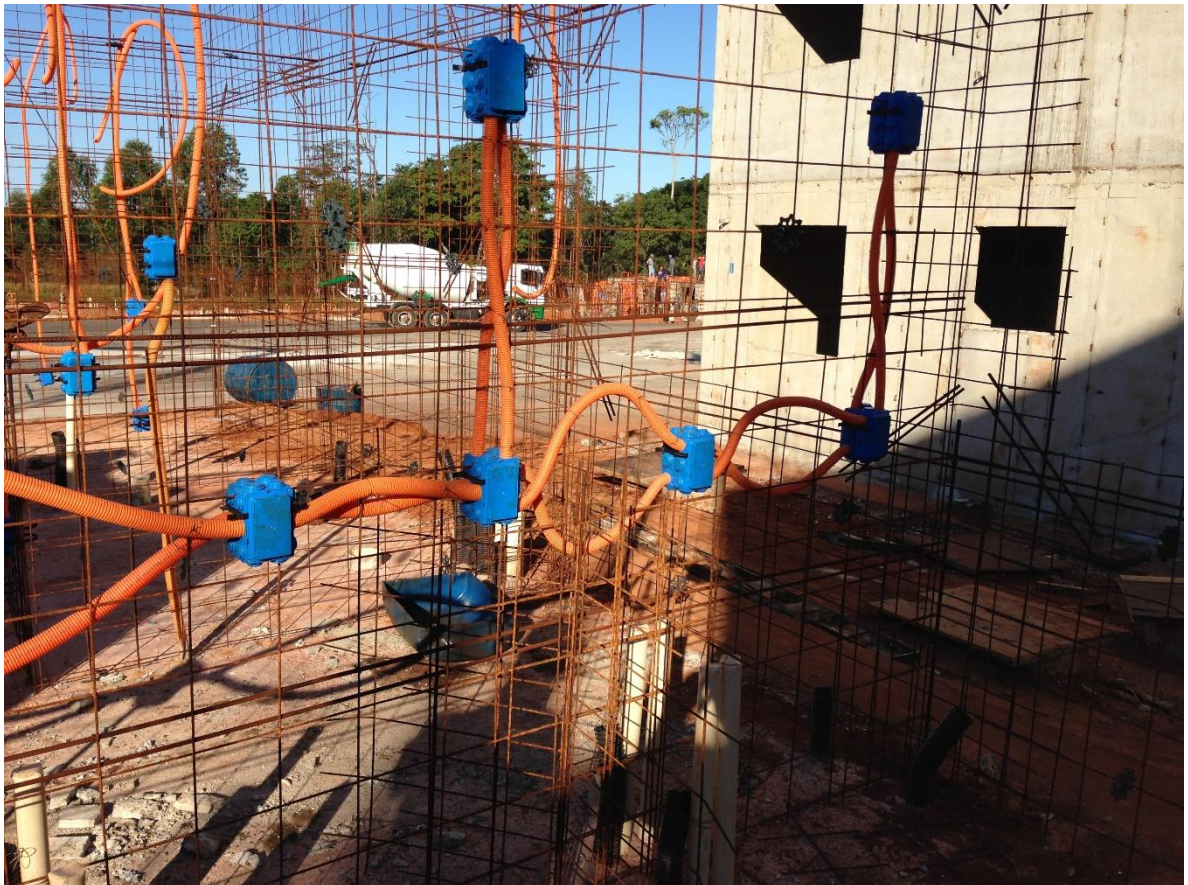
Figura 11 – Telas montadas com tubulações elétricas fixadas
