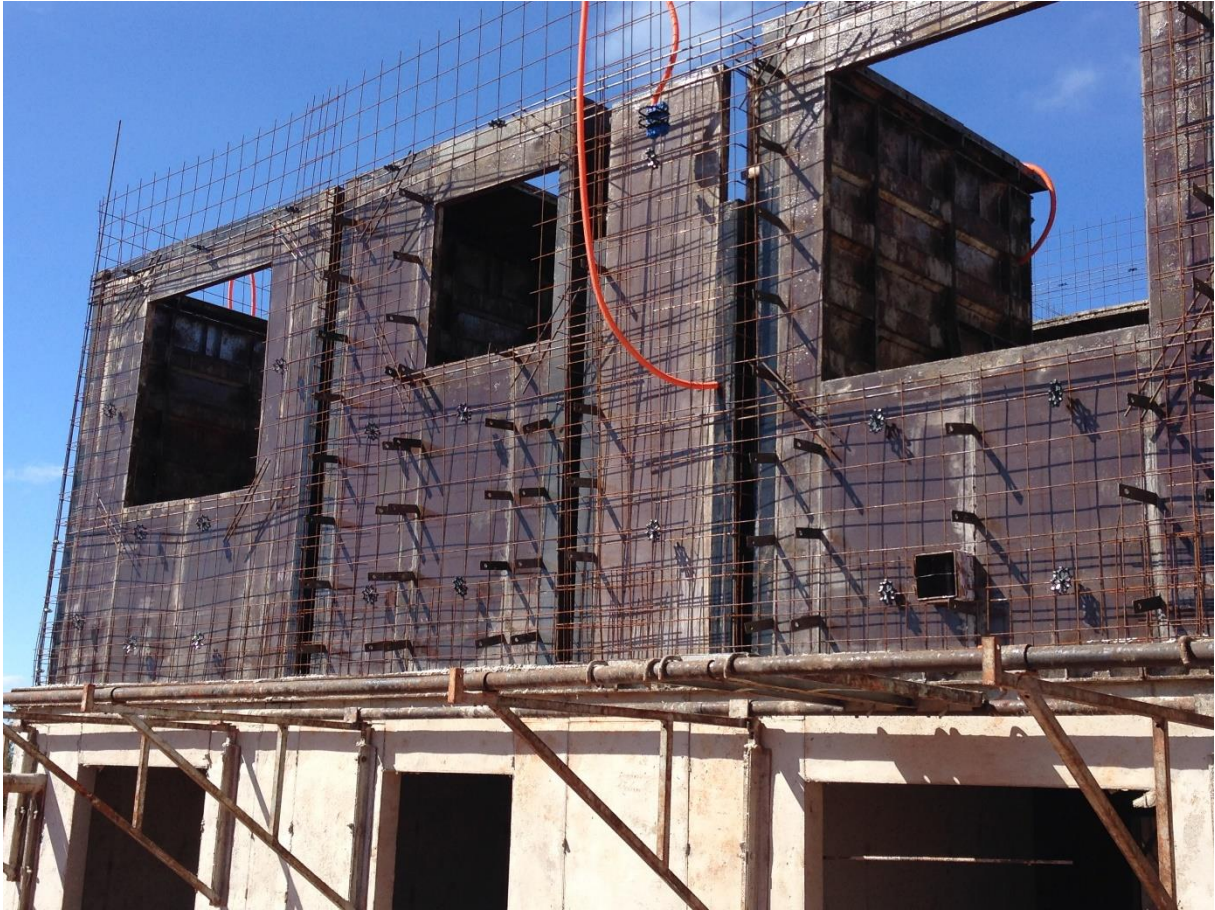
Figura 55 – Montagem das fôrmas internas da estrutura
