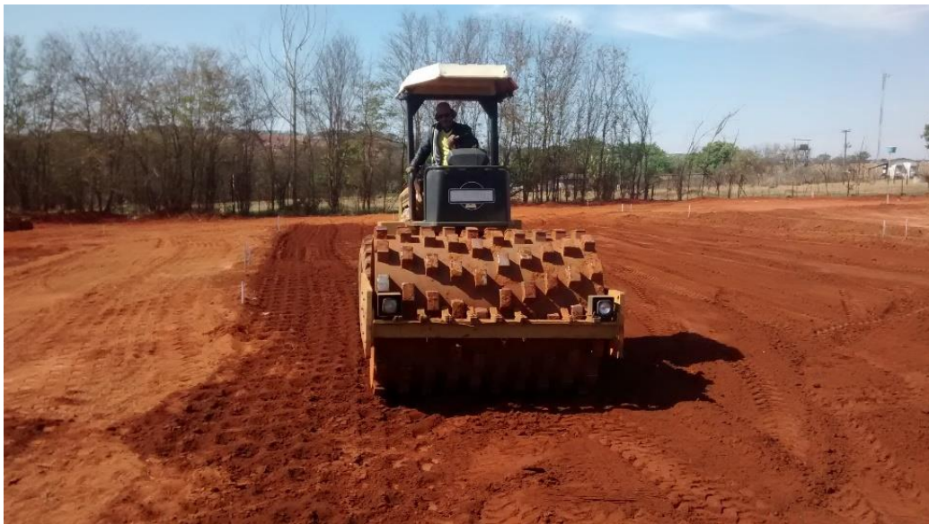
Figura 50 – Compactação do solo para início da fundação
