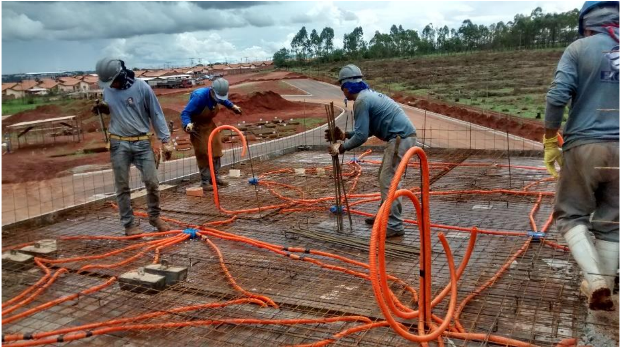
Figura 36 – Montagem da armação da laje e tubulações prediais
