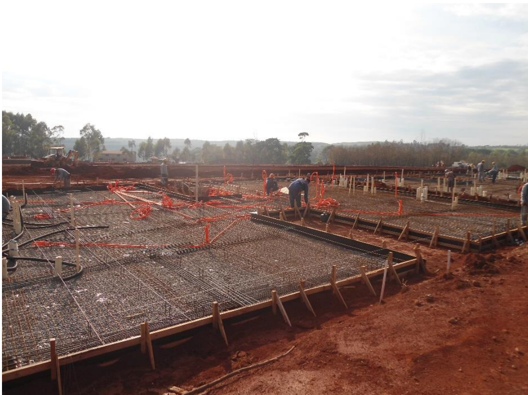
Figura 28- Montagem das fôrmas do radier e locação das instalações prediais
