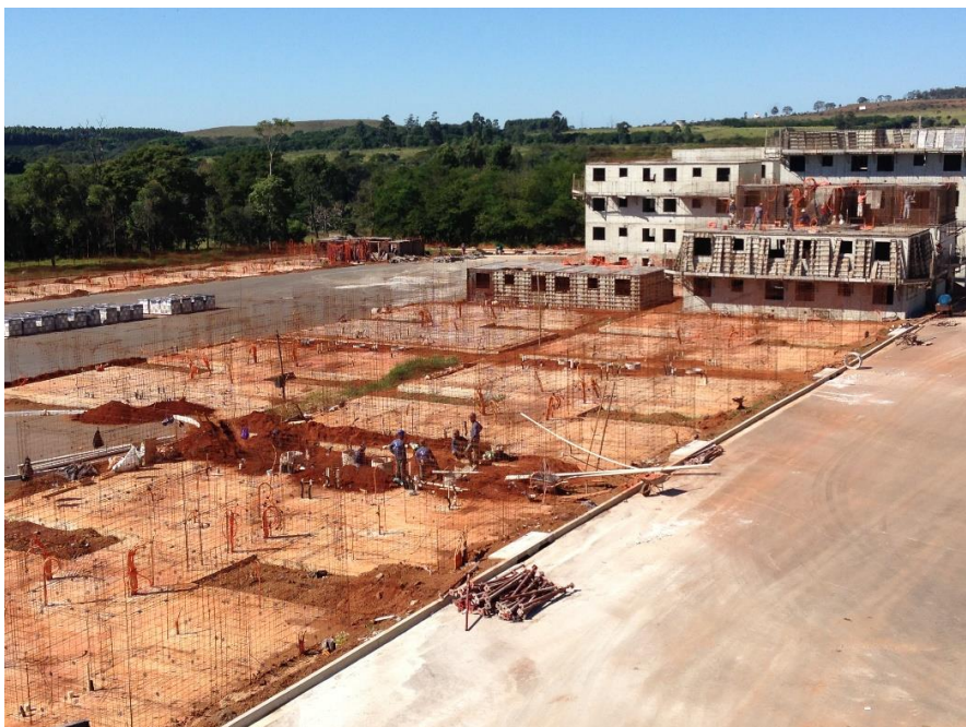
Figura 53 – Telas posicionadas e reforçadas
