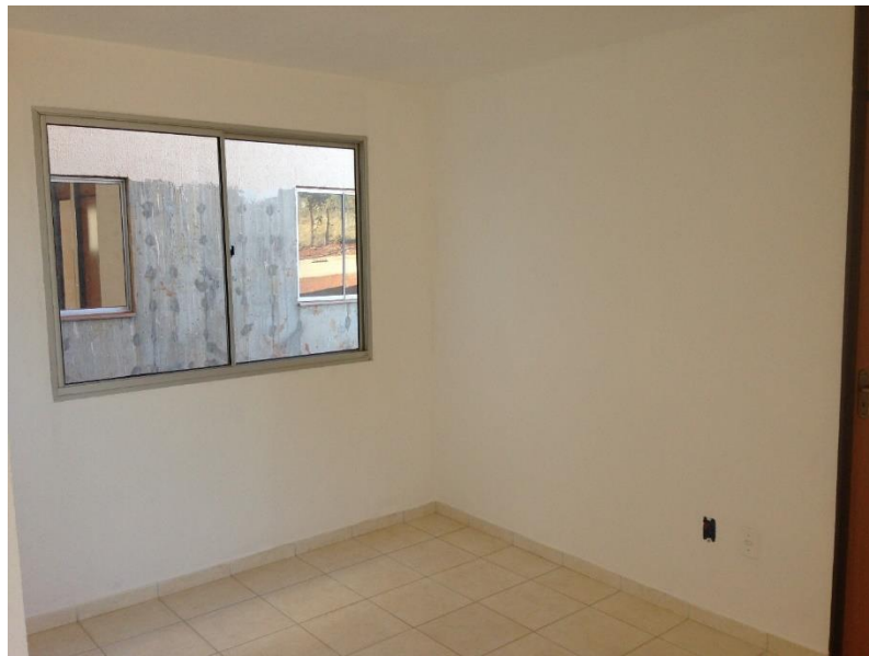
Figura 40 – Revestimento e acabamento interno
