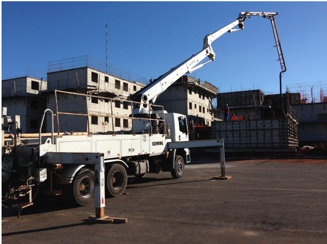
Figura 10 – Utilização de caminhão bomba para lançamento do concreto
