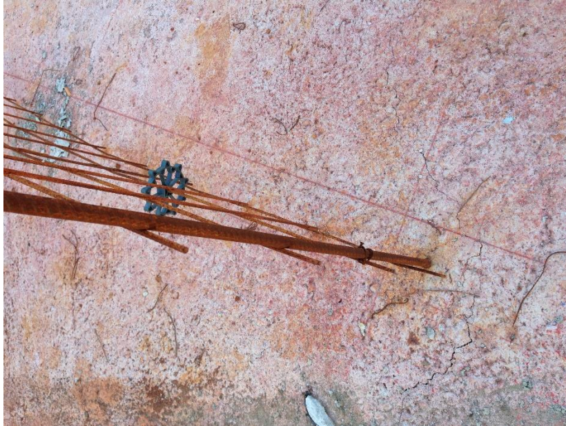
Figura 52 – Marcação das paredes
