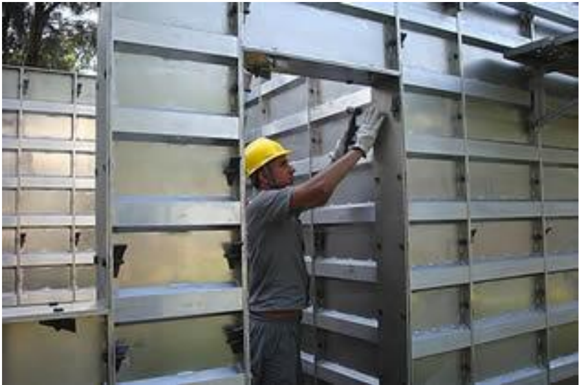
Figura 1 – Fechamento com fôrmas metálicas
