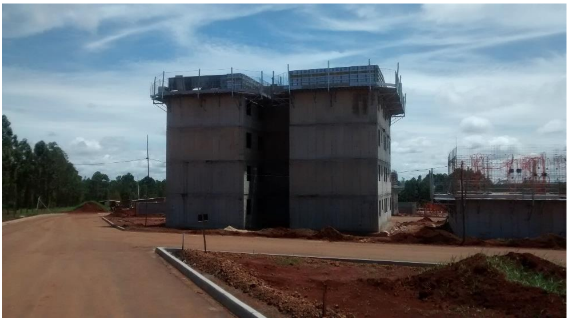
Figura 34 – Estrutura do bloco com quatro pavimentos e platibanda
