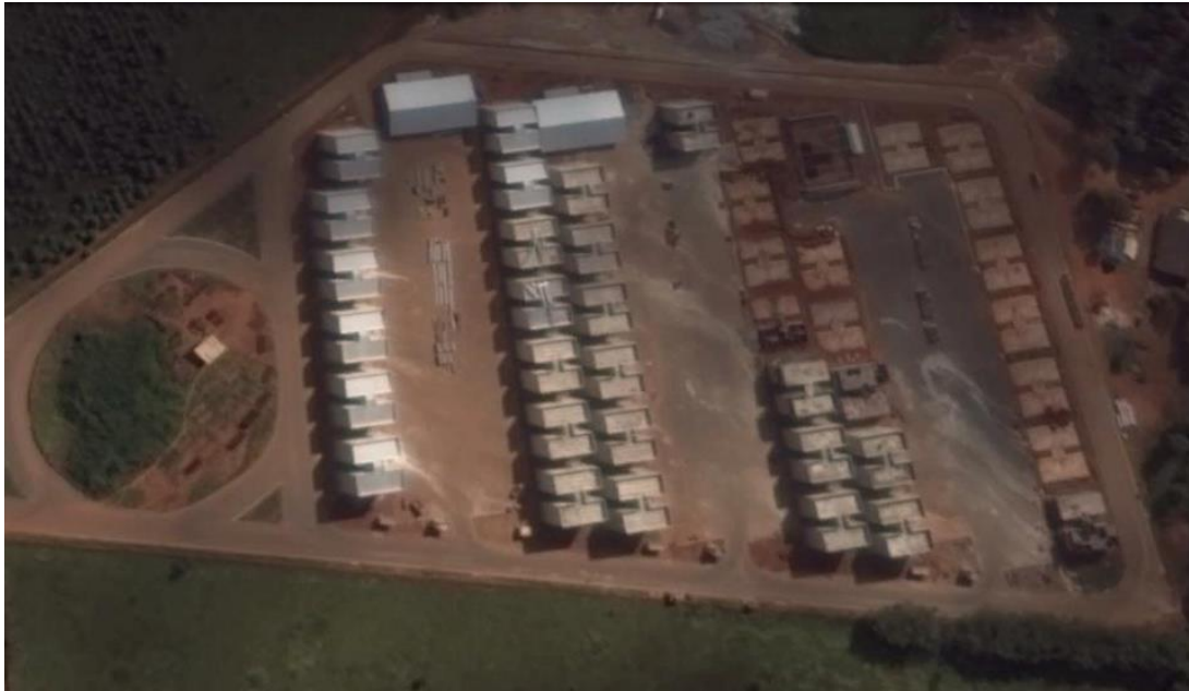
Figura 44 – Vista superior da obra
