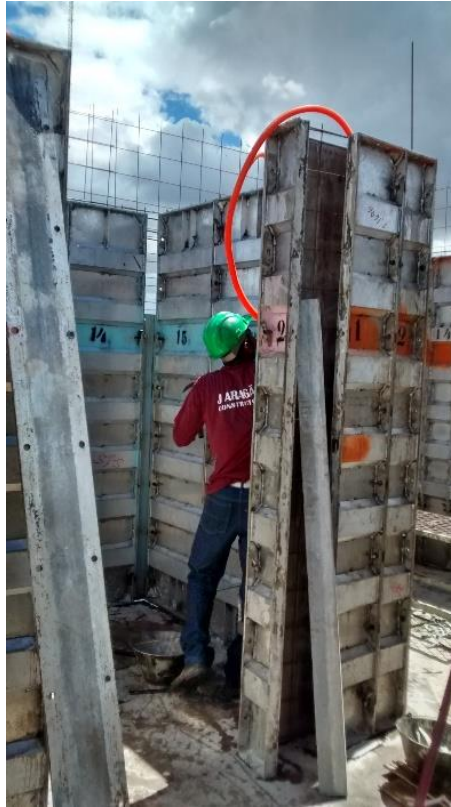
Figura 35 – Montagem das fôrmas
