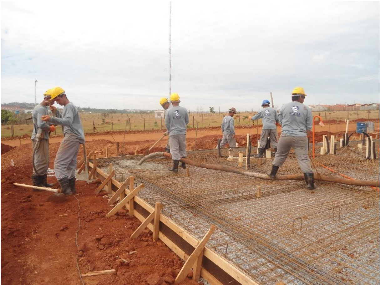
Figura 51 – Concretagem do radier
