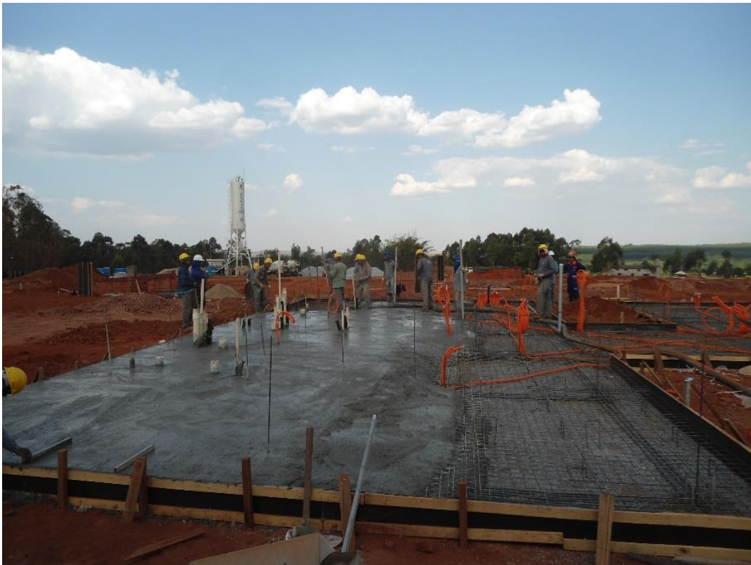
Figura 30 – Lançamento de concreto no radier
