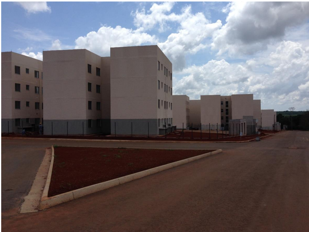
Figura 60 – Entrada do empreendimento
