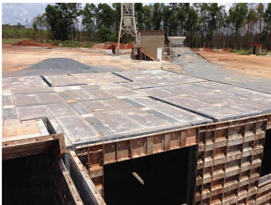
Figura 24 – Fôrma da laje montada e posicionada para recebimento das demais etapas
