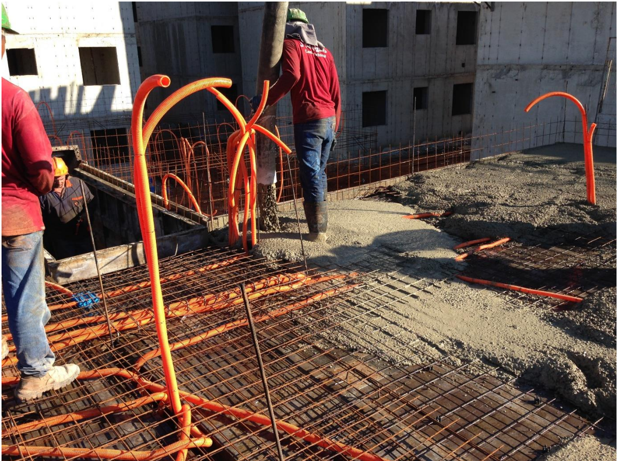
Figura 56 – Lançamento do concreto auto-adensável
