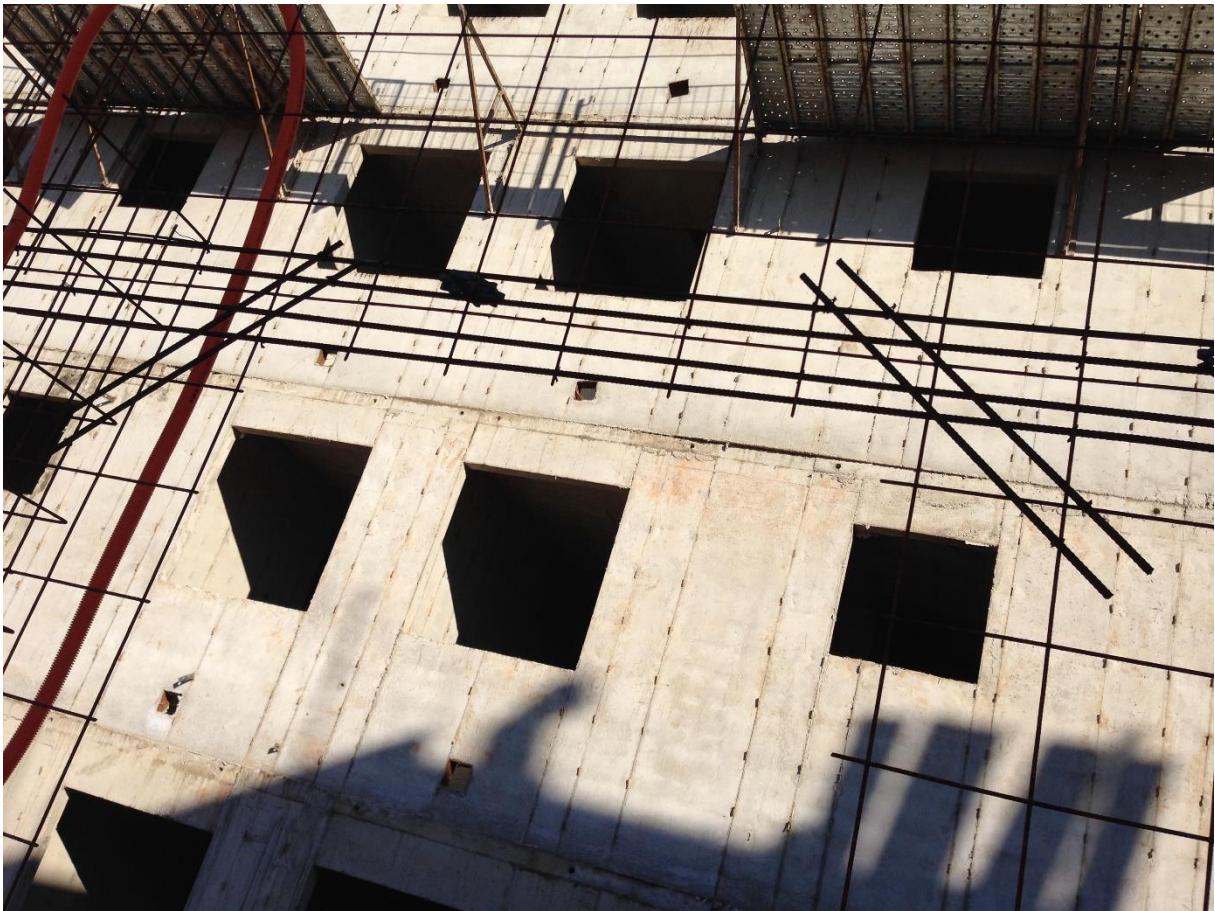
Figura 12 – Colocação de barras CA-50 para reforços em vãos da estrutura
