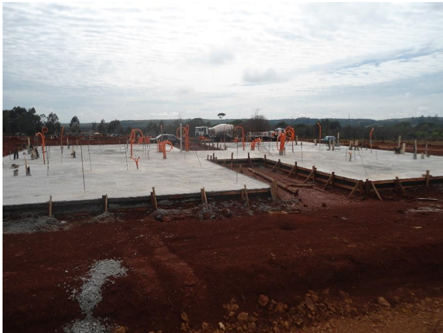
Figura 32 – Radier concretado
