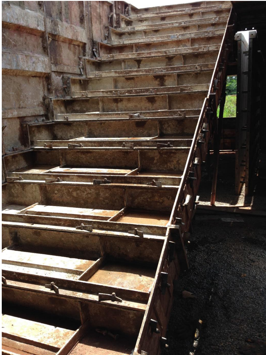
Figura 37 – Fôrma das escadas
