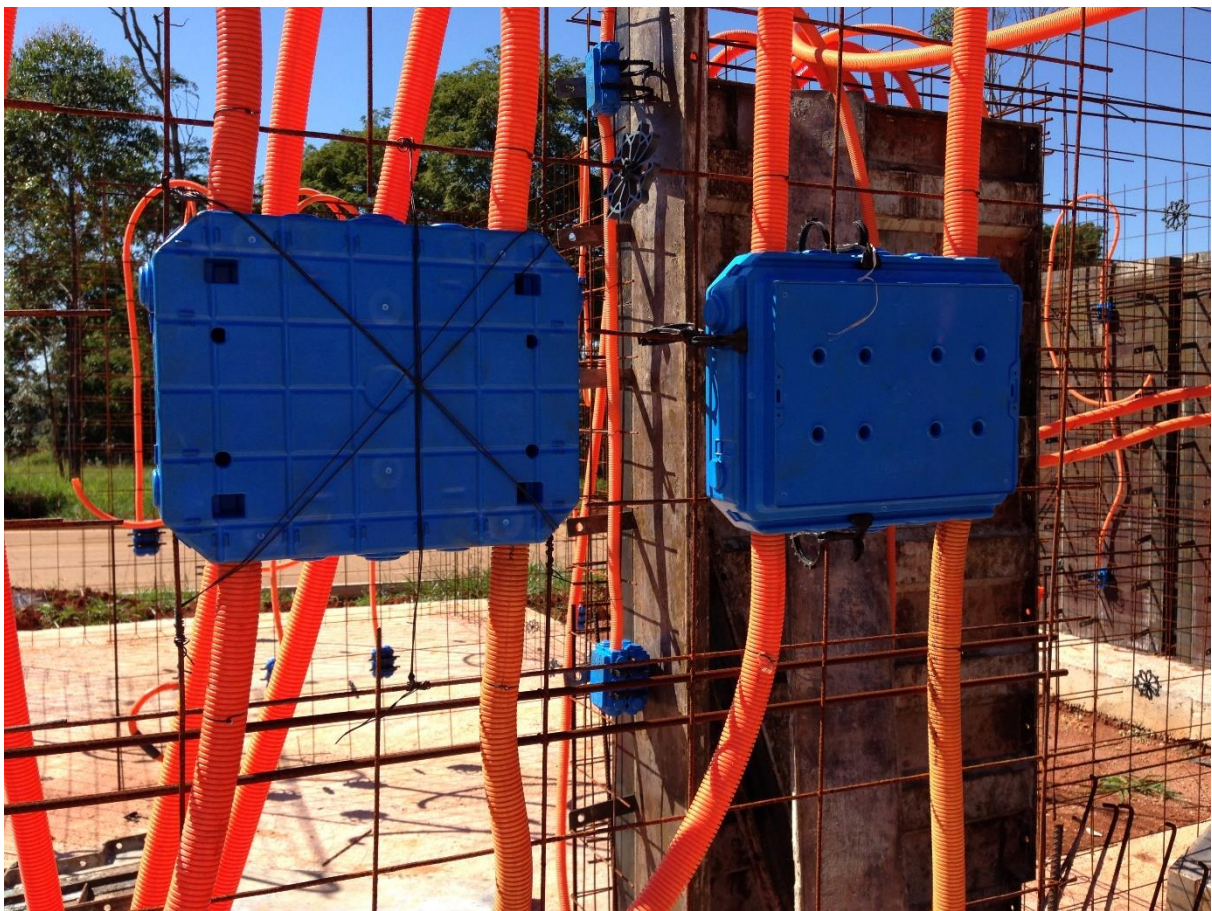
Figura 54 – Fixação dos quadros de distribuição
