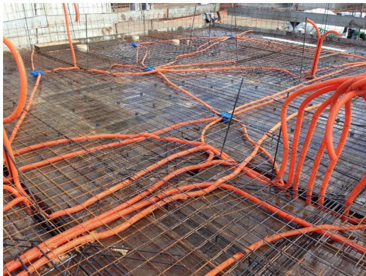
Figura 19 – Tubulação elétrica colocada sobre a laje
