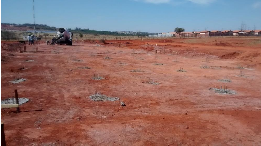
Figura 27 – Estacas escavadas e concretadas e início da marcação do radier
