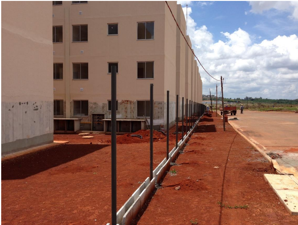
Figura 59 – Montagem da grade de proteção
