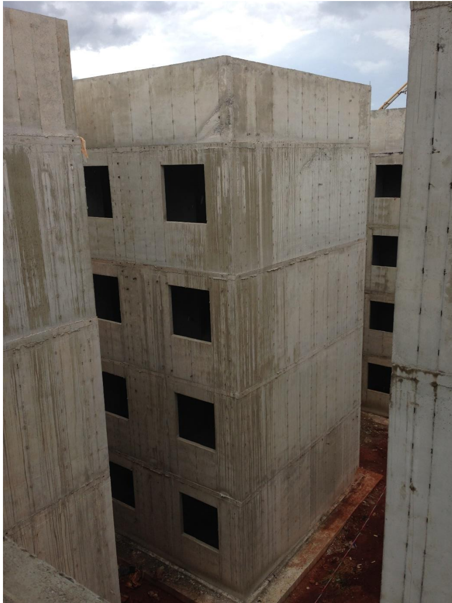
Figura 22 – Estrutura em paredes de concreto após desforma
