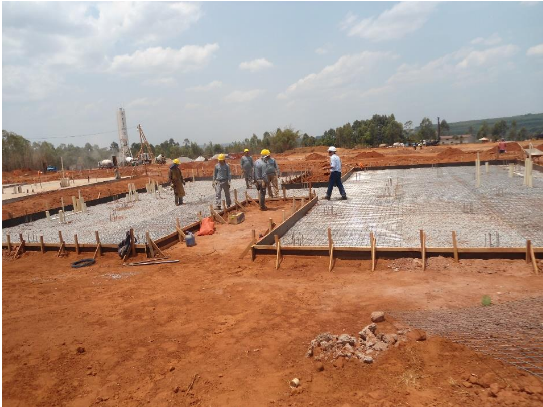
Figura 31 – Finalização das fôrmas do radier
