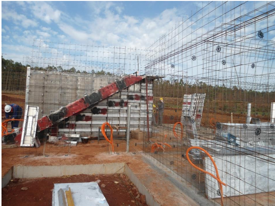
Figura 33 – Armação das paredes e início da montagem das fôrmas
