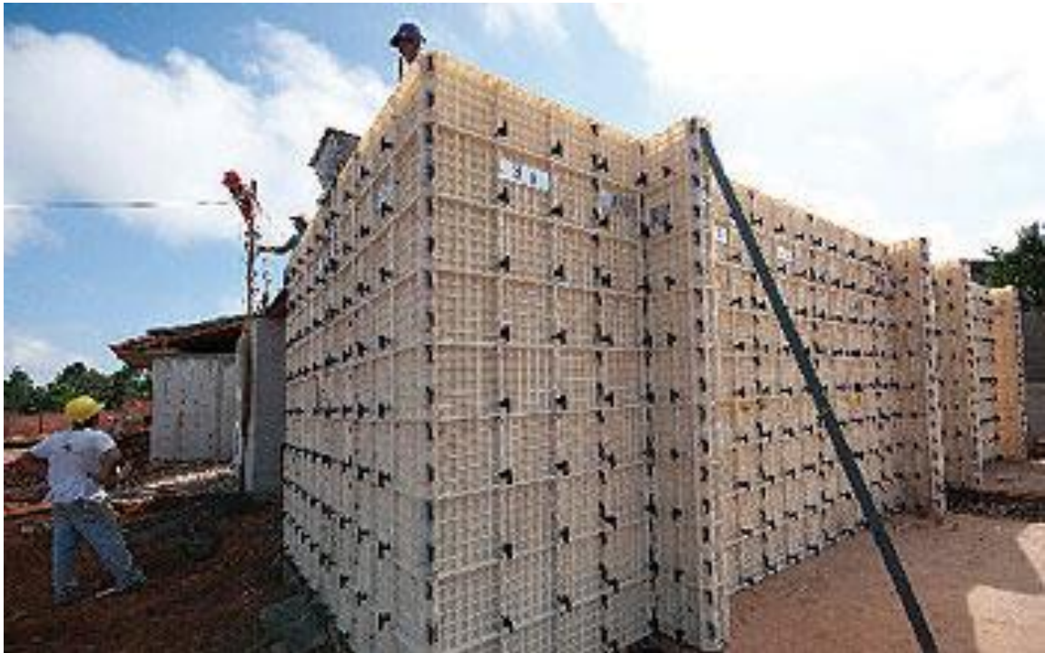
Figura 2 – Execução do empreendimento com fôrmas de plástico
