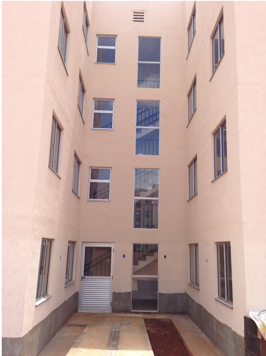
Figura 39 – Execução de pintura externa fachada frontal
