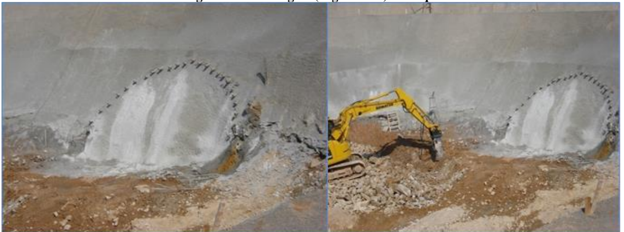
Figura 24 - Enfilagem (Viga Portal) emboque Sul
