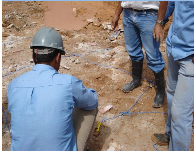
Figura 27 – Instalação de explosivos
