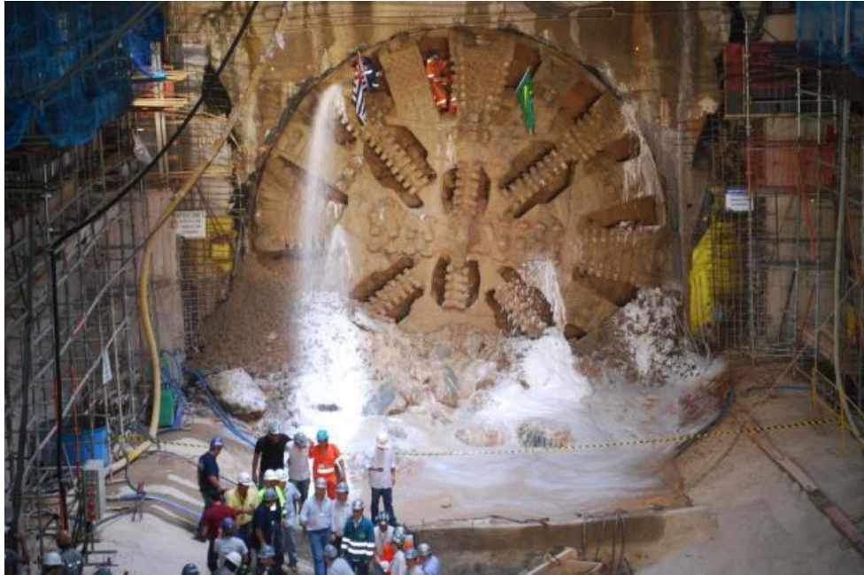
Figura 4 – Escavação com Shield
