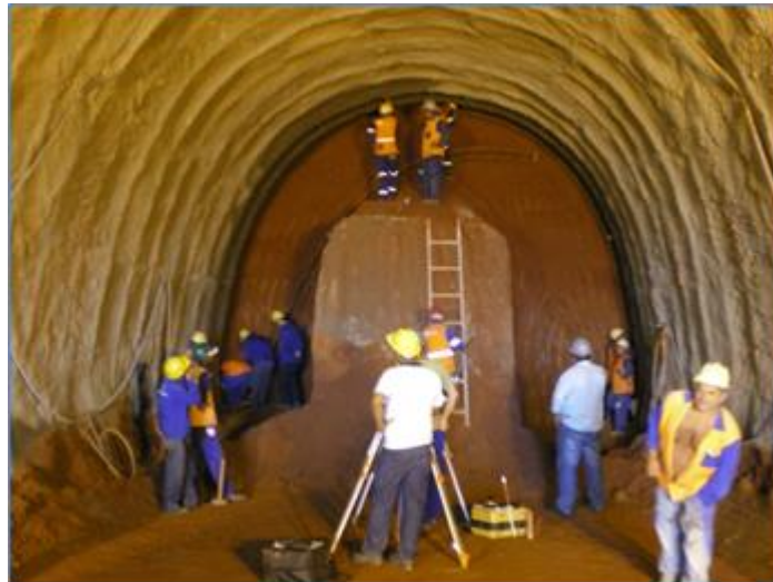
Figura 32 - Topografia Acompanhando Armação de cambota
