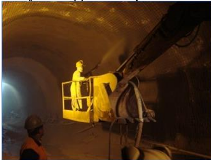
Figura 34 - Projeção de concreto para acabamento
