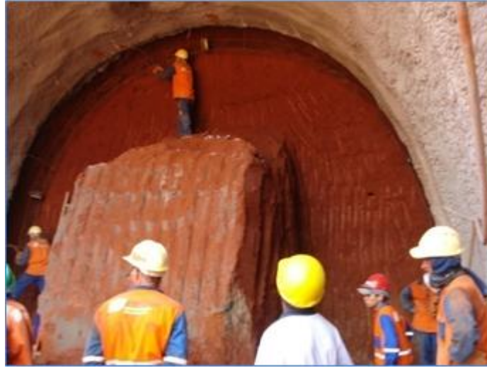
Figura 31 - Armação da Cambota Treliçada
