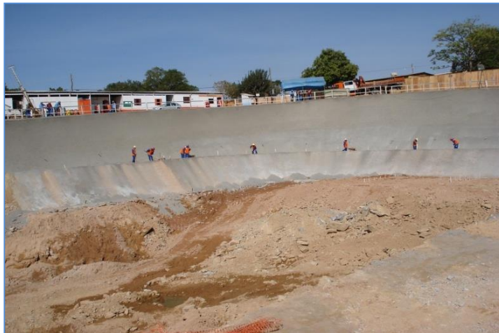
Figura 21 - Taludes do emboque Sul
