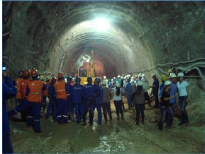
Figura 35 - Equipe mobilizada para assistir o encontro das frentes de escavação
