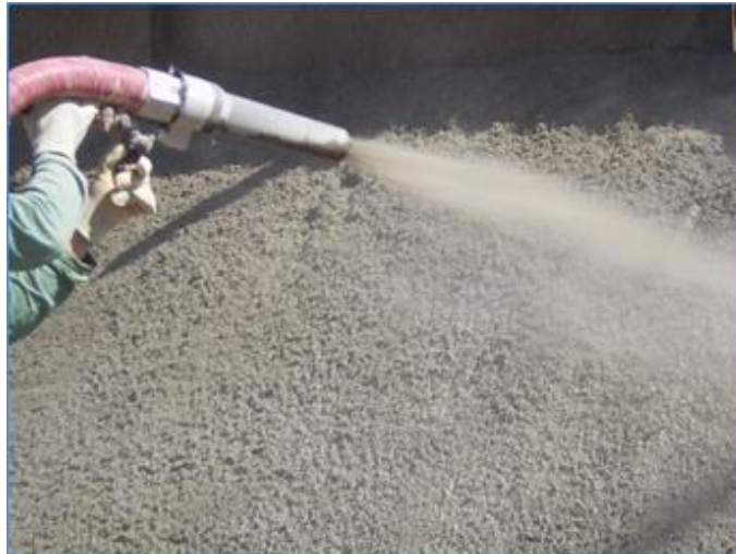
Figura 30 - Projeção de Concreto
