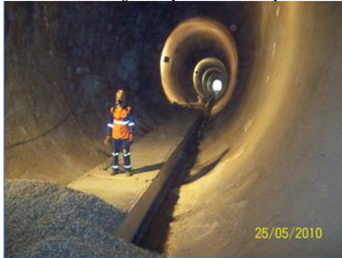
Figura 41 - Sistema de drenagem completo e início do espalhamento de lastro
