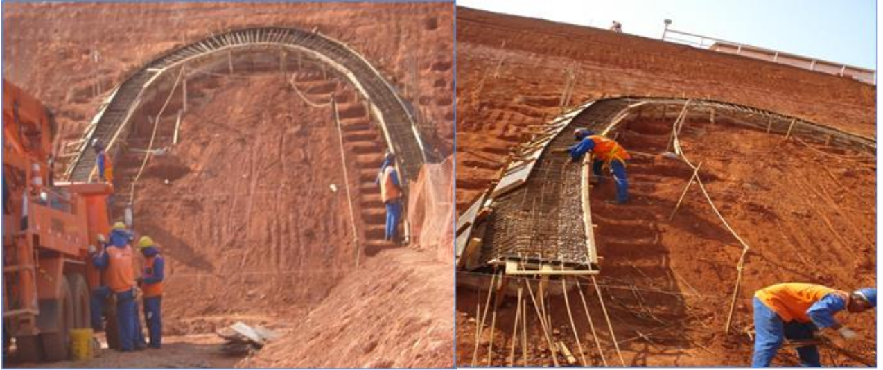
Figura 25 - Armação da viga portal emboque norte
