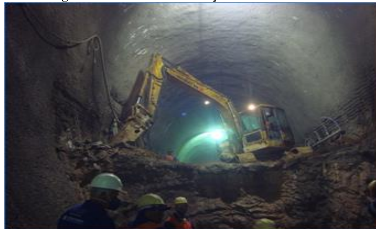
Figura 36 - Início das escavação do Arco Invertido
