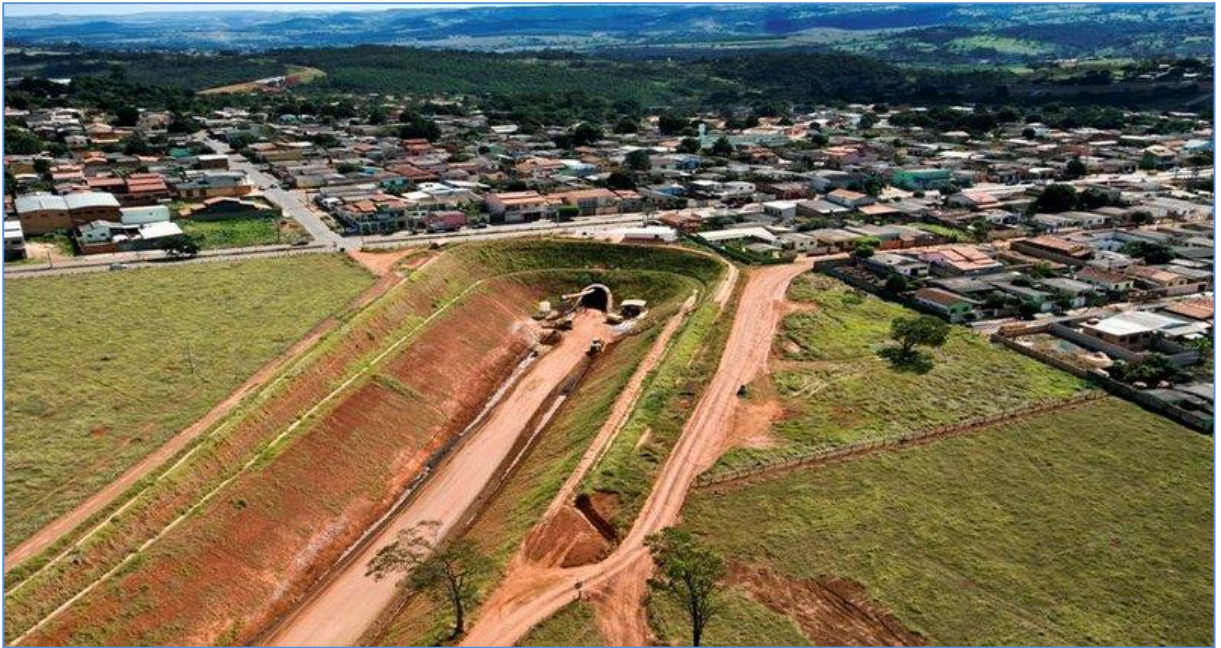
Figura 1 – Emboque norte do túnel 01 no lote 01 da FNS
