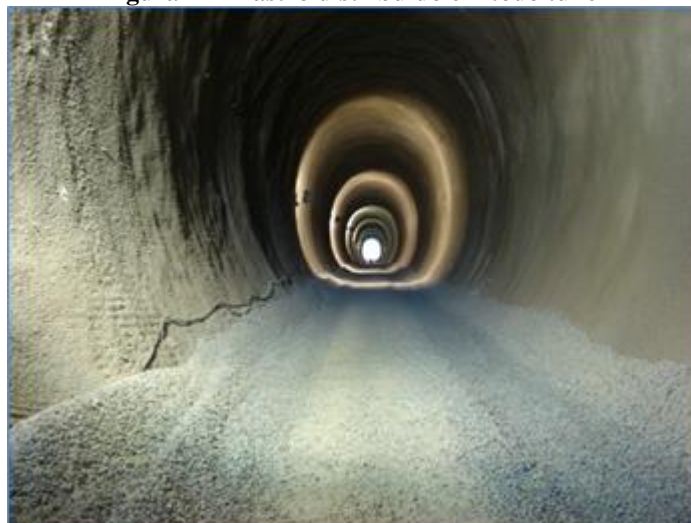
Figura 42 - Lastro distribuído em todo túnel
