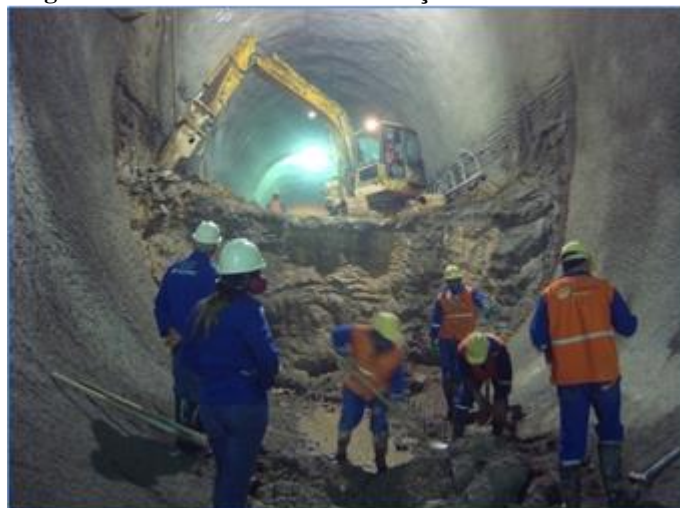
Figura 38 - Andamento das Escavações do Arco Invertido
