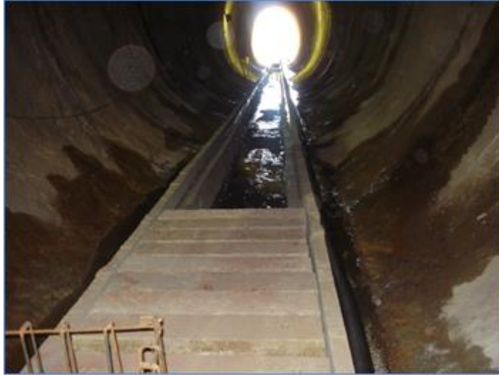
Figura 39 - Execução do sistema de drenagem
