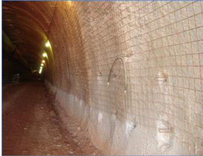
Figura 33 – Detalhe da tela
