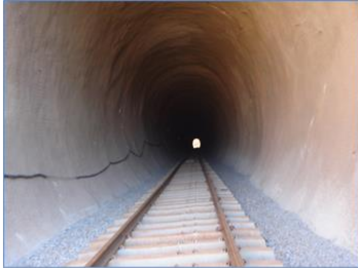
Figura 43 - Dormentes e trilhos instalados
