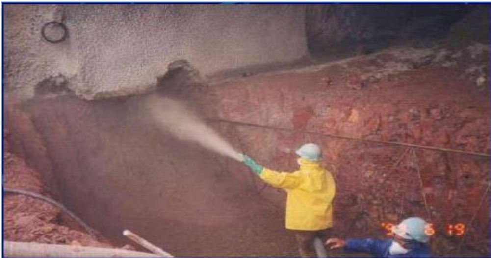
Figura 13 - Concreto projetado via seca
