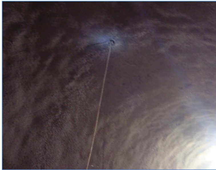
Figura 19 - Instrumentação, leitura de convergência
