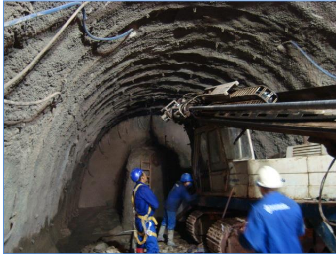
Figura 29 – Preparação para Detonação
