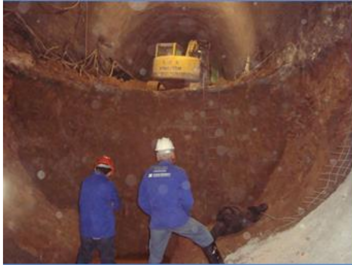
Figura 37 - Início das escavação do Arco Invertido
