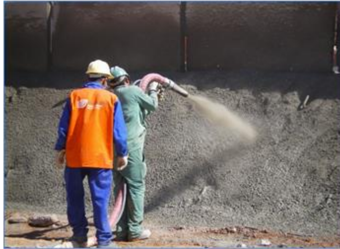
Figura 23 - Concreto projetado
