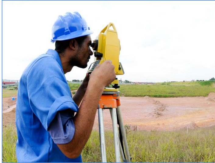
Figura - 15 - Topógrafo e Estação total
