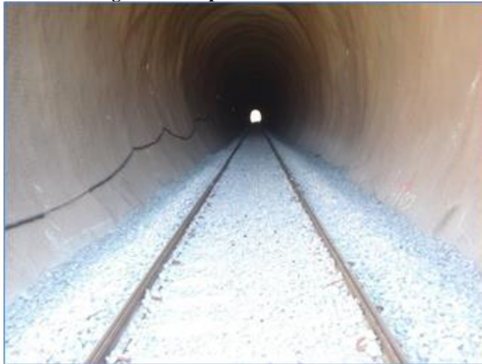
Figura 44 - Superestrutura Concluída
