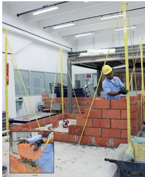
Figura 11 – Elevação de alvenaria com escantilhão
