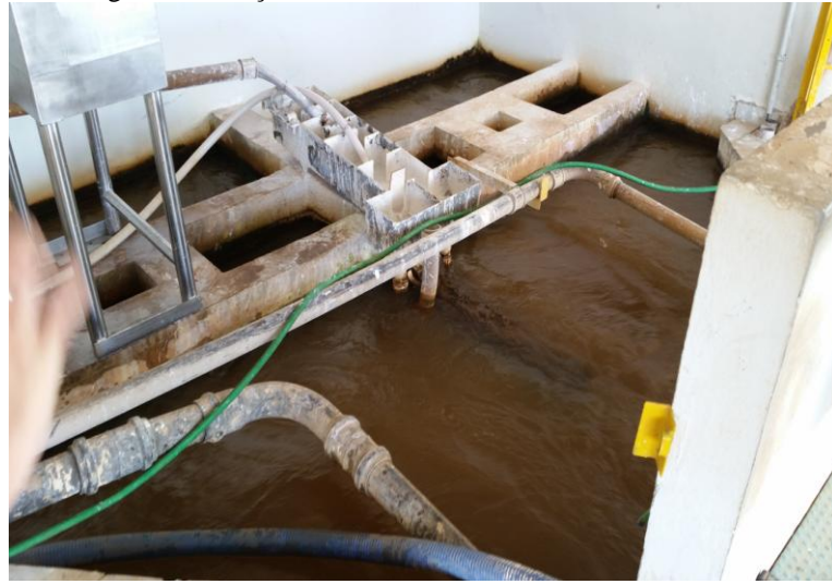
Figura 2 – Adição de Cal Hidratada e Sulfato de Alumínio
