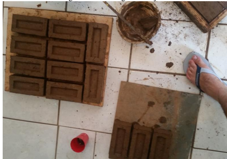
Figura 35 – Moldagem dos tijolos
