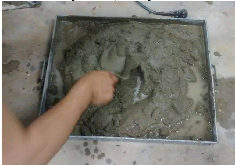
Figura 38 – Preparo da argamassa
