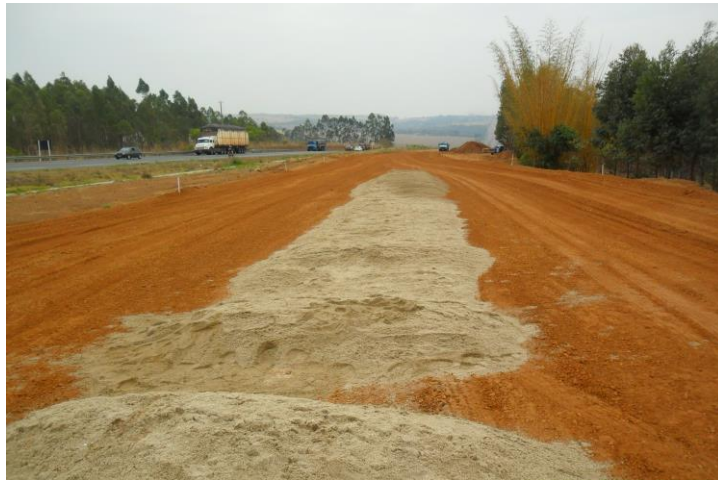
Figura 12 - Colocação da areia para a mistura.
