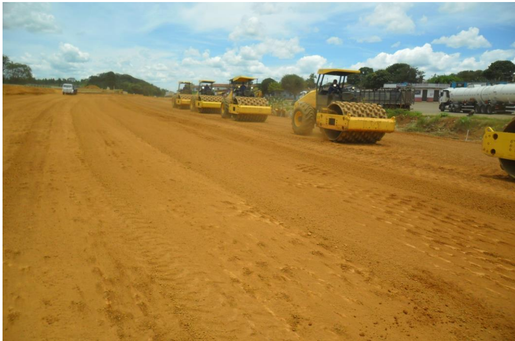
Figura 24 - Compactação através de Rolos Compactores.
