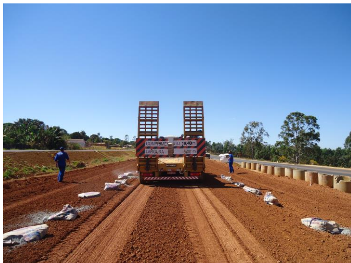
Figura 13 - Disposição de sacos de cimento.
