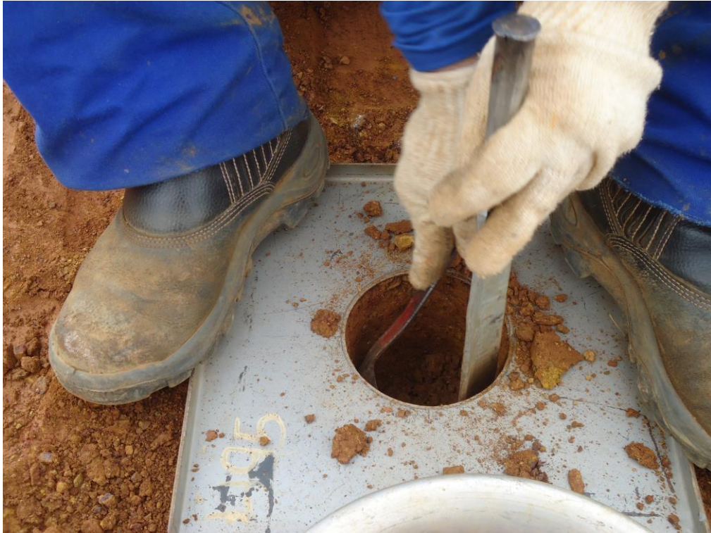
Figura 27 - Ensaio de densidade e umidade "in situ" 02.
