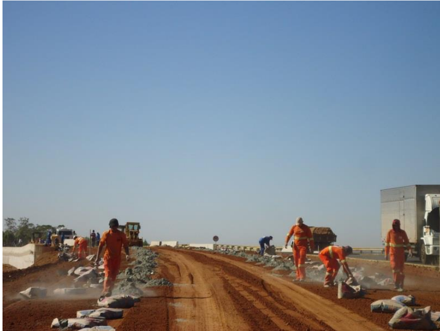
Figura 1 - Disposição de sacos de cimento na pista
