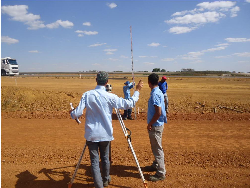
Figura 25 - Nivelamento da Base.
