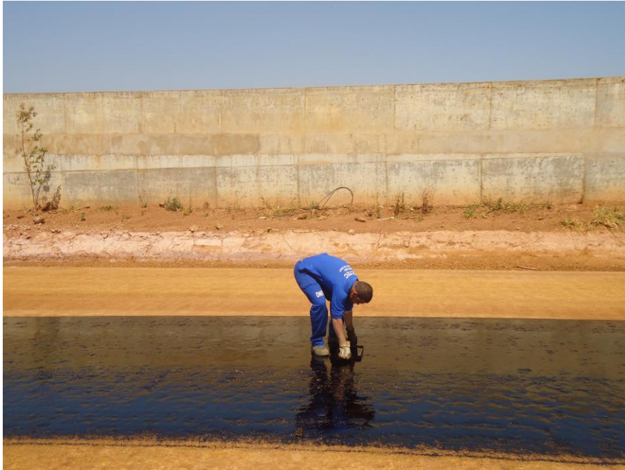
Figura 31 - Verificação da taxa de CM-30 por metro quadrado.
