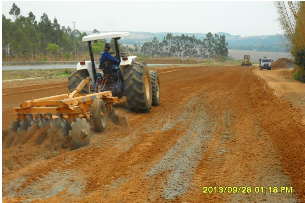
Figura 14 - Trator de grade homogeneizando o material.
