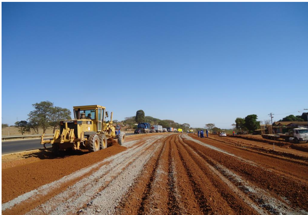
Figura 15 - Motoniveladora homogeneizando o material.
