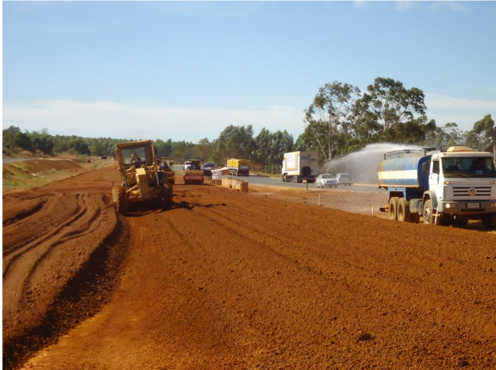
Figura 23 - Homogeneização e controle da umidade.
