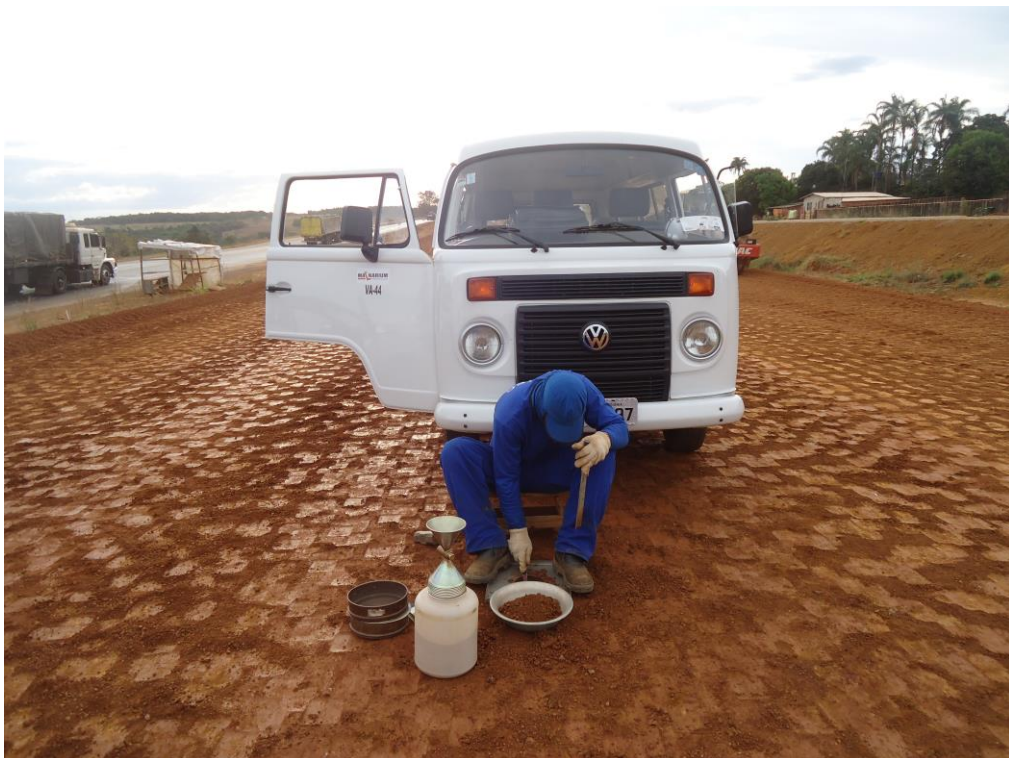
Figura 26 - Ensaio de densidade e umidade "in situ" 01.
