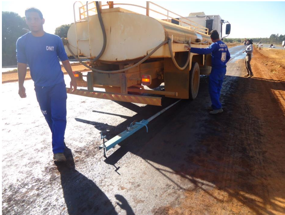
Figura 29 - Ensaio de Deflexão por Viga Benkelman.
