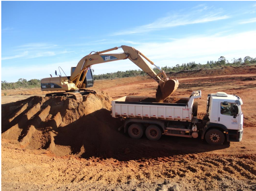
Figura 22 - Carga e transporte de material da jazida de cascalho.
