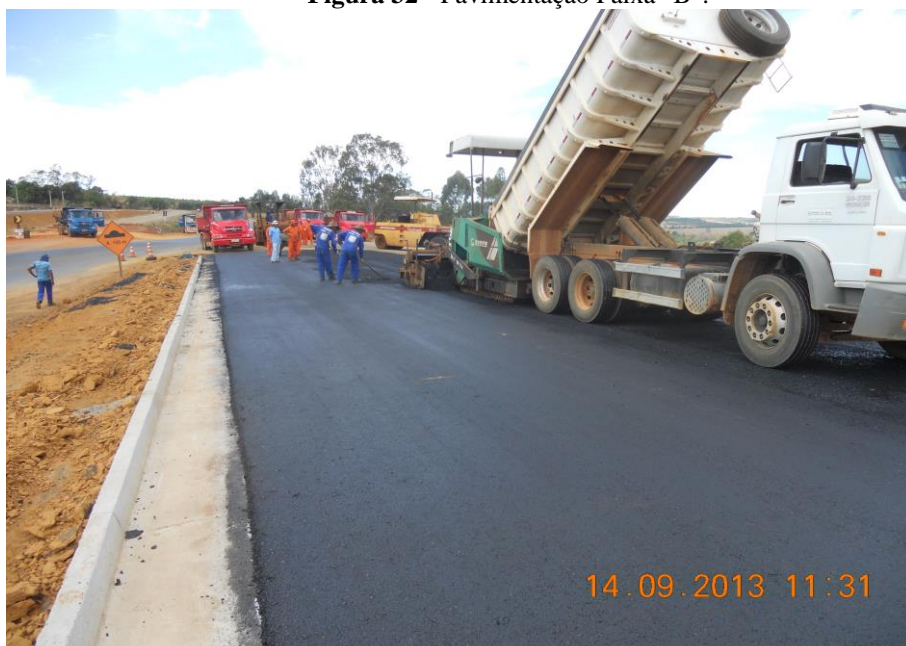
Figura 32 - Pavimentação Faixa "B".
