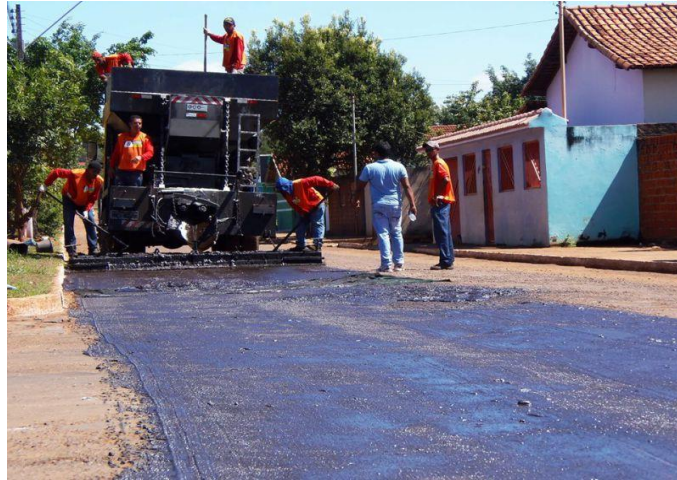
Figura 4 - Aplicação de Lama Asfáltica
