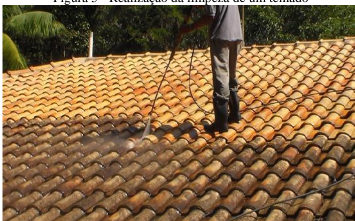
Figura 5 - Realização da limpeza de um telhado
