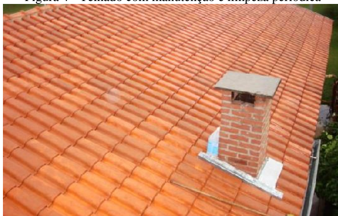
Figura 4 - Telhado com manutenção e limpeza periódica
