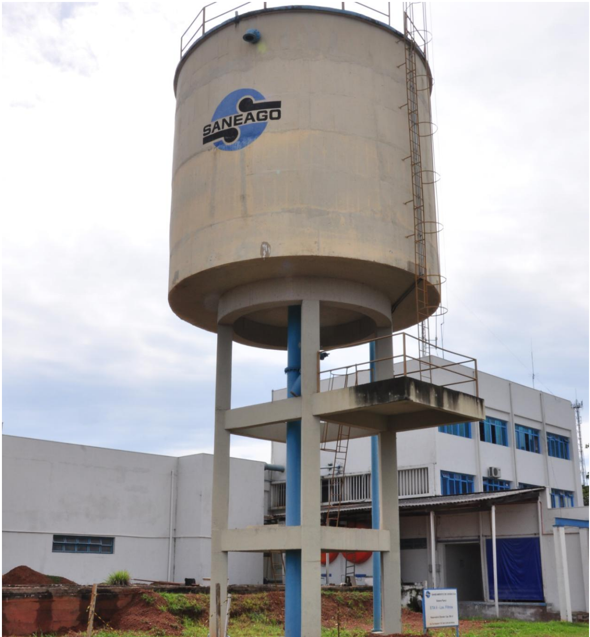
Figura 38 - Reservatório elevado ETA II - lavagem de filtros
