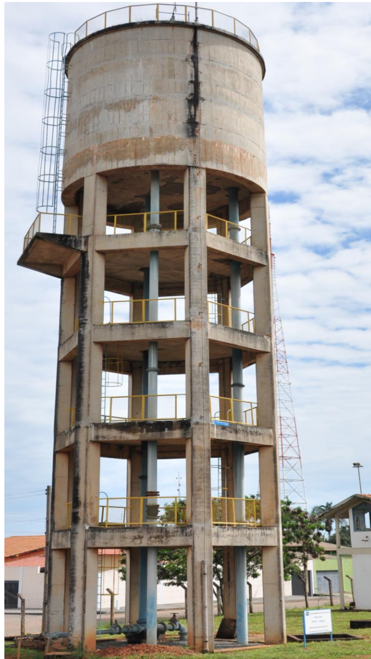
Figura 33 - Vista geral do reservatório elevado ETA I - Jaiara
