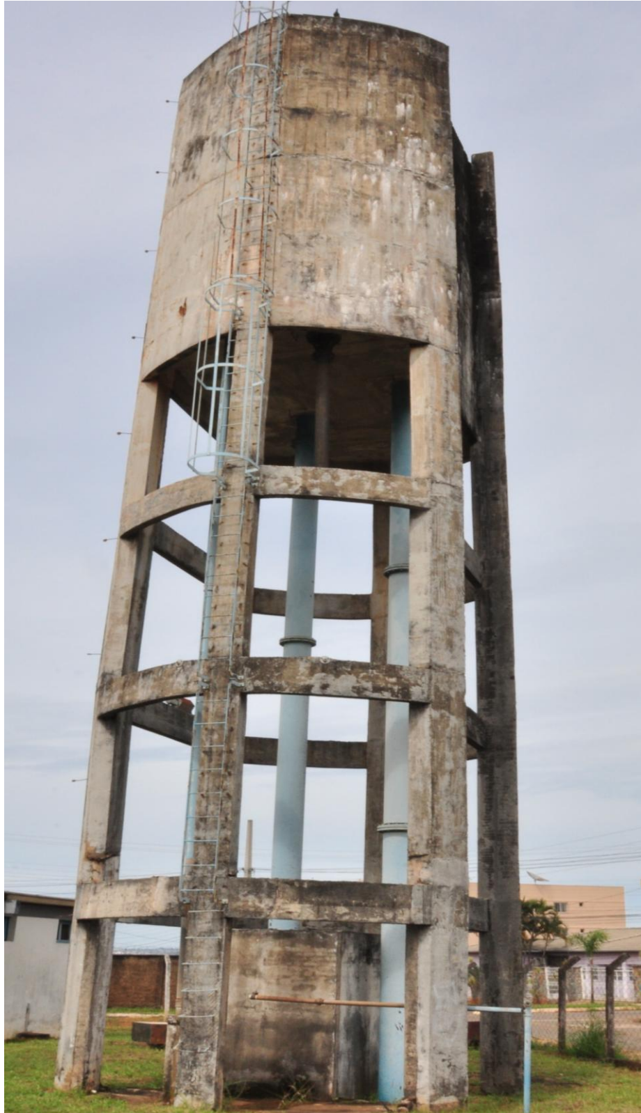
Figura 41 - Vista geral do reservatório desativado
