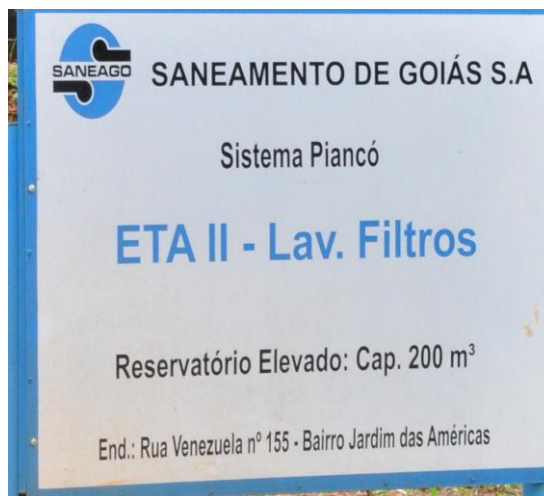
Figura 37 - Reservatório de lavagem de filtros
