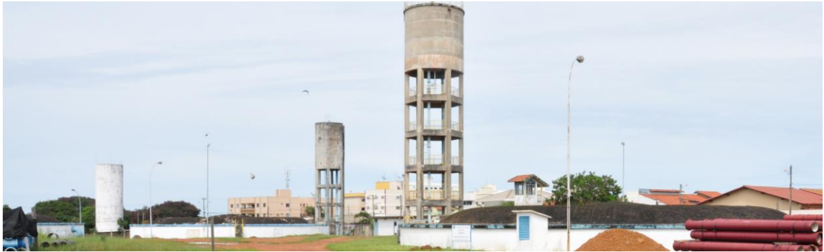
Figura 17 - Reservatórios da ETA - SANEAGO Anápolis
