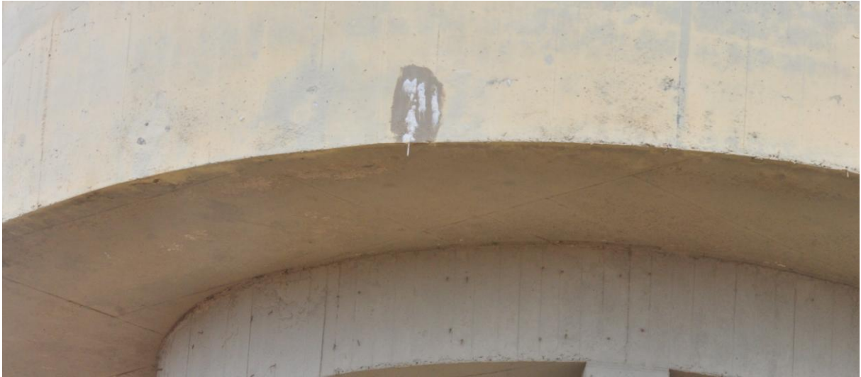
Figura 39 - Formação de estalactite no ETA II
