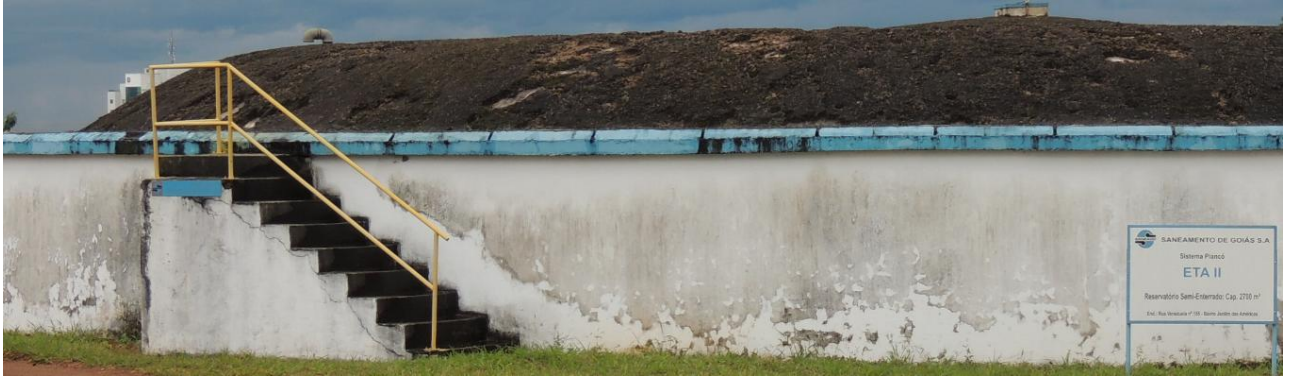
Figura 25 - Vista geral do reservatório ETA II - SANEAGO Anápolis
