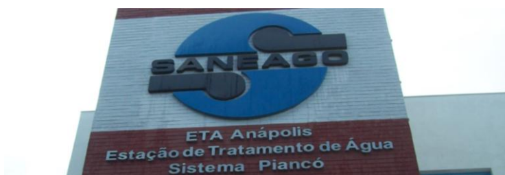
Figura 16 - Entrada da estação de tratamento de água da SANEAGO
