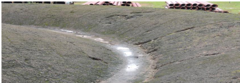
Figura 29 - Tampa do reservatório ETA III
