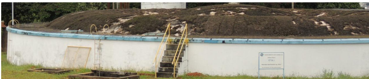
Figura 20 - Vista geral do reservatório ETA I - SANEAGO Anápolis
