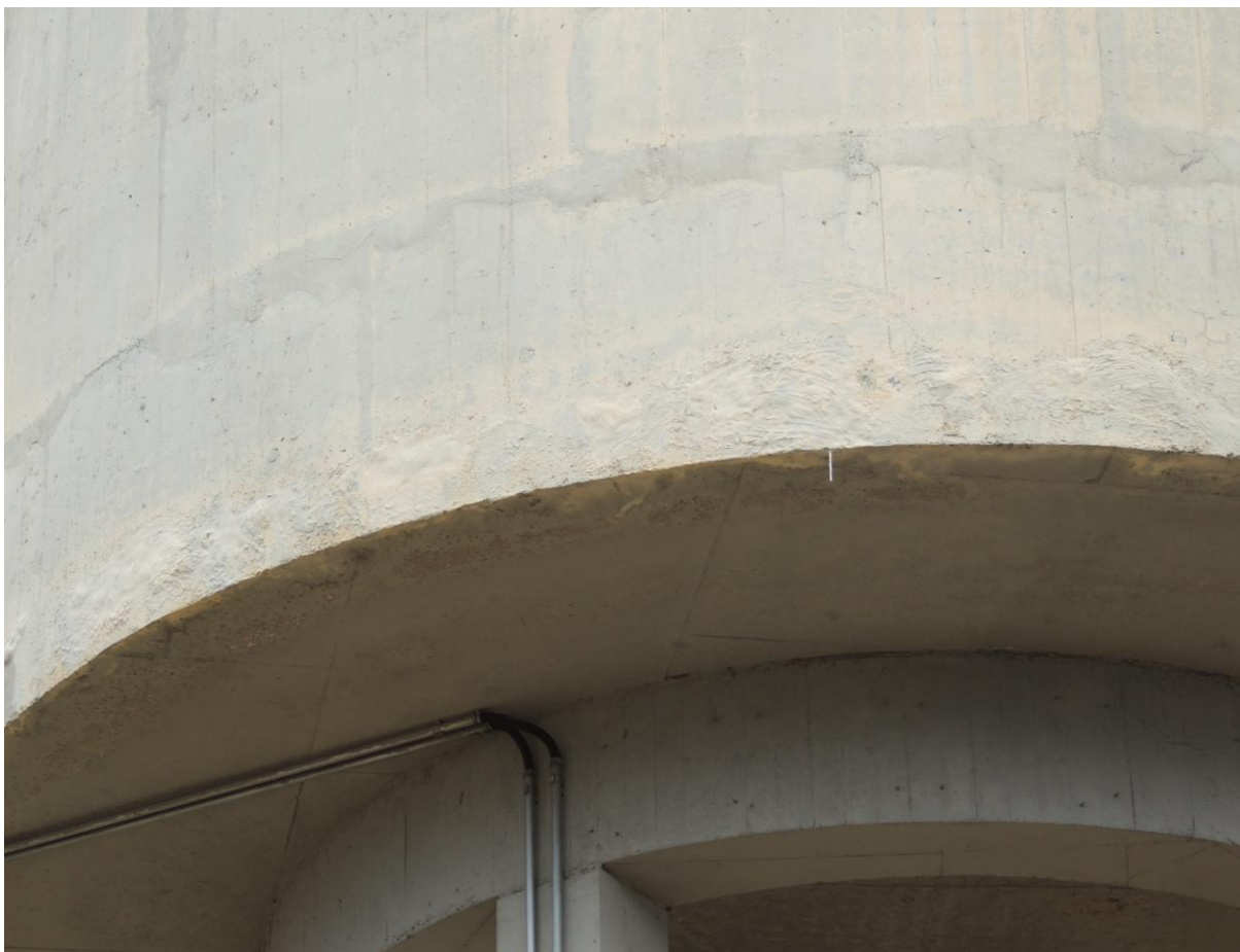
Figura 40 - Bolhas na superfície do ETA II
