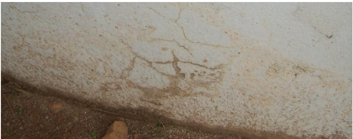
Figura 30 - Fissura próxima ao solo do ETA III
