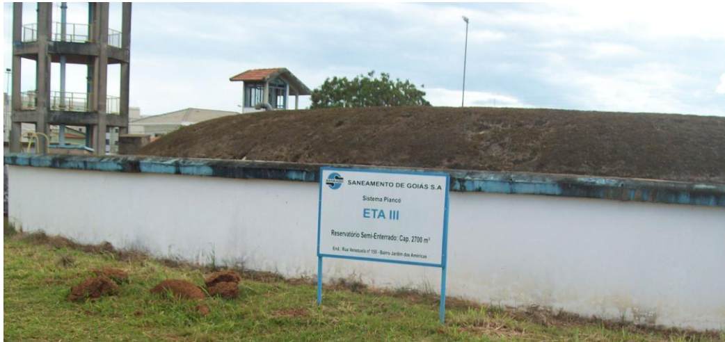
Figura 31 - Vista geral do reservatório ETA III
