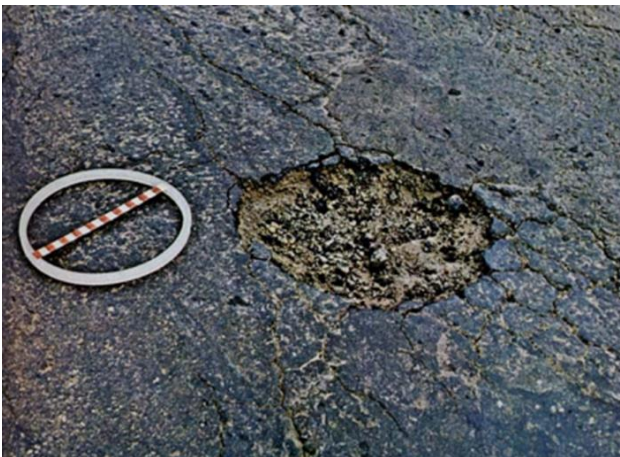
Figura 06 - Panela/Buraco
