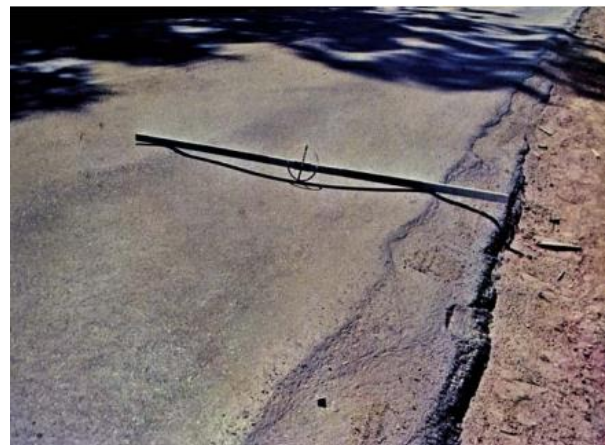
Figura 4 – Afundamento
