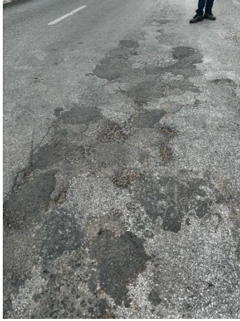
Figura 10 – Remendo.
