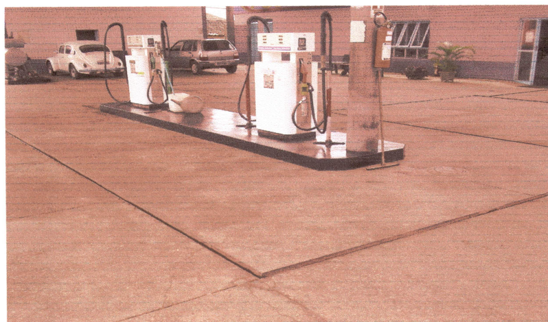
Figura 2: Canaletas na pista de abastecimento do Posto Duas Avenidas 2006.
