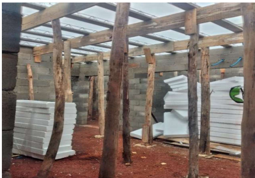
Figura 14: Montagem da laje.
