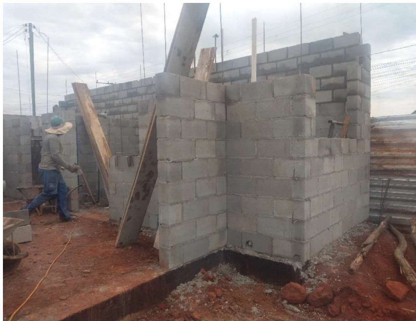
Figura 9: Execução da Alvenaria no térreo no 4º dia.
