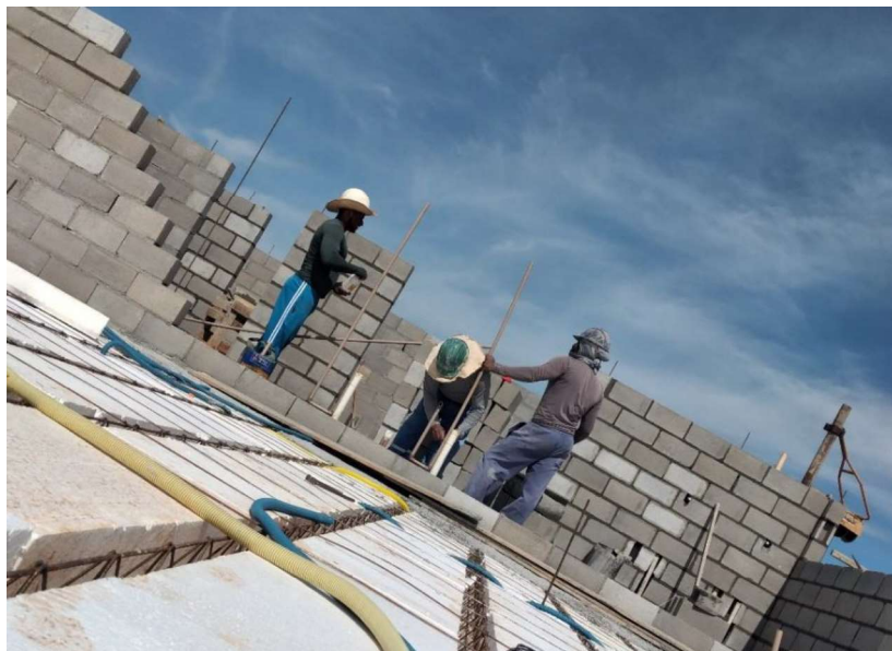
Figura 12: Execução da Alvenaria no segundo pavimento no 4º dia.
