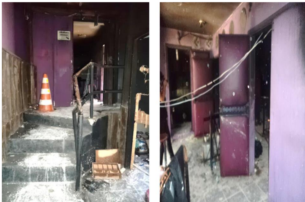
Figura 8 - Salão 1 - corredor de saída com escada e porta de saída de emergência
