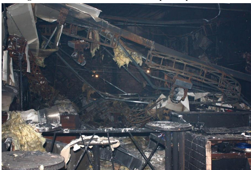
Figura 4 – Salão maior com visão do palco após o incêndio.
