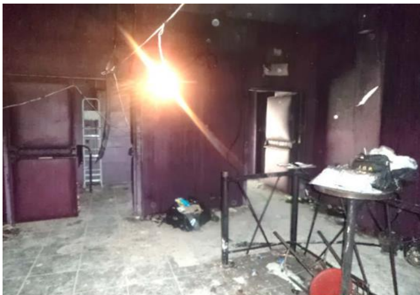
Figura 10 - Saída de emergência.
