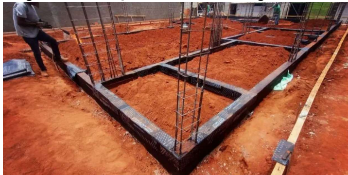
Figura 7 – Instalação das mantas nas vigas baldrame
