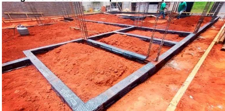
Figura 9 - Sistema de impermeabilização concluído
