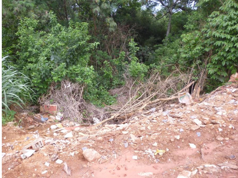
Figura 02 – Processos erosivos e declividade observadas na região da microbacia do córrego João Cesário em Agosto de 2014.
