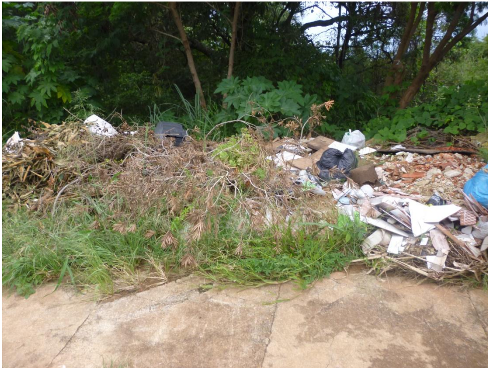
Figura 11 – Acúmulo de entulho, declividade e processos erosivos no setor de nascente do córrego Cesário.
