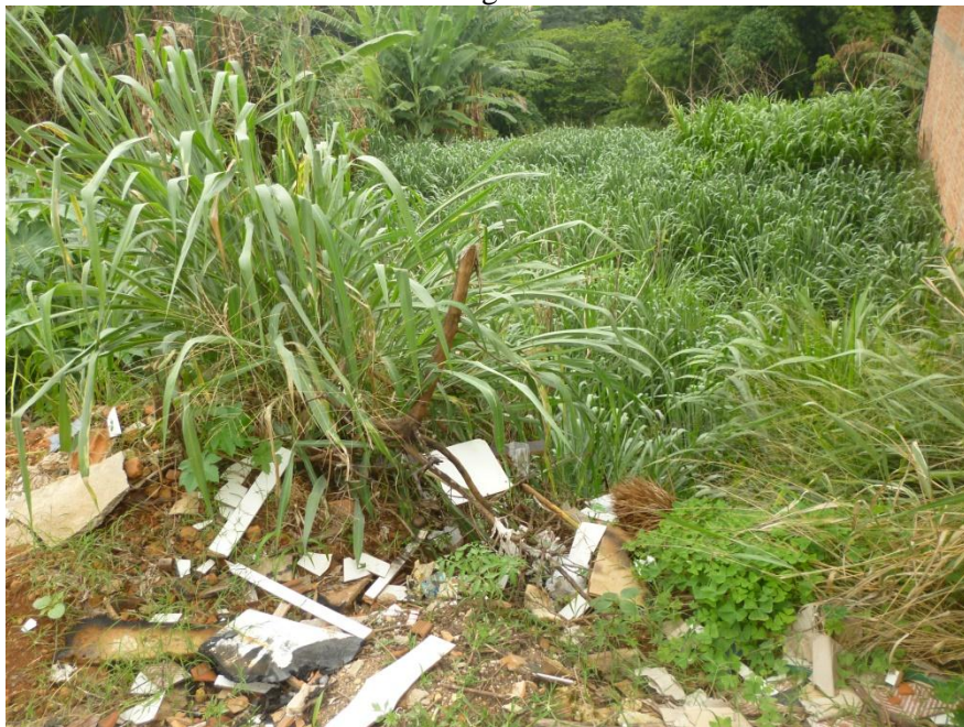
Figura 05 – Processos erosivos e declividade observadas na região da microbacia do córrego João Cesário em Agosto de 2014.
